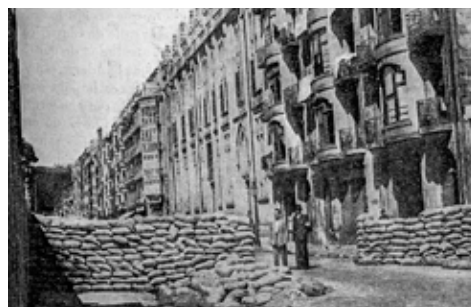
Barricada en el extremo sur de la calle Easo.
