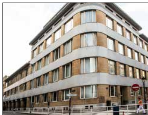
Edificio de la calle Easo, en el que el Conservatorio Municipal de Música compartió espacio con Bomberos, Guardia Municipal y Cuarto de Socorro. Actualmente está ocupado por el Conservatorio Profesional “Francisco Escudero” y oficinas municipales.
