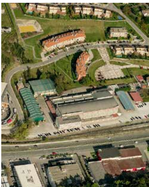
Polígono de Rekalde. (Fot. Diputación Foral de Gipuzkoa).
