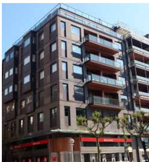
En la avenida de la Libertad gran parte de los edificios han sido sustituidos. En el caso de la fotografía (Avenida esquina Loyola), la fachada original de la sustitución presentaba cierto interés arquitectónico y aceptable adecuación con el entorno, siendo sustituida por otra fachada carente de las mencionadas características (se respetó la estructura interior del edificio).
