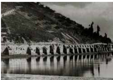
Acueducto de Morlans, reformado notablemente a mediados del siglo XIX. (Fot.: CC by SA Futxa Fototeka).
