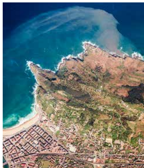
Vertido de la red de Saneamiento en la costa de Ulía (1997) antes de la implantación de la EDAR de Kapuene. Se observa cómo la playa de La Zurriola recibe parte del mismo. (Fot. Diputación Foral de Gipuzkoa).
