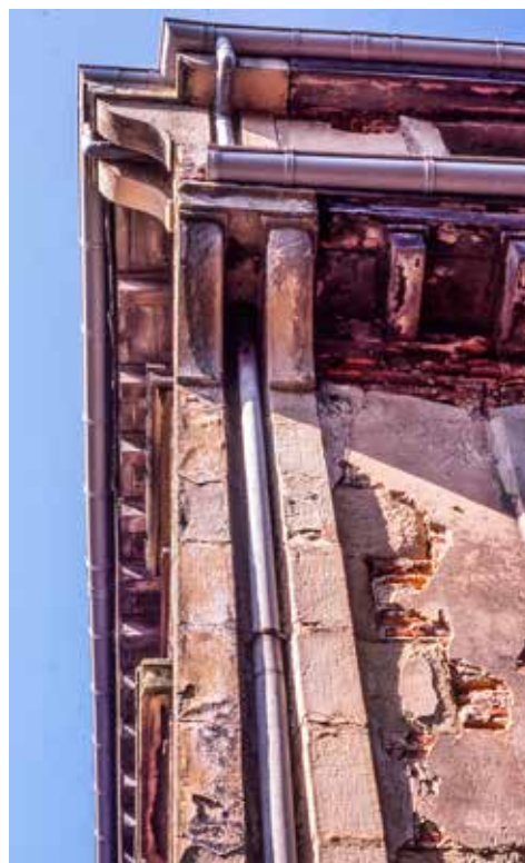
Bajante de aguas pluviales, similares en la mayor parte de los edificios (calle campanario)
