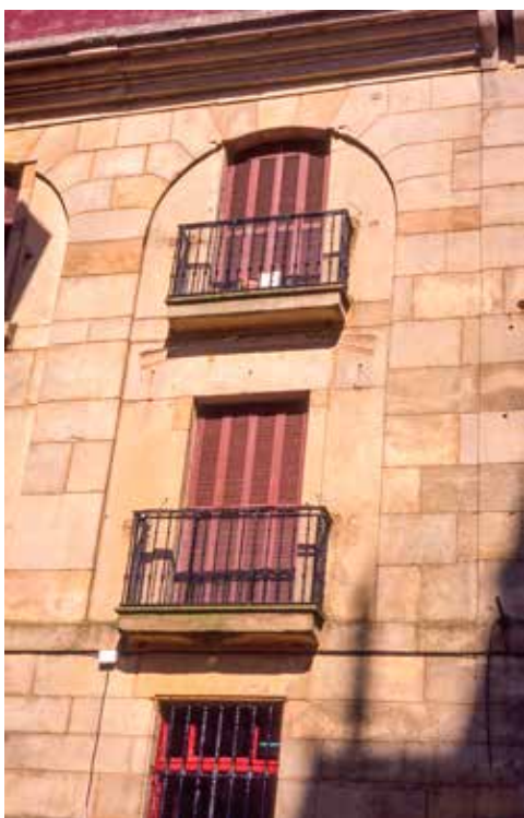
Edificio c/ Campanario, 2.
