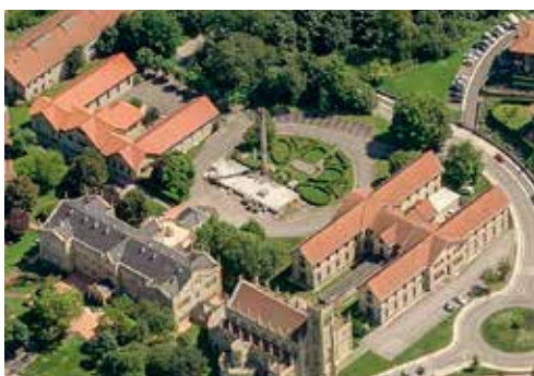
El Asilo benéfico de la Reina Victoria conserva todavía parte de sus edificios en pie. (Fot. Diputación Foral de Gipuzkoa).
