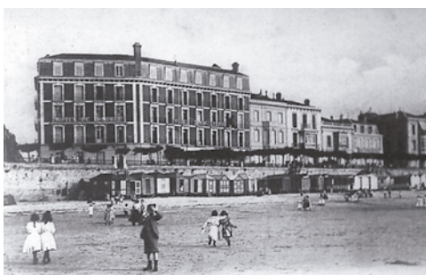
Paseo de la Concha, antes de ampliar el voladizo y colocar la nueva barandilla.
