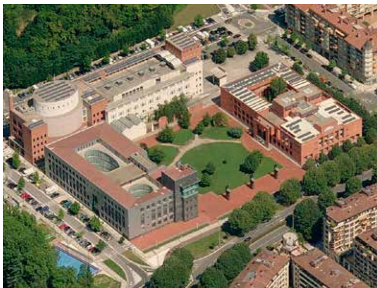
Parte del campus de Ibaeta de la Universidad del País Vasco. Antigua Escuela Universitaria de Magisterio, Facultad de Economía y Empresa y Escuela Superior de Arquitectura. (Fot. Diputación Foral de Gipuzkoa)
