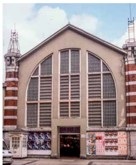
Fachada de la nave central del Mercado de San Martín (derribado).
