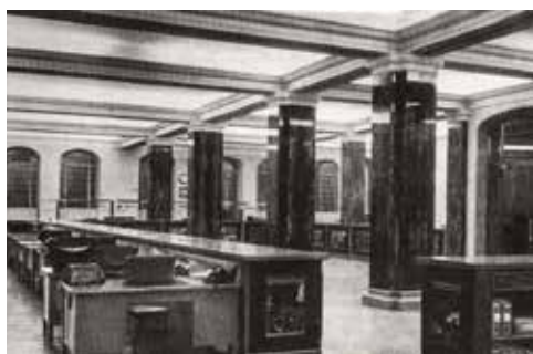
Patio de operaciones de la central de la Caja de Ahorros Municipal de San Sebastián en la calle Getaria. en 1963. (Fot. 100 años al servicio de Gipuzkoa....).
