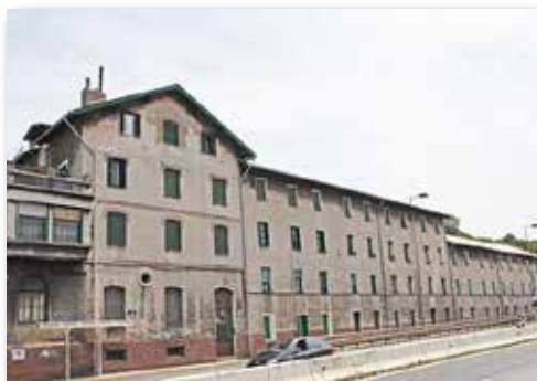
Viviendas para trabajadores de la planta Rezola de Añorga, derribadas en 2015.
