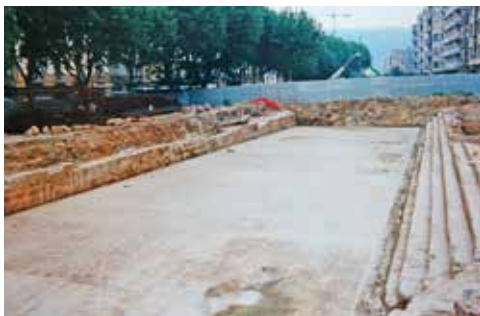
Excavación del frontón pegante a la muralla (dcha). Las gradas se aprecian a la izda.
