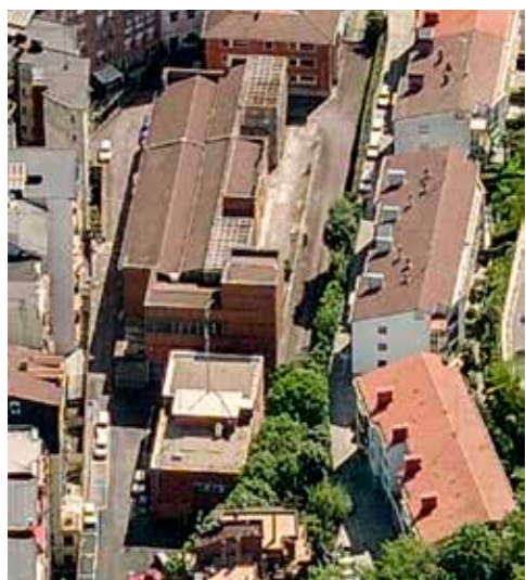
La subestación de Egia, rodeada por bloques residenciales, posee (como la de Trintxerpe) la mayor parte de sus instalaciones en el interior de un edificio. (Fot. Diputación Foral de Gipuzkoa).
