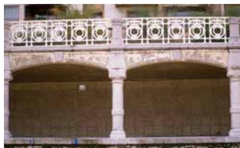
Voladizo de la Concha y nueva barandilla vista desde la playa.
