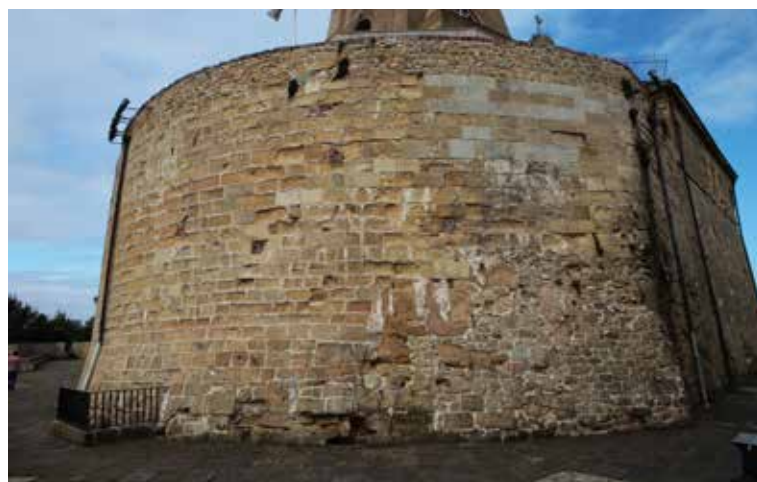
Castillo de Santa Cruz de la Mota, en la cima de Urgull. La parte redondeada se corresponde con el cubo de la Reina (s. XVI), posiblemente pegado a estructuras del antiguo castillo medieval, reformado en el siglo XVIII.
