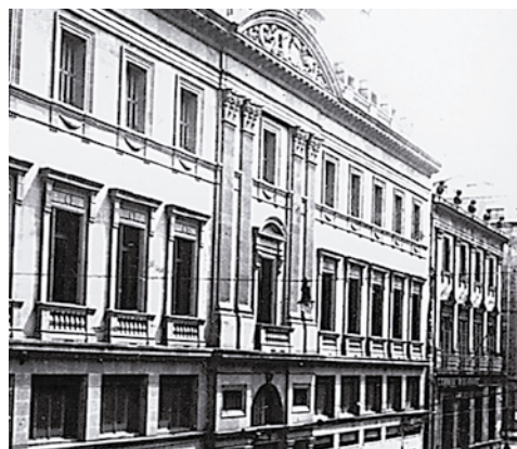
Sede de la Caja de Ahorros Provincial de Gipuzkoa en la Calle Garibai antes de la reforma. A la derecha se aprecia todavía el antiguo edificio de Correos y más antiguamente Escuela de Artes y Oficios. (Kutxa Fototeka. CC by SA).
