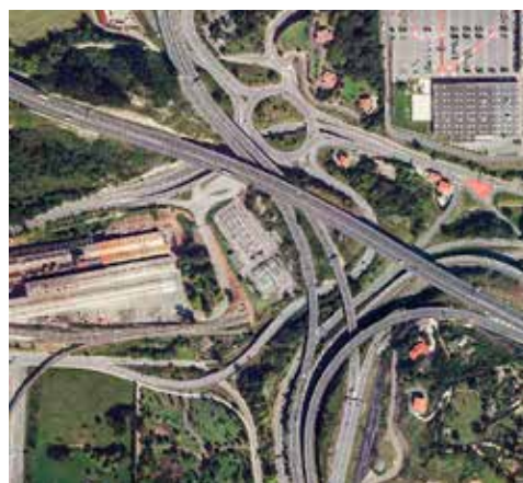
Nudo de carreteras en el límite de San Sebastián con Usurbil (AP-1 + N 634 + NI + GI-2132. (Fot.: Diputación Foral de Gipuzkoa)
