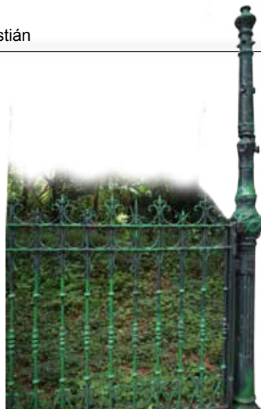
Verja de cierre de la Plaza de Gipuzkoa, ahora cerrando los antiguos viveros de Ategorrieta.
