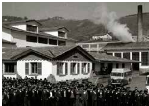
Instalaciones de Gurelesa en Igara, hacia 1960. (Fot. Paco Mari. Kutxa Fototeka, CC by SA).
