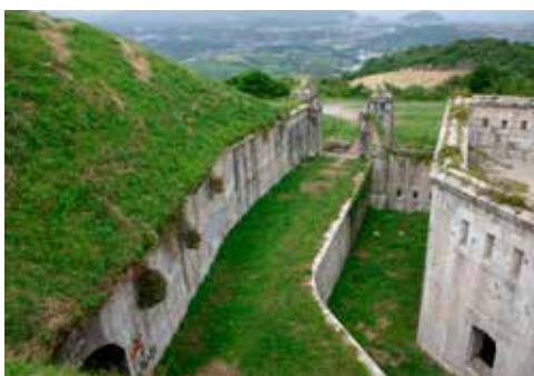
Fuerte de Txoritokieta. A la derecha, el cuartel, al fondo, el acceso y ala izquierda el gran través que contiene abrigos y repuestos.
