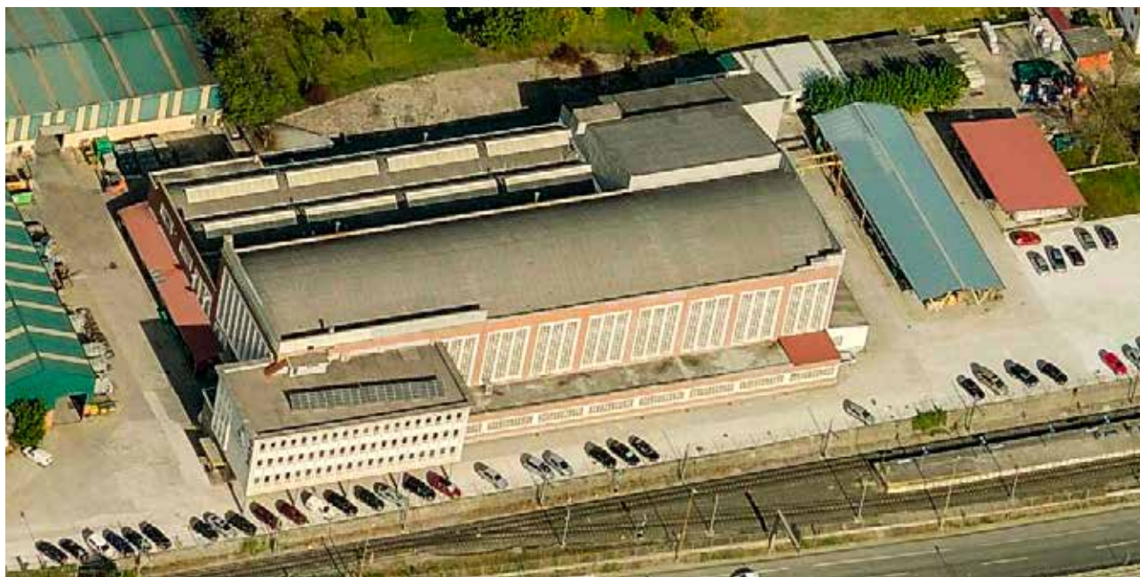
Transformadores OASA (cerrada en 2015), en el barrio de Rekalde (Fot. Diputación Foral de Gipuzkoa).
