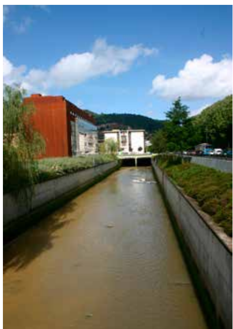
La regata Añorga, ya canalizada, en su último tramo al descubierto. Al final se observa el inicio del cubrimiento, en el entorno del campus universitario.
