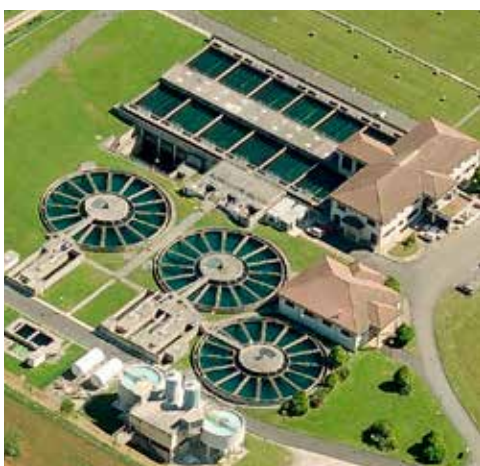
Depuradora (ETAP) de Petritegi. (Fot. Diputación Foral de Gipuzkoa).
