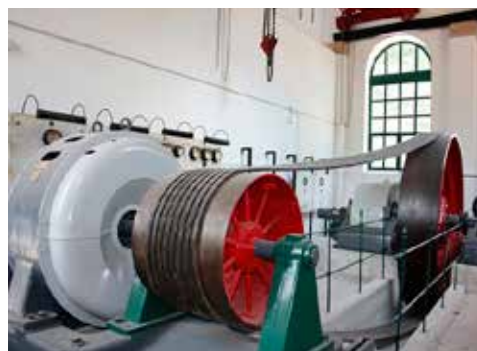
Gasomotor conservado en el edificio reconstruido de la Fábrica de Gas. Es un elemento protegido del patrimonio industrial donostiarra destinado a producir energía eléctrica utilizando gas como combustible.
