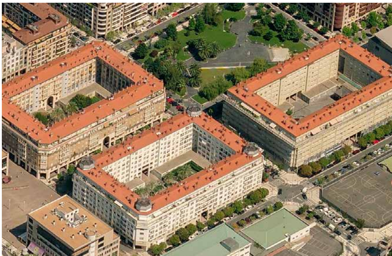
Tres bloques de viviendas de Protección Oficial en "Antigo-Berri" (Fot. Diputación Foral de Gipuzkoa).
