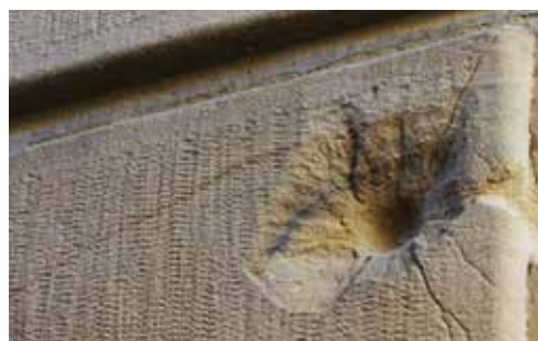
Impacto de un proyectil de fusil en un sillar de arenisca próximo a una ventana del hotel "María Cristina", en el centro de San Sebastián.
