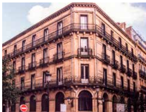
Edificio construido en la calle Getaria por la Compañía Eléctrica de San Sebastián. Hasta el año 2002 fue la sede guipuzcoana de Iberduero / Iberdrola. Fue rehabilitado en el año 2006, añadiéndole varias plantas.
