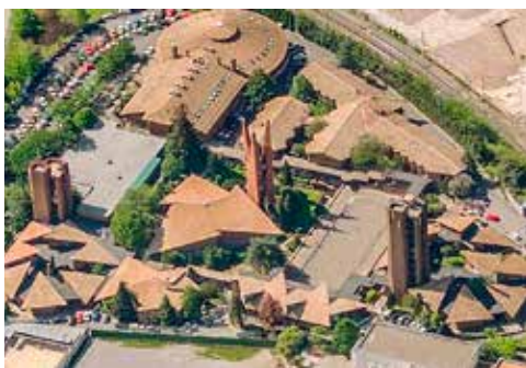
Vista del campus de San Sebastián de la Universidad de Deusto (antiguos EUTG), antes del derribo parcial para su sustitución por otros edificios (Fot. Diputación Foral de Gipuzkoa).
