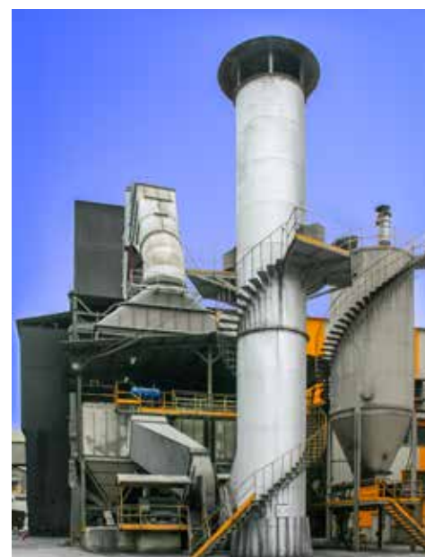
Vista parcial de las instalaciones de la fábrica Rezola de Añorga (Italcementi).
