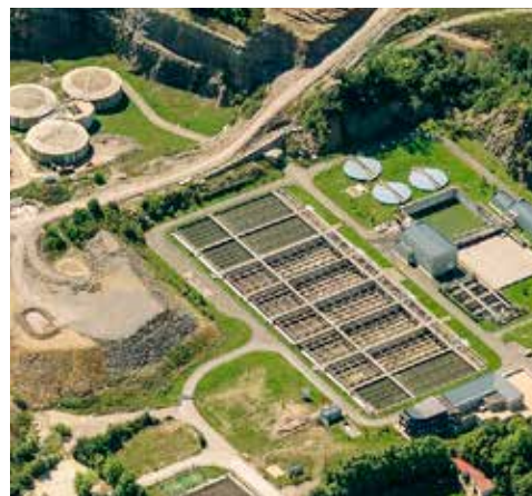
Estación Depuradora de Aguas Residuales, en Kapuene (Loiola). (Fot. Diputación Foral de Gipuzkoa).
