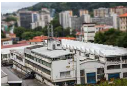
Planta de Zardoya-Otis, en el barrio de Altza. Está previsto su traslado a Zubieta.
