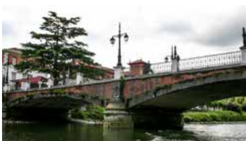
Puente de los cuarteles de Loyola.
