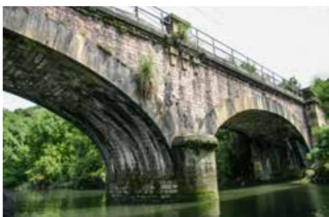
Puente del Ferrocarril a la Frontera francesa (puente del "Topo"), demolido y sustituido por otro sin apoyos en el cauce del Urumea.
