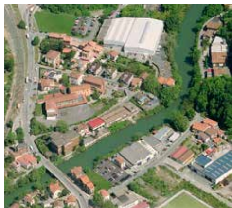
El Urumea a su paso por el barrio de Martutene. (Fuente: Diputación Foral de Gipuzkoa).
