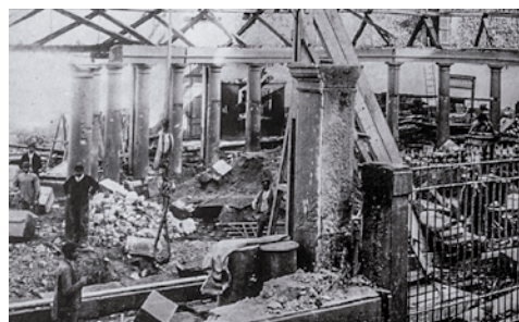
Primer edificio de la Pescadería, en derribo.
