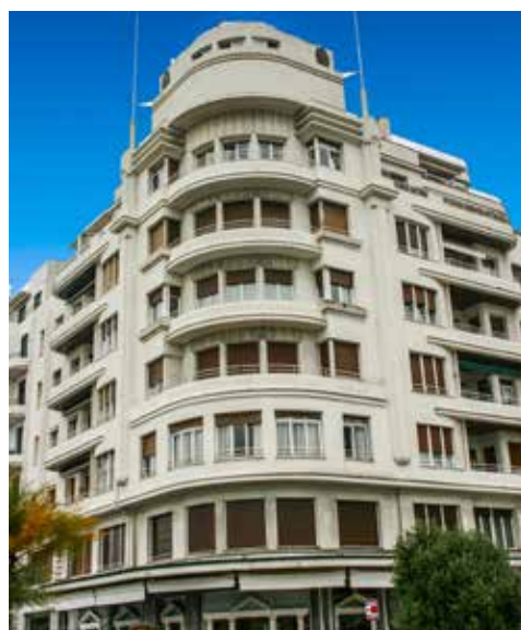
Edificio "La Equitativa", algo modificado.
