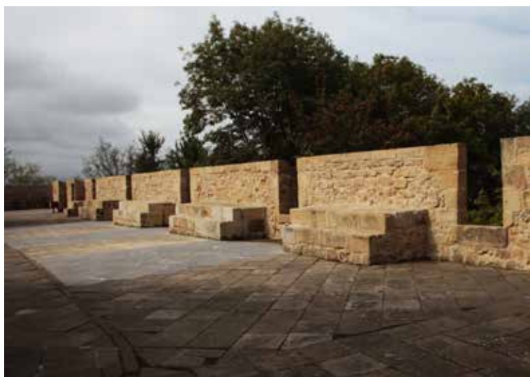
Castillo de Santa Cruz de la Mota. Sucesión de cañoneras y merlones, con las banquetas para el disparo de fusilería por encima del parapeto.
