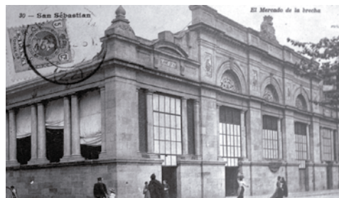
El desaparecido segundo edificio de la Pescadería de la Brecha.
