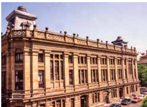
Fachada posterior de la Audiencia Provincial de Gipuzkoa.
