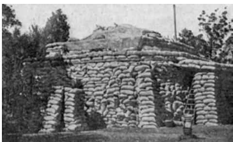
Fortificación de campaña, levantada probablemente revistiendo de sacos terreros los urinarios del Parque de Amara.
