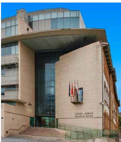
Palacio de Justicia de la Plaza de Teresa de Calcuta (antiguas escuelas y hospital militar rehabilitados)
