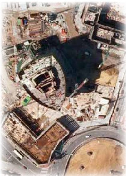
Ortofo 2009; geoEuskadi. La Torre en construcción.
