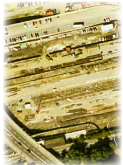
Ortofoto 2002; geoEuskadi. Previamente al inicio de la obra.
