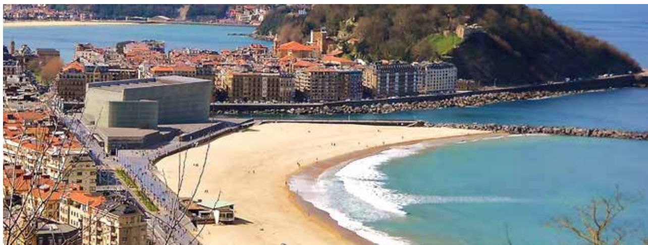
Playa de la Zurriola vista desde el monte Ulía, con la remodelación ya ejecutada.
