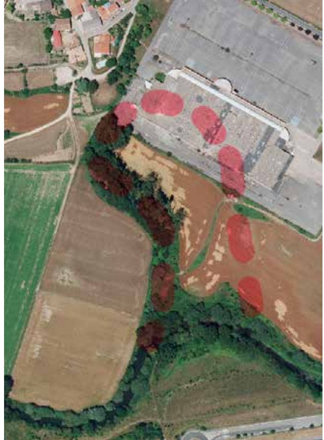
Ortofoto 2015. Fuente: Eusko Jaurlaritza / Gobierno Vasco; geoEuskadi. El meandro de Astegieta desviado tras realizar una actuación para liberar suelo para la instalación de una gran superficie comercial, actualmente abandonada.
