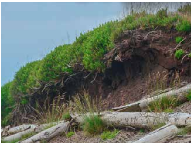
Un sector de la turbera protegida por una malla geotextil asegurada mediante troncos se aprecia también la turba formando un fibazo y la vegetación que la recubre. Fuente: Ura- ren Euskal Agentzia / Agencia Vasca del Agua. CCby-SA.
