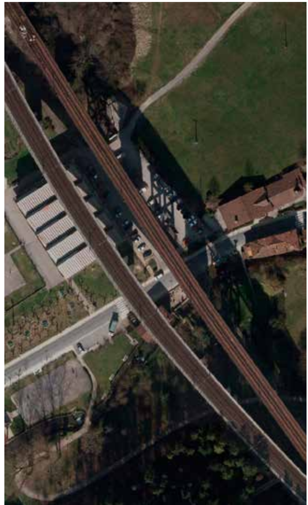
Ortofoto urbana 2007-2009. Fuente: Eusko Jaurlaritza / Gobierno Vasco; geoEuskadi. Coordenadas: UTM 30N ETRS89 // X: 560325.7091 // Y: 4765807.0819 // Z: 204 m. A la derecha se aprecia el viaducto histórico y a la izquierda la variante ferroviaria realizada en 1995.
