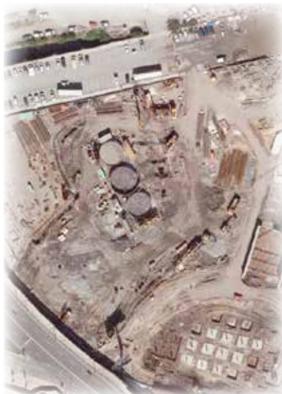
Ortofoto 2007; geoEuskadi La Torre en el proceso de cimentación
