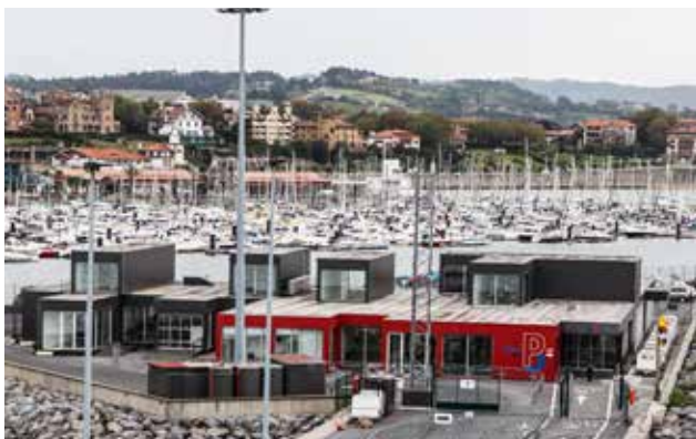
Estación marítima de Getxo.
