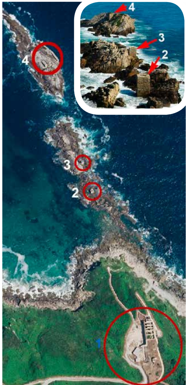
Ortofoto 2015. Fuente: Eusko Jaurlaritz-G. Vasco; geoEuskadi. UTM 30N ETRS89 // X: 569012 m // Y: 4793923 m. Cargadero de Malla Arria (Mollarri). 1 Estación final del teleférico, depósito y cargadero terrestre. 2 y 3 estructuras del teleférico que unía el cargadero terrestre con el cargadero marítimo. 4 Soportes del cargadero marítimo de tipo Cantilever y del teleférico final.
