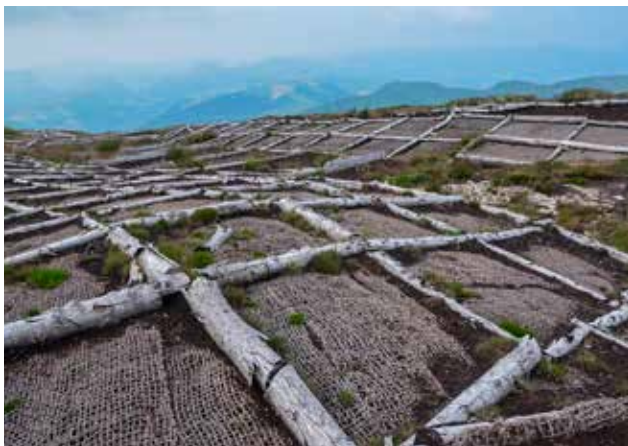
Un sector de la turbera protegida por una malla geotextil biodegradable asegurada mediante troncos. Fuente: Ura-ren Euskal Agentzia / Agencia Vasca del Agua. CCbySA.
