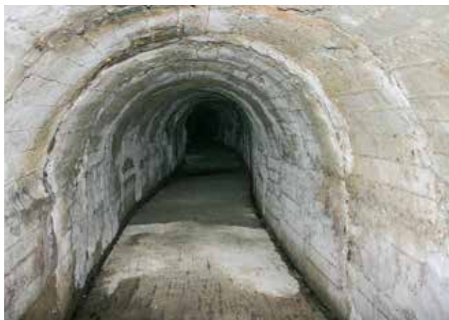
Galería general de acceso al Puesto de Mando y a diversos nidos.
