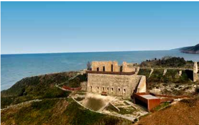
El cargadero terrestre (estaciones de llegada y salida de los funiculares industriales y depósito de mineral) fue restaurado e incorporado un pequeño centro de interpretación.
