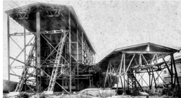
Estación de derivación de Putxeta. La estructura de la izquierda corresponde a la línea principal y la de la derecha a la derivación hacia el ferrocarril. Fuente: Photographs of aerial ropeways and Pobeña washery, Erected April 1909-October 1910. Orconera Iron Ore Company Limited.
