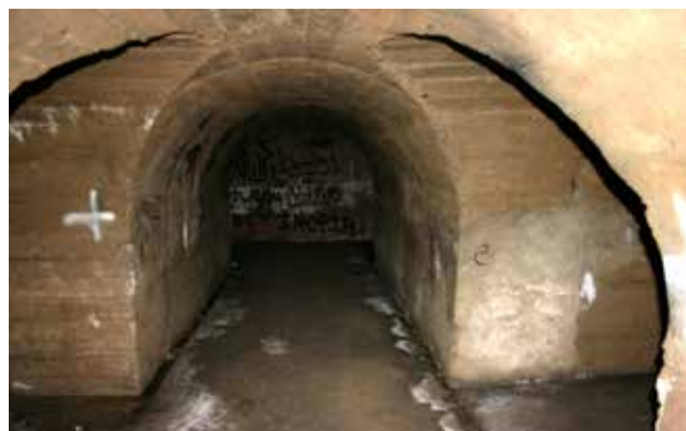
Puesto de mando. A izquierda y derecha accesos a dependencias de 12 m de longitud.
