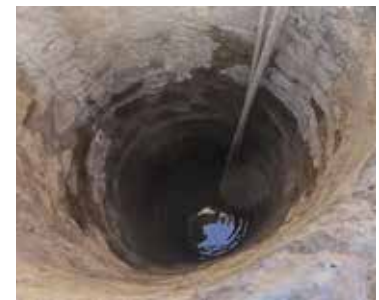
Interior del pozo.
