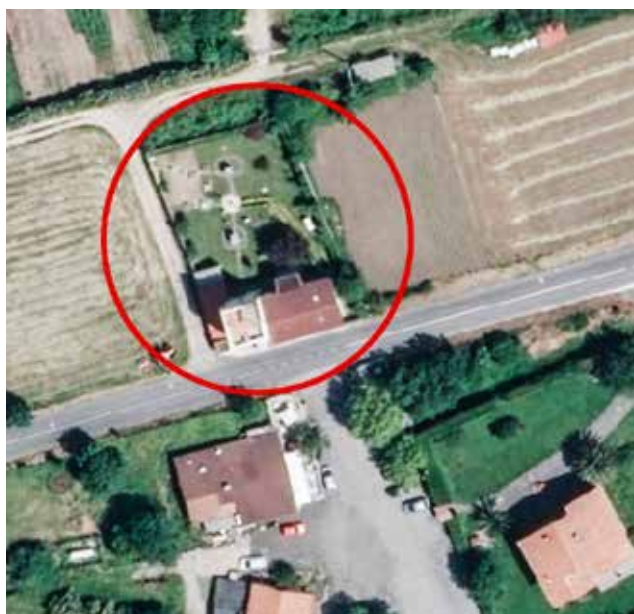
Ortofoto 2015. Fuente: Eusko Jaurlaritza-G. Vasco; geoEuskadi. Se aprecia perfectamente la torre de planta cuadrada y el espacio ajardinado donde están instalados diferentes sensores meteorológicos.
