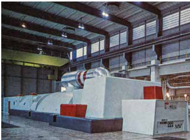
El turboalternador de la central térmica fue instalado con una potencia nominal de 240.000 kW.
