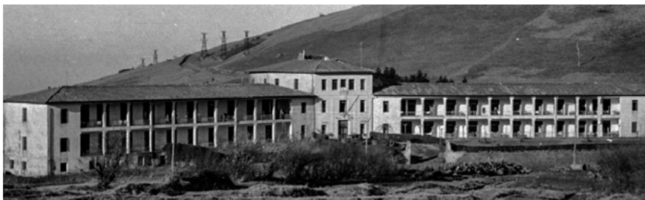
Fachada meridional del sanatorio, donde se abrían las terrazas de las habitaciones. En 1943 cuando fue obtenida la fotografía todavía estaba en funcionamiento. Fot. Vicente Martín (Fondo Foto Car) Fuente: Kutxa Fototeka CC by SA..
