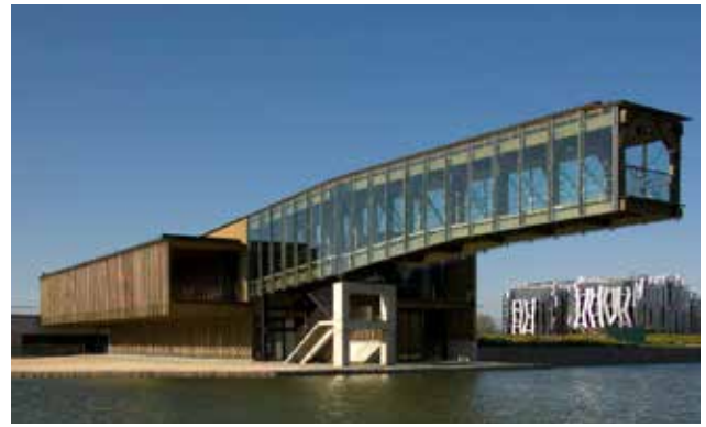
"Ataria", Centro de interpretación de la Naturaleza de Salburua. Interesante obra arquitectónica (2009), obra de los arquitectos José María García del Monte, Ana María Montiel y Fernando García Colorado.
