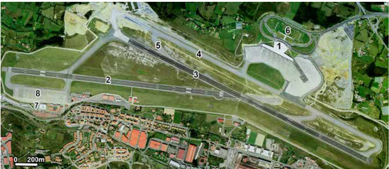
Ortoargazkia 2002. UTM 30N ETRS89 // X: 506920 m // Y: 4794412 m. Terminal berria adierazten duen lehenengo ortoargazkia. Errodadura kalea handitzen ari dira. 1.: Terminala. 2. 10/28 pista (pista zaharra). 3. 12/30 pista (pista nagusia). 4. Errodadura pista. 5. Pista nagusira errodadura pistatik bizkor sartzeko bidea. 6. Lurpeko aparkalekua. 7. Terminal zaharra (gaur egun zama-lanetarako eta abiazio pribatutarako). 8. Hegoaldeko aparkaleku plataforma (nagusiki helikopteroak eta merkataritzakoa ez den abiazioa). Iturria: Eusko Jaurlaritz / Gobierno Vasco; geoEuskadi.
