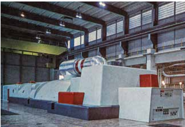
Zentral termikoaren turboalternadorea instalatu zen 240.000 kW potentzia nominalarekin.
