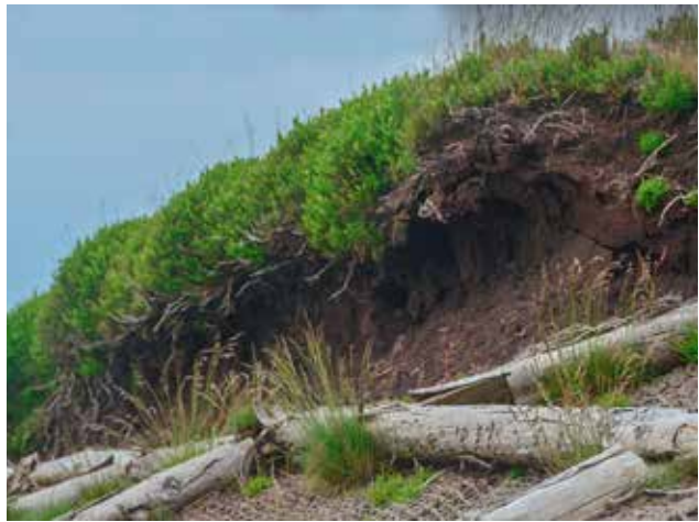
Sare geotestil batek babestutako zohikaztegiaren sektore bat, enborren bidez finkatuta, zohikatza ere ikus daiteke fibazo bat sortuz eta baita hura estaltzen duen begetazioa ere. Iturria: Uraren Euskal Agentzia / Agencia Vasca del Agua. CCbySA.
