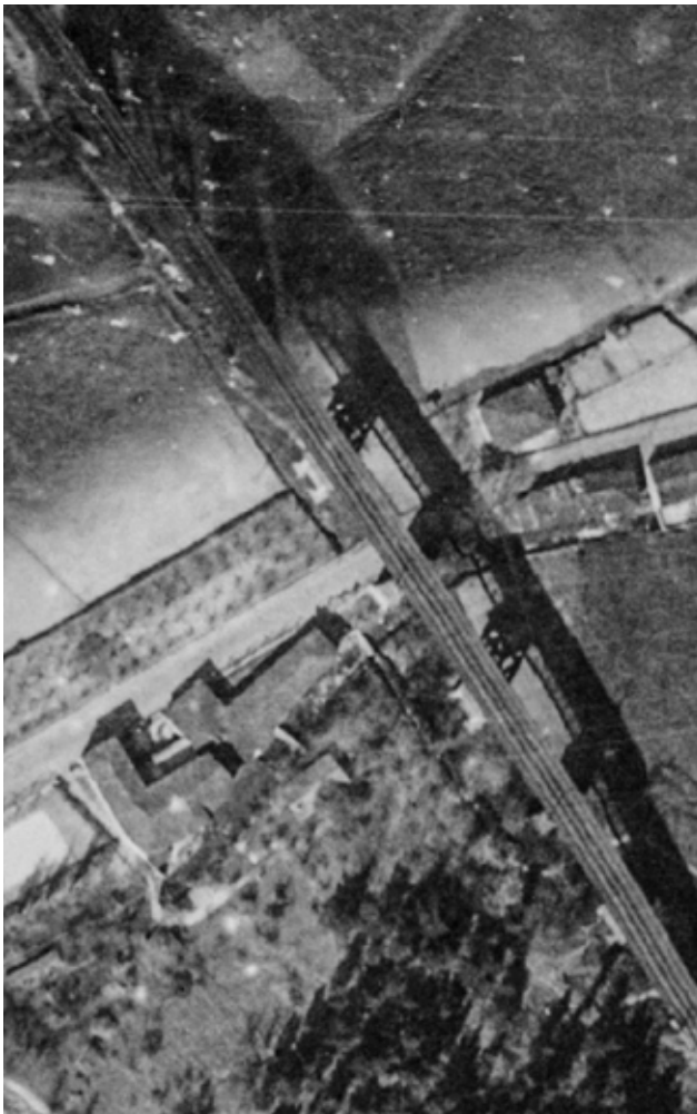
Ortoargazkia 1954. Iturria. Eusko Jaurlaritz / Gobierno Vasco; geoEuskadi. Gipuzkoako Foru Aldundia / Diputación Foral de Gipuzkoa. Biaduktua ikus daiteke eta proiektatutako itzalari esker jatorrizko pilak (trinkoak) eta 1941ean sendotzeko gehitutakoak desberdindu daitezke.
