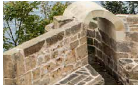
Garita, parcialmente restaurada.
