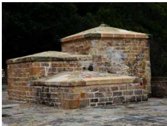
Edificio que protege la escalera de comunicación con la bóveda inferior.
