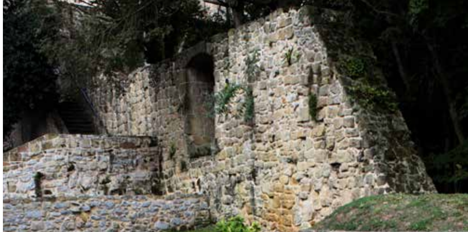
Muralla oriental de Villaturiel (?). Tramo 1 y 2. Entorno del acceso oriental al Castillo.
