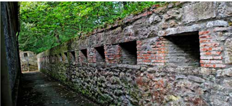
Parapeto de fusilería en torno al cuerpo de guardia.
