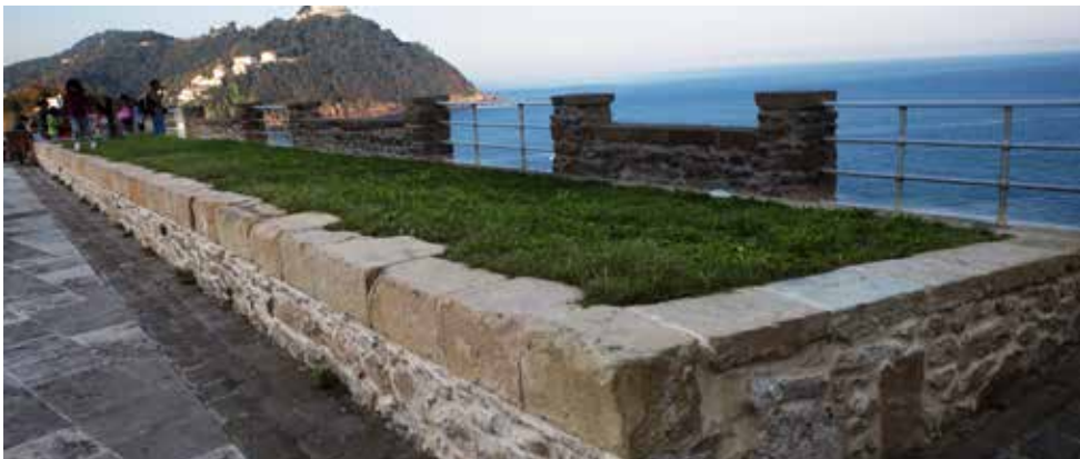
La disposición actual de los elementos de la batería no tiene nada que ver con el original, prevaleciendo la función de mirador.
