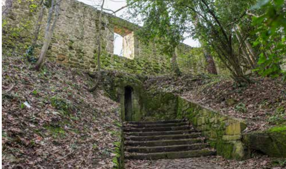
Escalinata de acceso a la poterna desde el camino del Viacrucis. El muro situado sobre ella corresponde probablemente a las murallas de Villaturiel.
