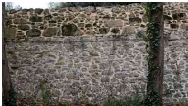
Muro visto por la parte de la campaña. Se aprecia claramente un cambio de aparejo, probablemente debido a que en 1865 se recreó el muro de contención aspillerándolo
