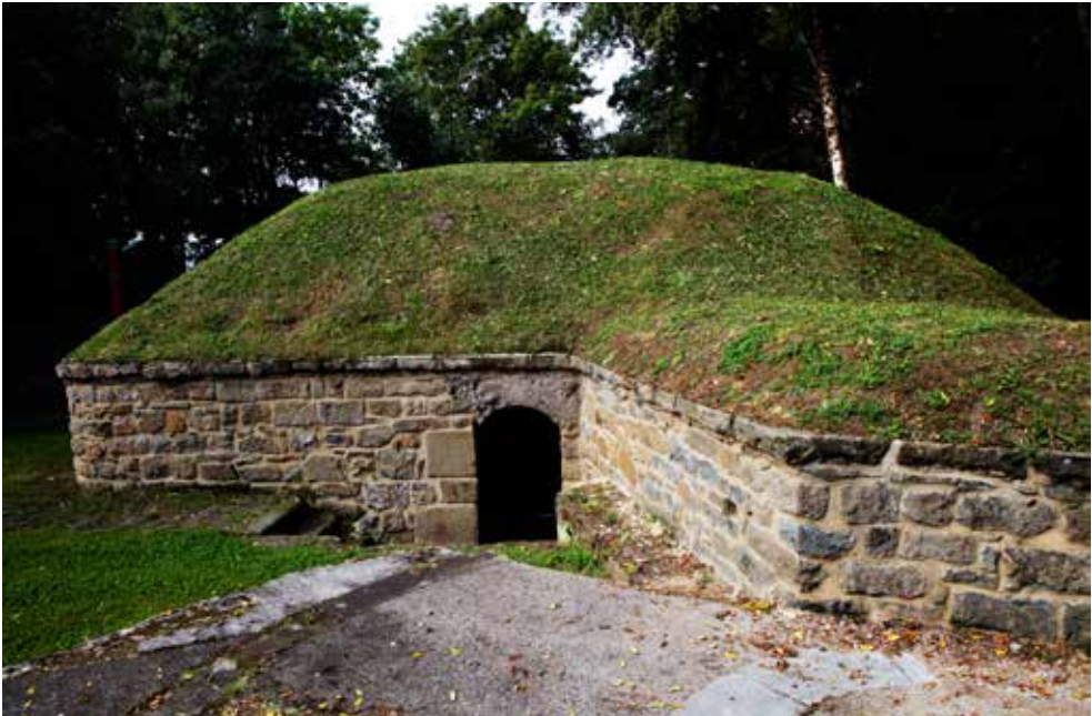
Través de la batería. Delante se observa parcialmente una explanada para un OBc de 21 cm en montaje de ruedas Lerdo-Milán.
