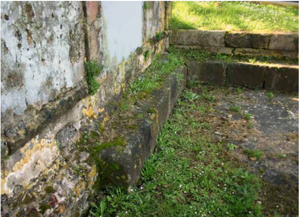
Fachada occidental, con el detalle de parte de banco corrido existente en el porche.
