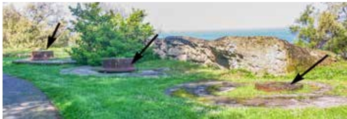
Basa de cañón de Hierro Sunchado de 15 cm sobre marco bajo y giro adelantado (Santiago).
