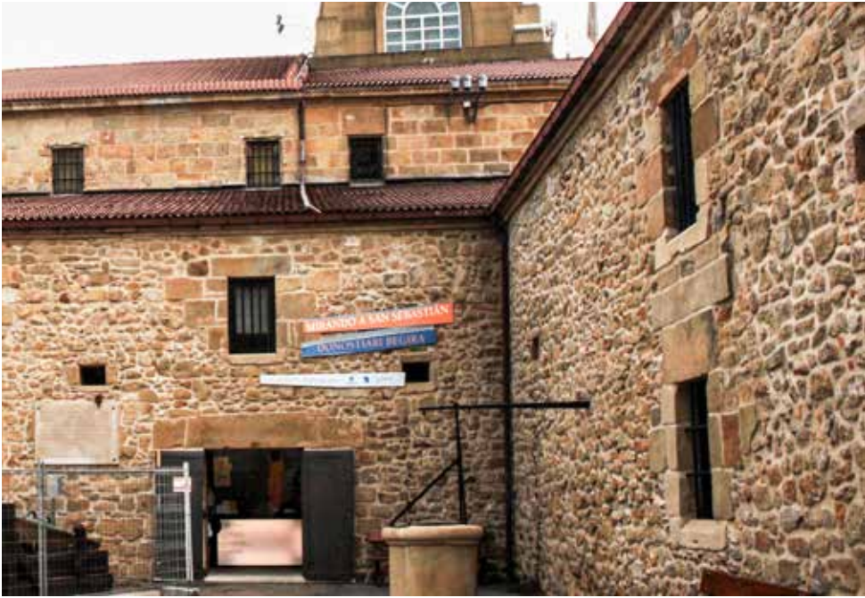
Acceso a la casa de la historia en la fachada del cuartel del siglo XVIII.
