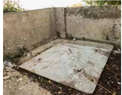
Estructura que soportaba la torreta metálica y muro de protección.
