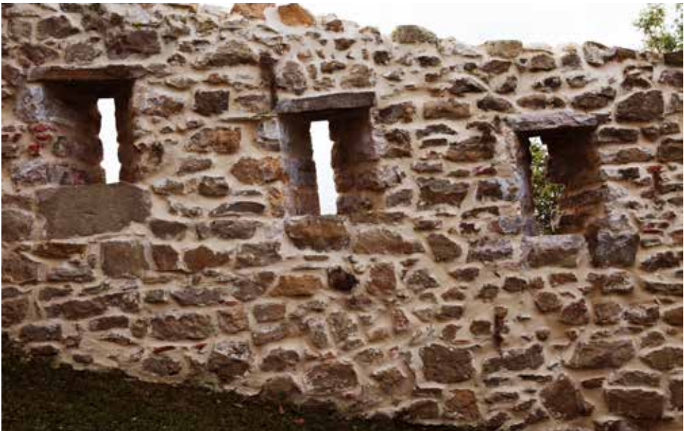
Aspilleras formadas en un muro de piedra en el muro que une el camino de comunicación entre las Baterías de Santiago y la Batería Alta de Santa Clara.
