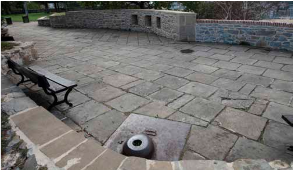
Fotografías superiores. Sector circular. Sucesivas reformas han modificado su estructura y cotas (aspilleras al nivel del suelo) La pieza metálica es la base de un CHRS de 15 cm.
