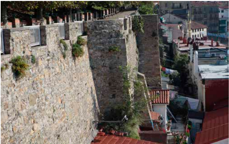
Vista exterior. Al fondo se observa la torrecilla del puerto y en primer plano la zona reconstruida hacia 1727, así como los dos contrafuertes cortos. Se aprecia también la desorganización urbana del estrecho espacio comprendido entre la muralla y las casas.
