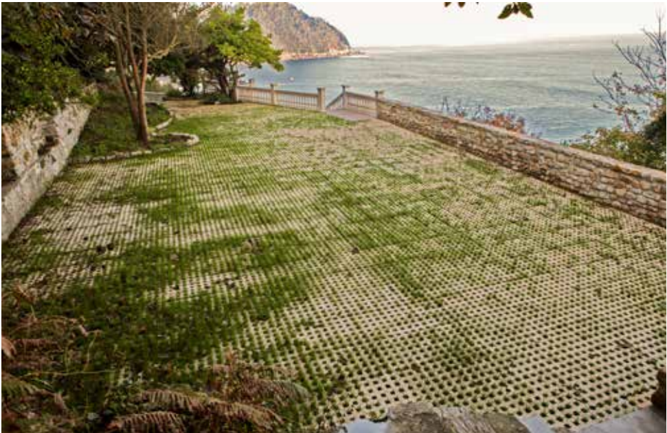
Explanada principal o superior, tras la demolición de los edificios y su revestimiento con celosía de hormigón sobre arena. Posteriormente a la obtención de la fotografías se instalaron varios bancos de gran tamaño para la contemplación de las puestas de sol.
