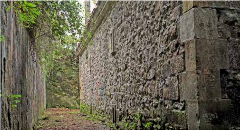
Fachada y pasillo de aislamiento sur.
