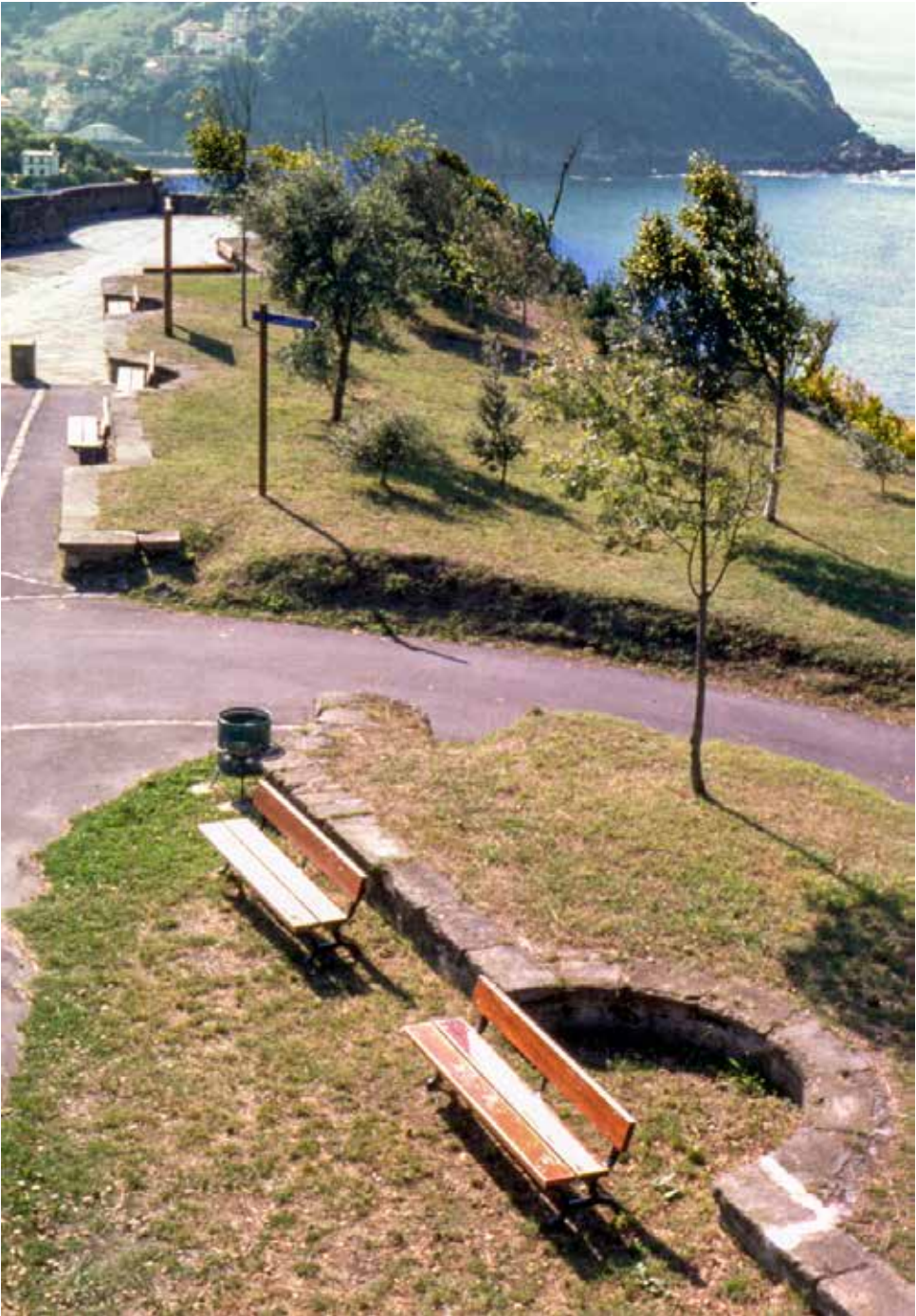
En primer plano se observa el semicilindro entrante de un Cañón de Hierro Sunchado de 15 cm. Es de planta semicircular. Los que son ligeramente apuntados corresponden a obuses de bronce de 21 cm.
