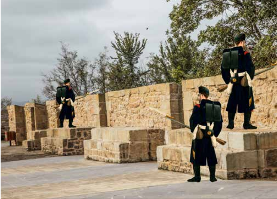
Banquetas de dos escalones en el castillo de Sta. Cruz de la Mota. La banqueta se interrumpe en el espacio en que las cañoneras cortan el parapeto. La ambientación corresponde a soldados de artillería en uniforme de marcha, sin esclavina (1862)
