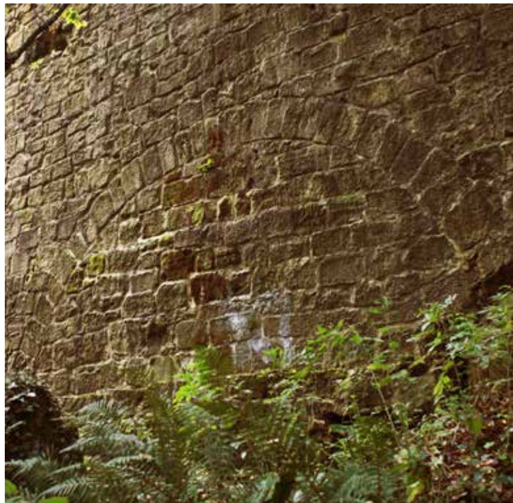
Arco ciego, muy probablemente de descarga. en el ángulo noreste.
