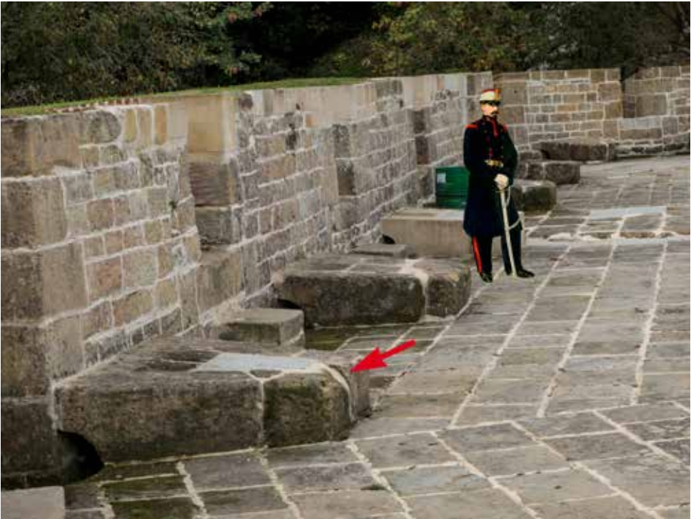
Banquetas de un escalón en la Batería del Mirador. Ambientación: artillero de diario (1862).
