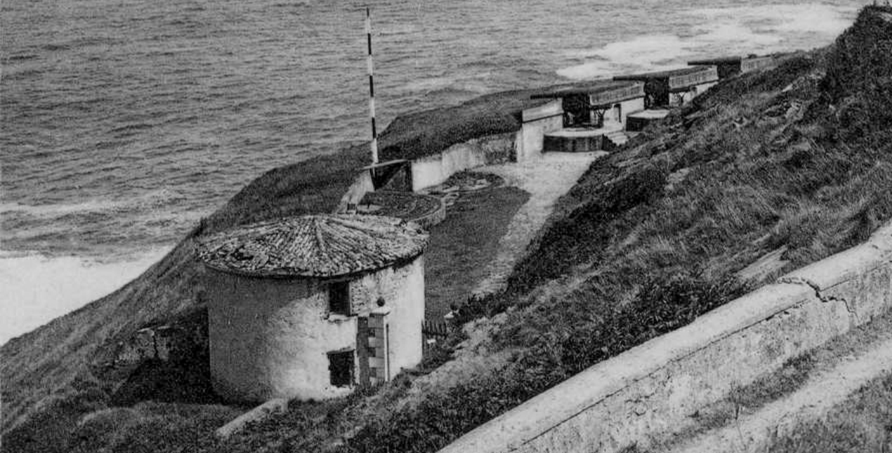
Bateria de Bardocas a principios del siglo XX. Se observa el cuerpo de guardia circular y la batería construidas con ocasión de la Guerra de Cuba.
