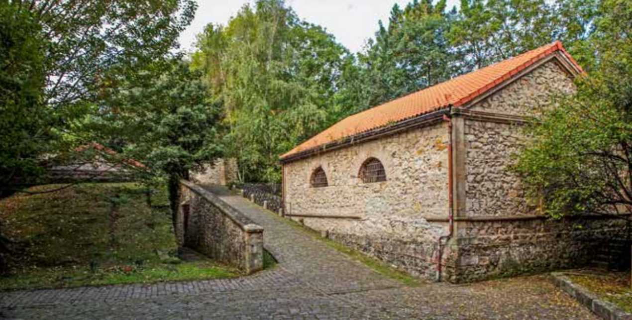
Acceso a la Bateria mediante camino adoquinado que pasa entre el cuerpo de guardia y el repuesto.
