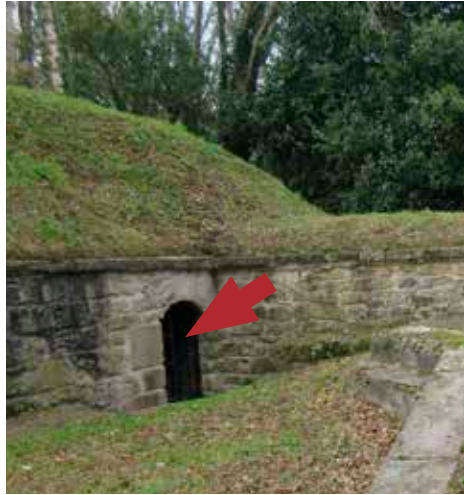
Acceso al repuesto, bajo el traves de la batería alta del Gobernador (1899).
