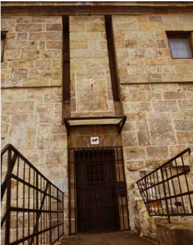
Acceso al Macho. Se observan los dos orificios para circulación de los cigoñales de un puente levadizo (actualmente de piedra) y, sobre la puerta, el espacio ocupado muy probablemente por un escudo real.
