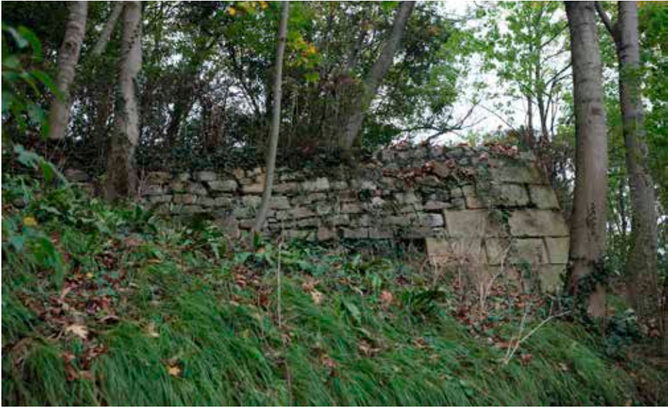
Cara occidental. Se aprecia claramente los sillares del ángulo y el pequeño pretil de piedra que corona la obra, que en realidad es el límite del camino en la que está integrada.
