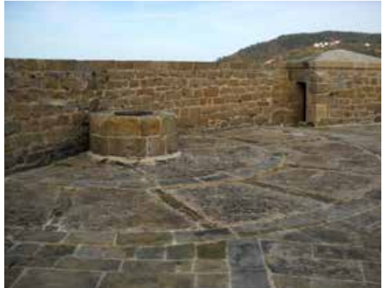
Batería a Barbeta. A la derecha la escalera de acceso hacia la bóveda y al exterior.
