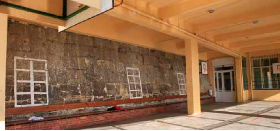
Patio de recreo limitado por estructuras pertenecientes a la batería de Santa Teresa (izquierda de la fotografía) y cubierto por una estructura de hormigón armado que soporta las plantas superiores y una terraza.
