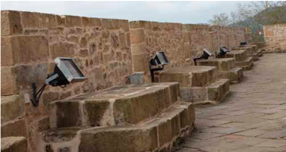
Detalle de las cañoneras, merlones y banquetas del parapeto meridional.
