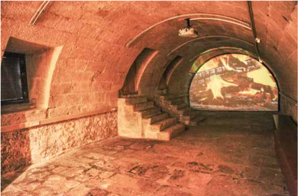
Bóveda, accesible actualmente a través del cuartel del siglo XVIII. La pantalla oculta un 25% de la longitud de la bóveda. Las escaleras conectan con el minúsculo vestíbulo de acceso al macho.
