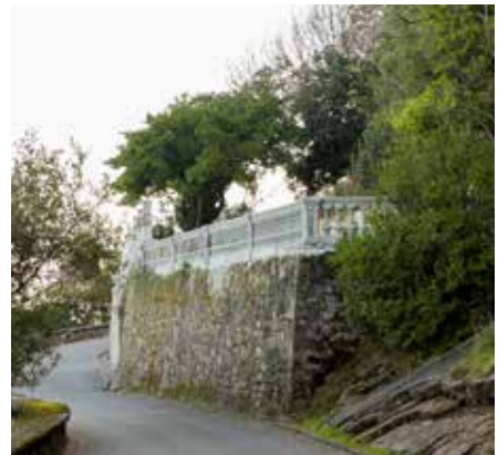
Muro de contención de la explanada inferior, visto desde el camino.
