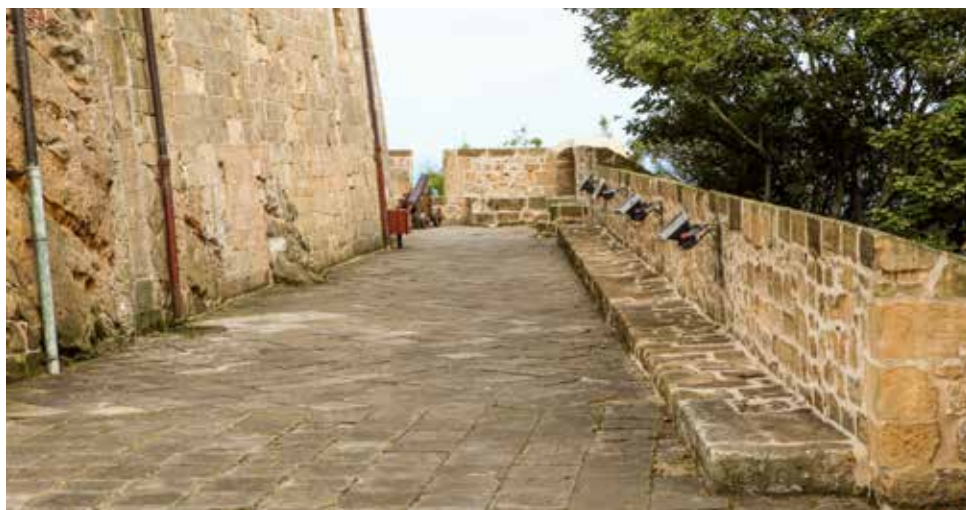
Plataforma artillera. A la izquierda, el macho, a la derecha el parapeto oriental, sin cañoneras y con una banqueta de un solo escalón.
