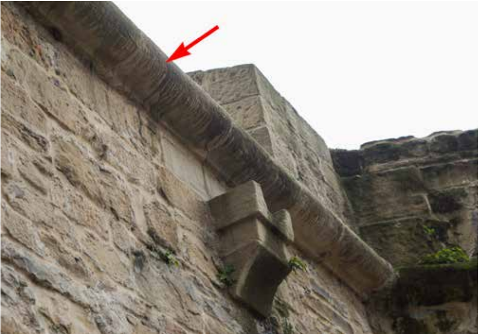
Cordón en la Batería del Mirador.
