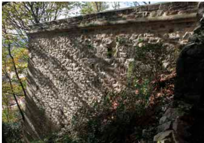
Vista del lienzo NE de la batería de San Gabriel. Está realizado en mampostería con ángulo y cordón de sillería.
