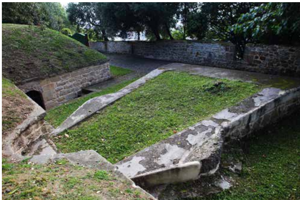
Explanada para el Obús de Bronce Comprimido de 21 cm, en este caso sobre montaje "Seraing" (de rastra).
