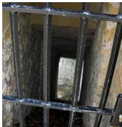
Escalera que comunica la batería superior con el exterior.
