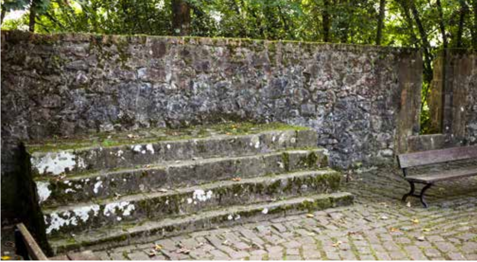
Parapeto de fusilería y banqueta de cinco escalones. Actualmente modificado exteriormente (secciones inferiores).
