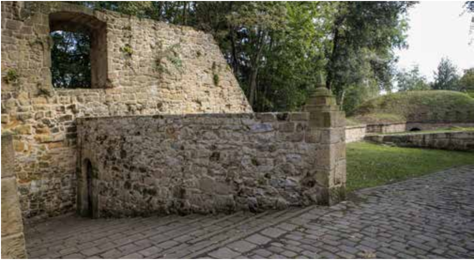
Acceso a la poterna desde la Batería Alta del Gobernador.
