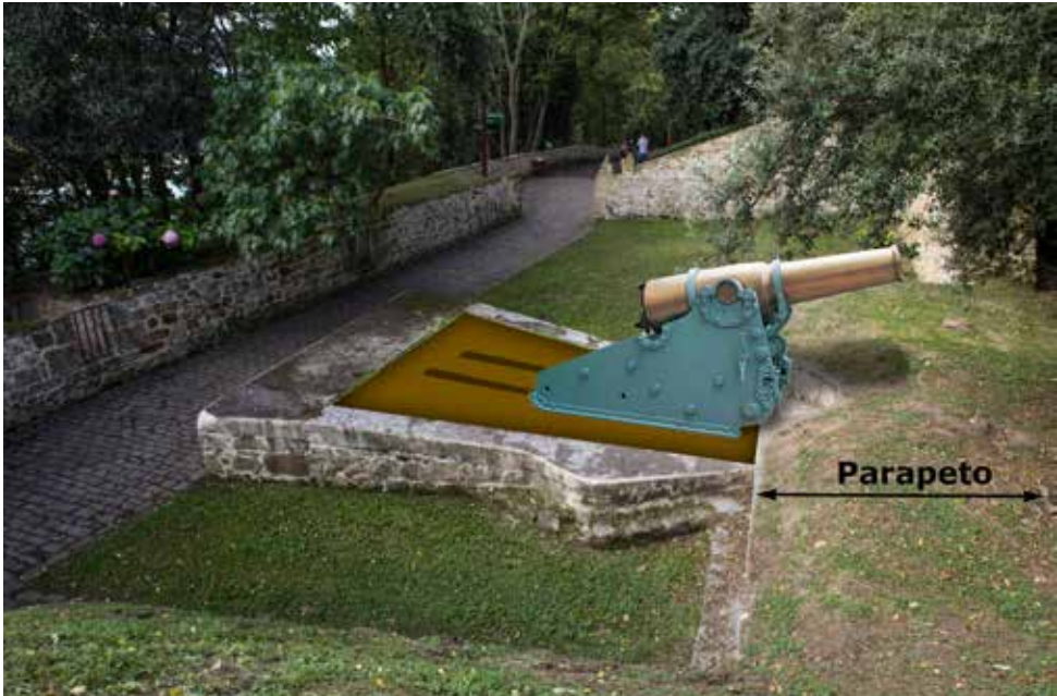
Parapeto del frente norte de la Batería Alta del Gobernador. Fue construida en 1898 para obuses de bronce comprimido de 21 cm, en este caso, tal y como se aprecia en el fotomontaje, la explanada es para montaje de rastra ("Seraing") y a barbata, es decir, que la pieza de artillería dispara por encima del parapeto, sin cañonera. El parapeto es de tierra y para la formación de la masa cubridora aprovecha, en parte, un viejo muro, que es probable que se trate de la muralla de Villaturiel semiarraçada.
