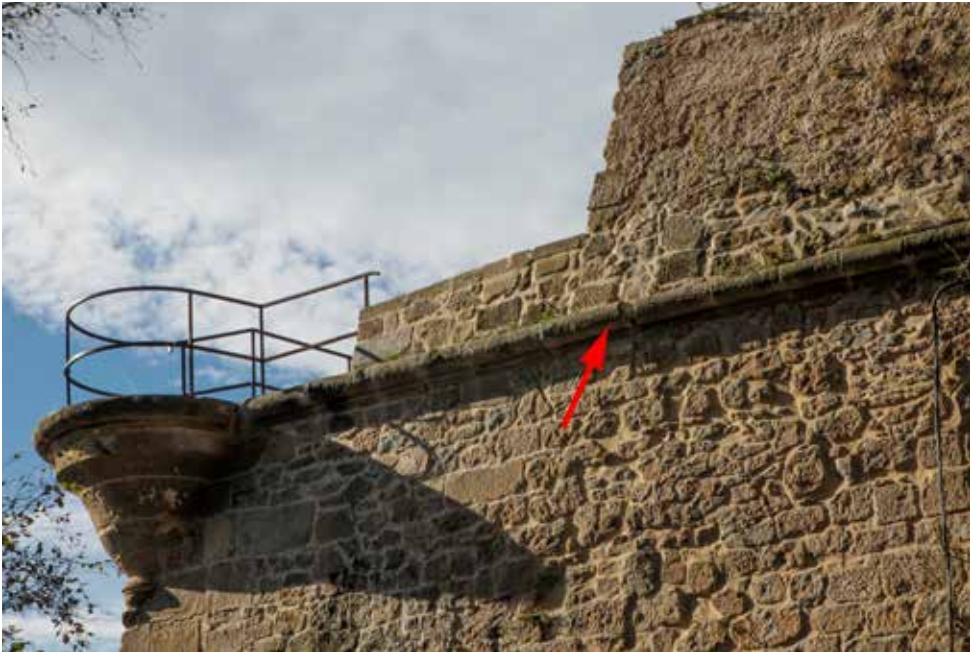
Cordón en la escarpa de la Batería Alta del Gobernador. Se supone que el elemento que está sobre él es el parapeto.
