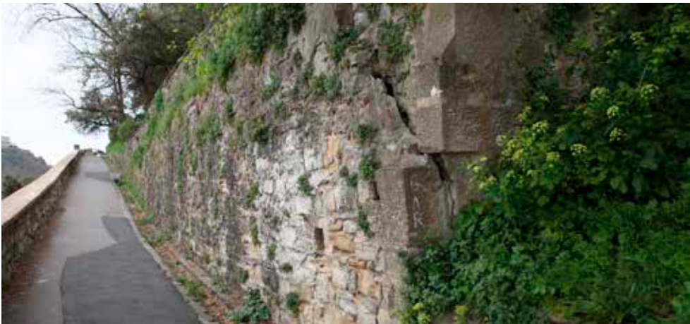
Camino-adarve. Al fondo, la Batería de las Damas. Los sillares de la derecha corresponden a una antigua puerta.
