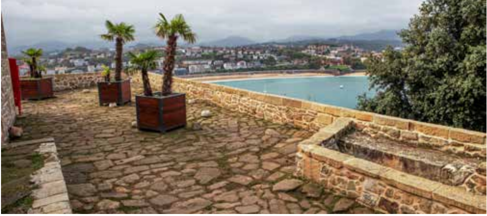
Bateria Alta de Santa Clara. Parapeto.
