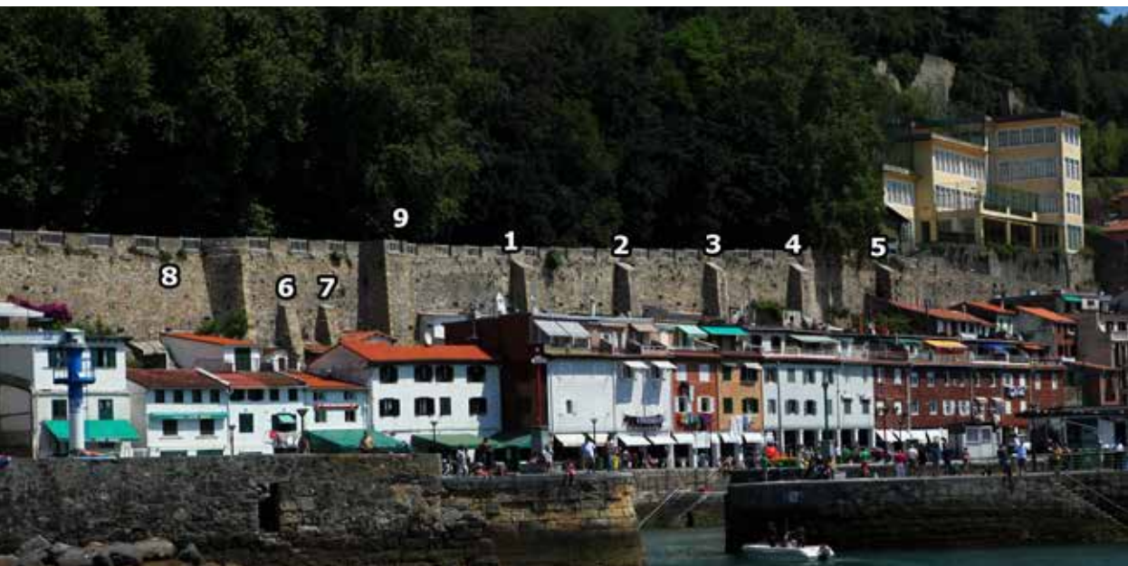
Sector "Muralla del Puerto" 1 a 7 contrafuertes; zona reconstruida en el siglo XVIII. 9 Torrecilla del puerto.
