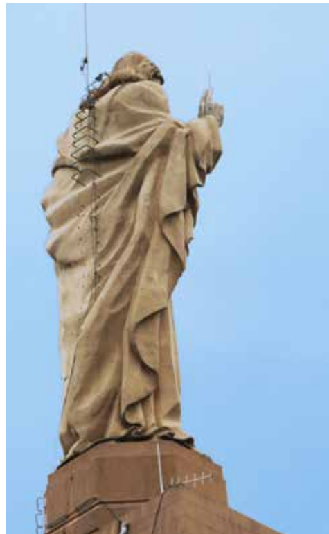
La espalda muestra elementos para el acceso a la cabeza y el pararrayos.
