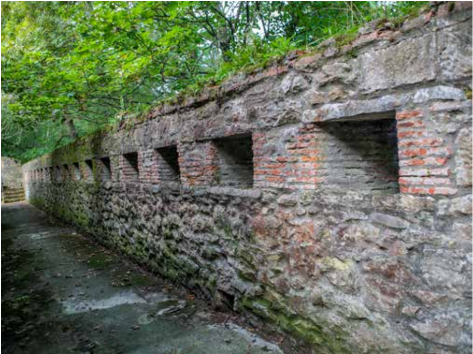
Aspilleras con las derivas formadas en ladrillo cercanas al cuerpo de guardia de la Batería Alta del Gobernador.
