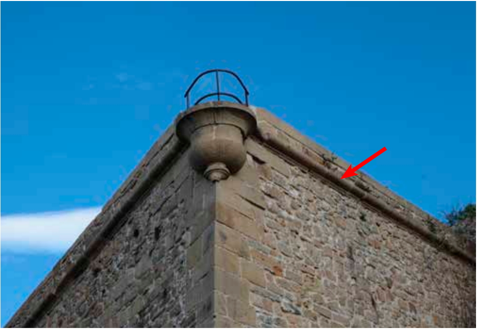
Cordón de la Batería Alta de Santa Clara en el entorno de su ángulo saliente.
