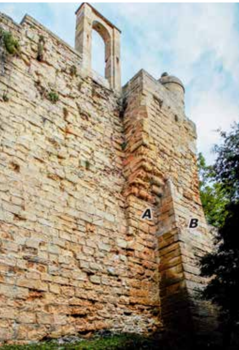
Ángulo sureste. A: Lienzo original. B: Contrafuerte añadido.
