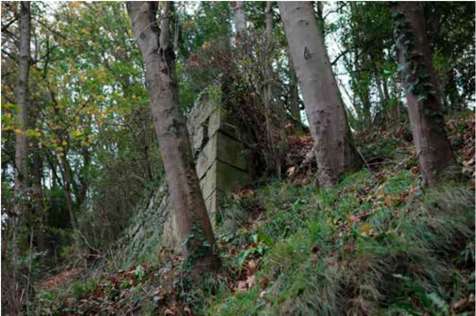
Ángulo de la obra, en la que se aprecian algunos sillares movidos y, sobre todo, diversos árboles que crecen de manera incompatible con la conservación de la Plataforma.
