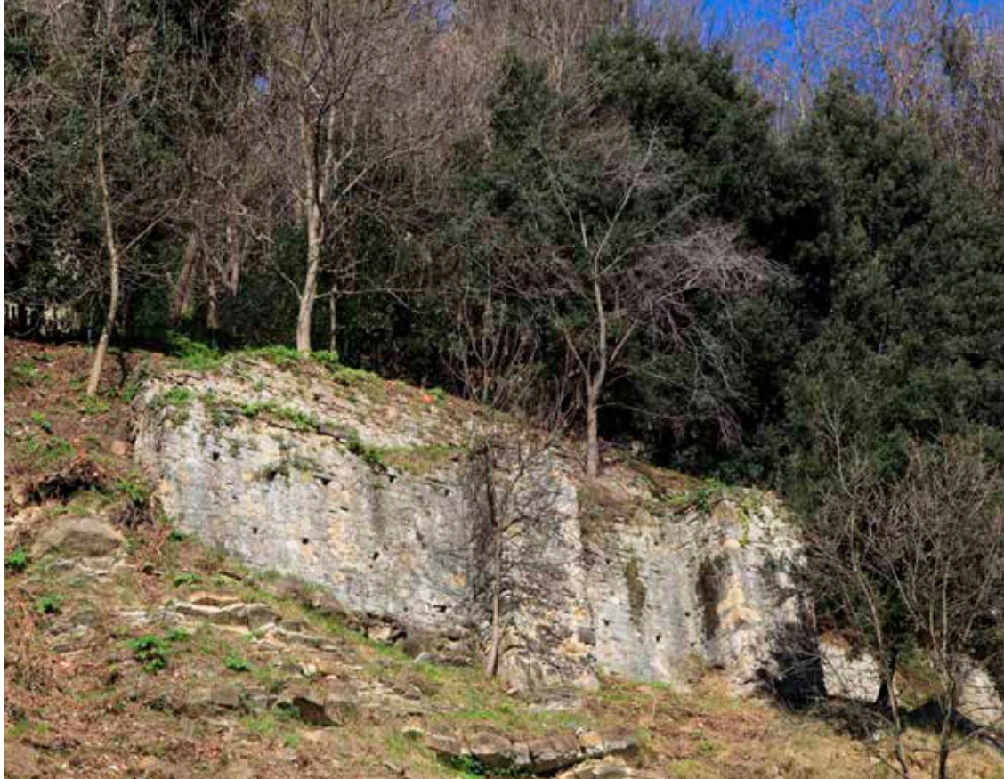
Estructuras correspondientes a la muralla inacabada oriental de Tiburcio Spanochi.
