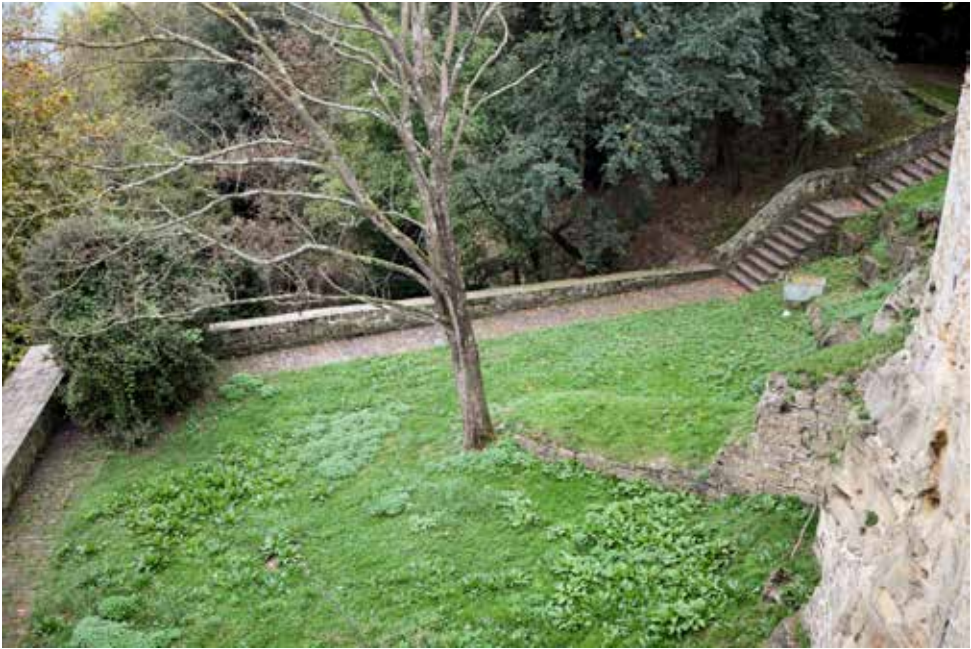
Acceso actual con escaleras a la Batería del Suroeste.
