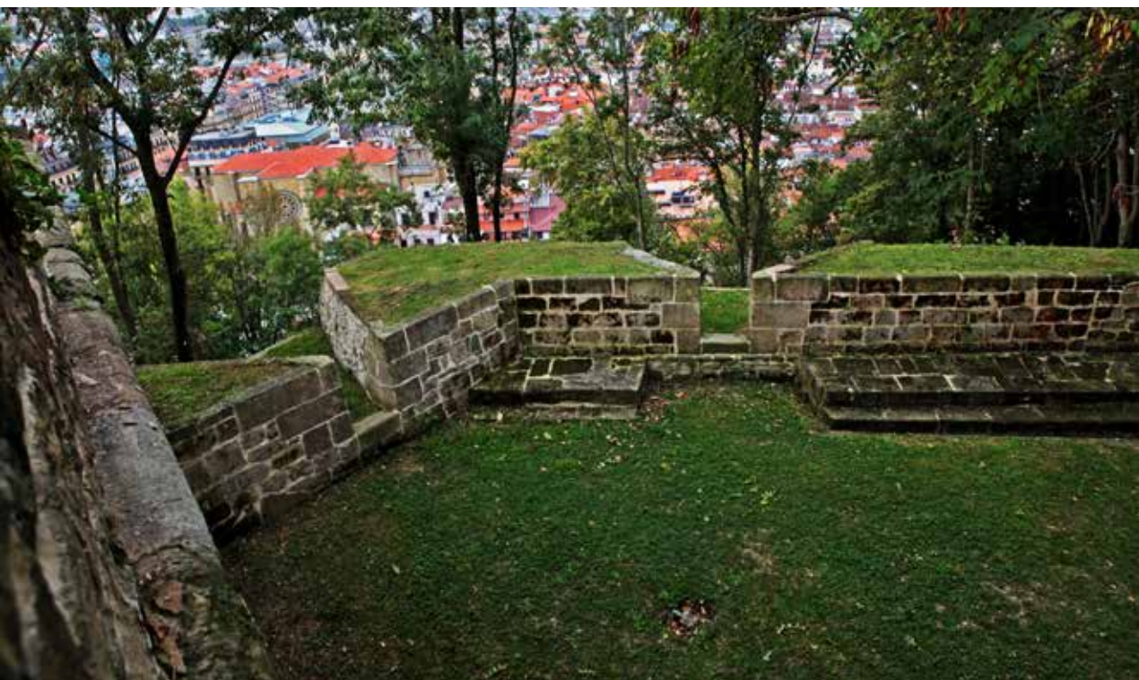
Bateria baja, con parapeto, dos cañoneras y banqueta.
