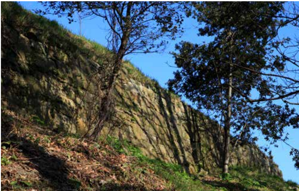
Extremo oriental del muro. Fotografía tomada en sentido oeste/este.
