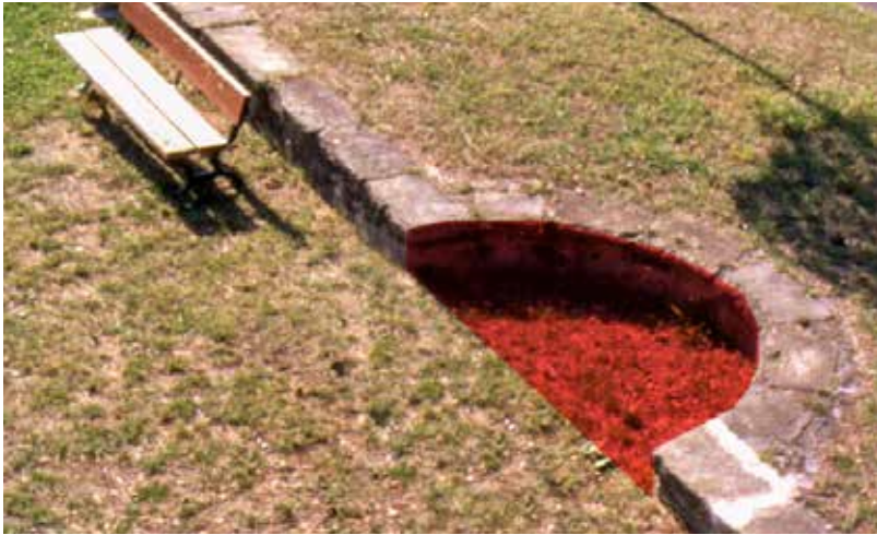
Semicilindro entrante (en color rojo) de un cañón HS de 15 cm sobre marco alto y giro adelantado, en el frente norte de la Batería de Santiago.
