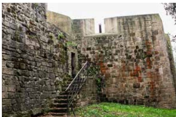
Acceso suroeste del castillo. vista desde el exterior.
