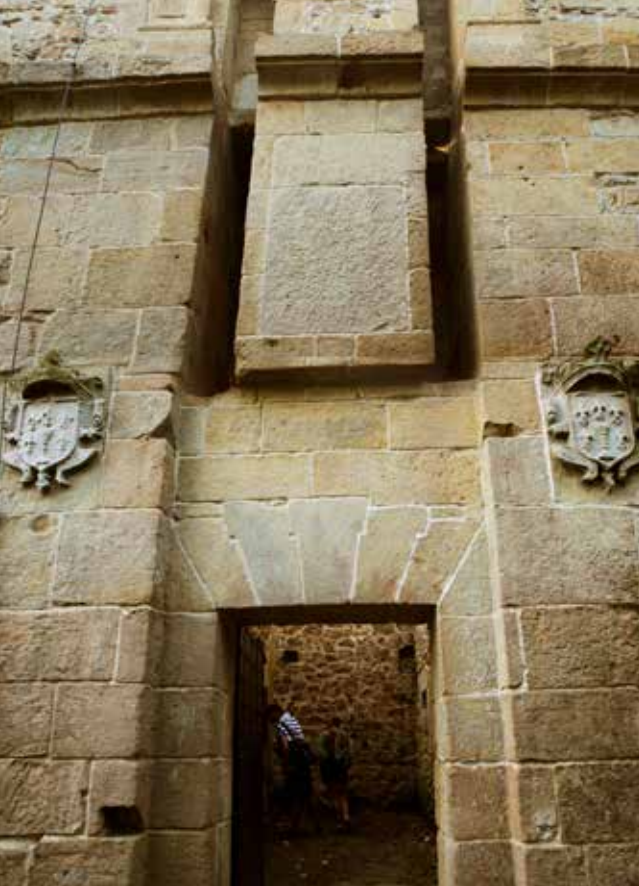
Acceso norte al Castillo. Se observan claramente las dos mortajas que albergarían los cigñales cuando el puente estuviera levantado.
