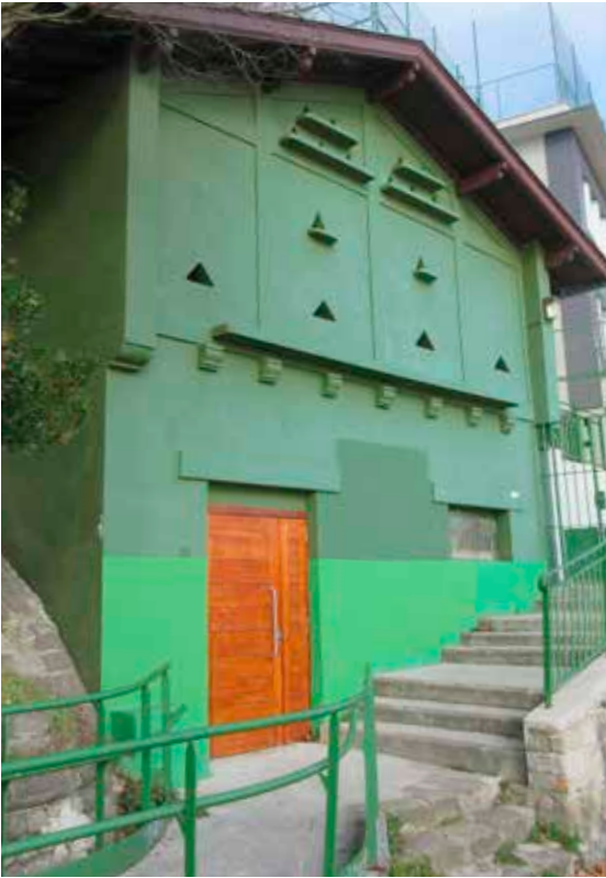
Palomar sin palomas (planta superior) y sala de bombas y otros servicios municipales (sala inferior).
