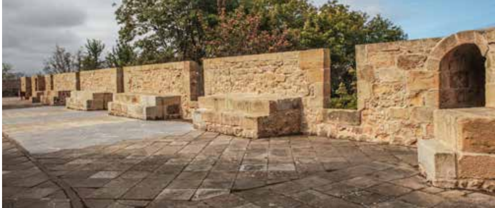
Plataforma artillera del castillo de Sta. Cruz de la Mota. Cañoneras orientales, con sus banquetas apoyadas en los merlones. En primer término, paso a una de las garitas.
