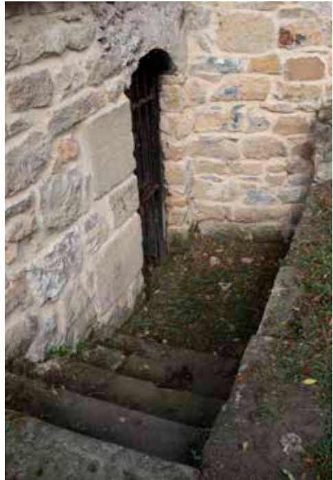
Escalera de acceso al través. La mampostería estaba originariamente enlucida.
