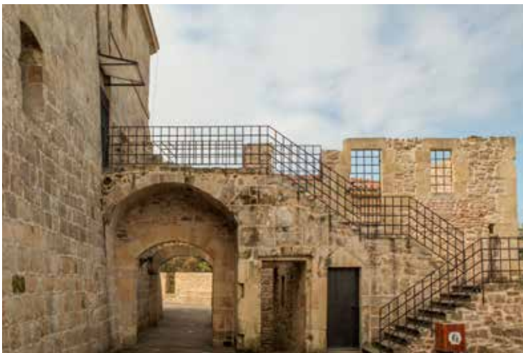
Actual escalera y puente fijo de piedra que sustituye al puente levadizo original en la entrada a los pabellones del Gobernador (actualmente capilla del Sagrado Corazón).
