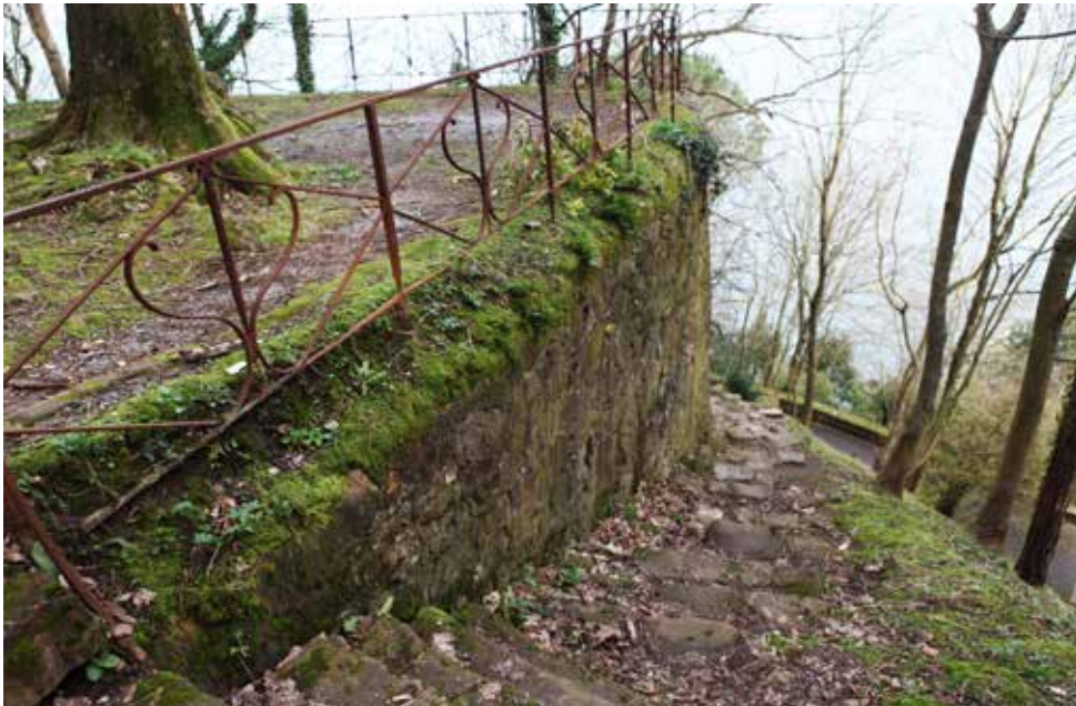
Barandilla y sector superior de la escalera de acceso.
