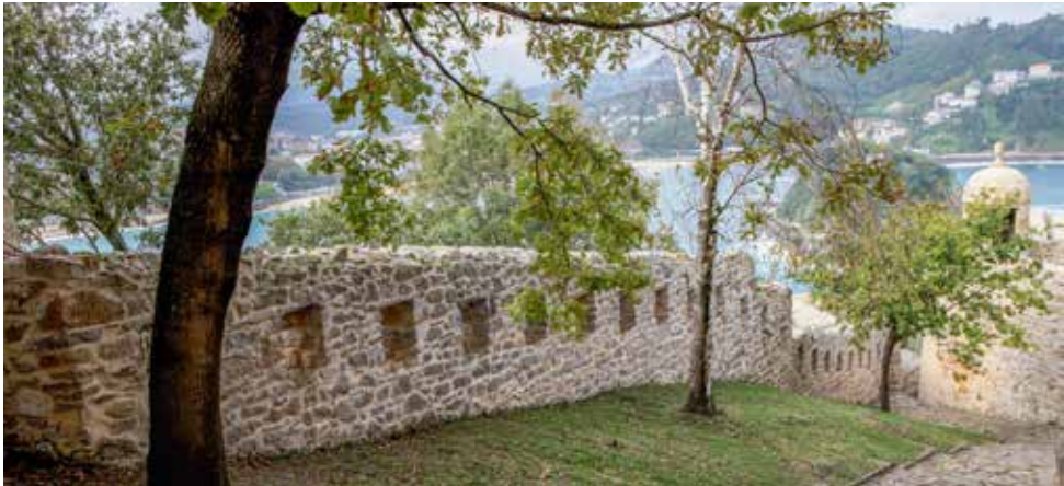
Fot. sup.: Muralla occidental de Villaturiel (?). Tramo 1 en su inicio. Vista orientada hacia la batería Alta de Santa Clara. Coincide con el muro aspillerado de 1865 (?).
