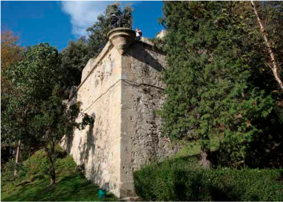
Vista exterior de la batería.
