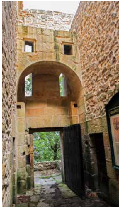
Puerta Norte. Interior. Se aprecian las mortajas del puente levadizo.
