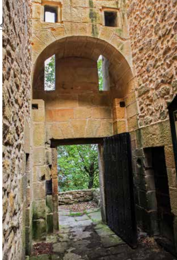
Acceso norte visto desde el interior, apreciándose vestigios del puente, tales como los las mortajas (orificios alargados).
