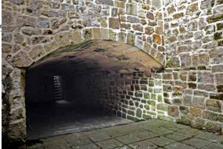
En primer plano, pequeño patio de armas (en realidad antigua caja de escalera) frente a la puerta y al fondo el cuerpo de guardia con la escalera de acceso a la plataforma superior. La pared de la derecha estuvo ocupada por la escalera principal
