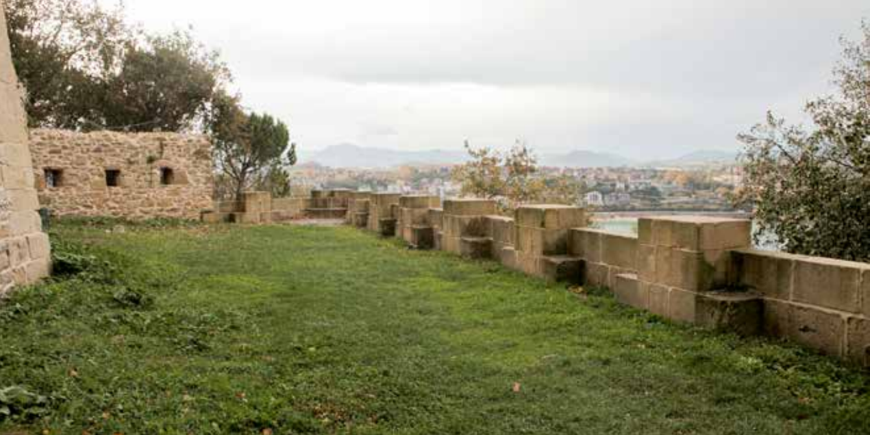
Vista general de la batería. El "parapeto" no es original. El muro aspillerado es de 1865.
