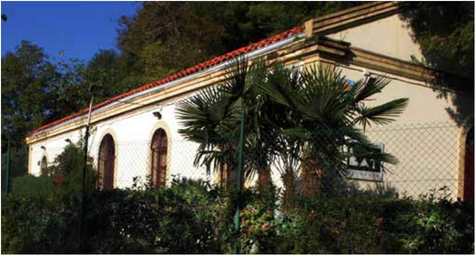
Fachada principal (sur) y una de las laterales (este).
