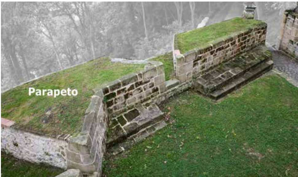
Parapeto en la Batería Baja del Baluarte del Mirador, en el que se aprecian también varias cañoneras y banquetas.
