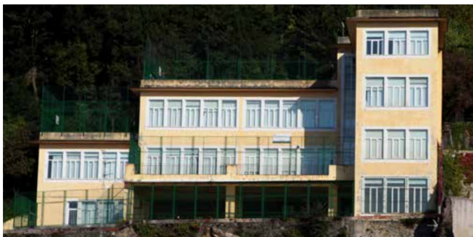
El edificio hacia 2014, antes de la última remodelación de la fachada realizada en el año 2015. Las cubiertas se presentan valladas y adaptadas a espacios de recreo y deporte.
