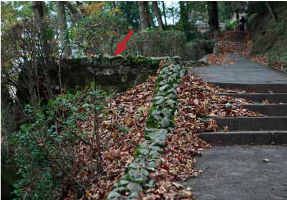
El minúsculo lado oriental de la obra y su imbricación en el camino. Tras el segundo grupo de escaleras se encuentra la batería de San Gabriel.
