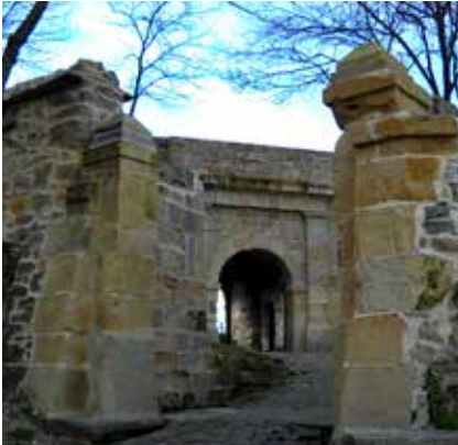
Primera puerta de acceso. Al fondo se aprecia la puerta principal.
