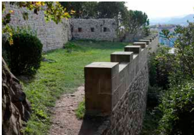
Vista del lienzo NE de la batería de San Antonio. Está realizado en mampostería. El parapeto no es original.
