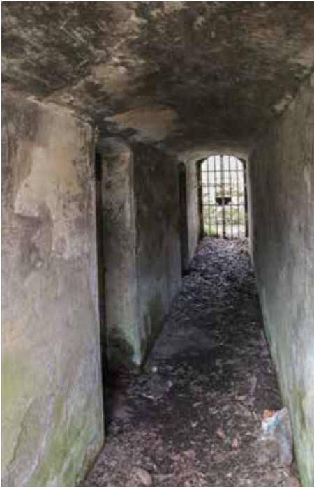
Interior del través. Al fondo: uno de los accesos. A la izquierda los depósitos.
