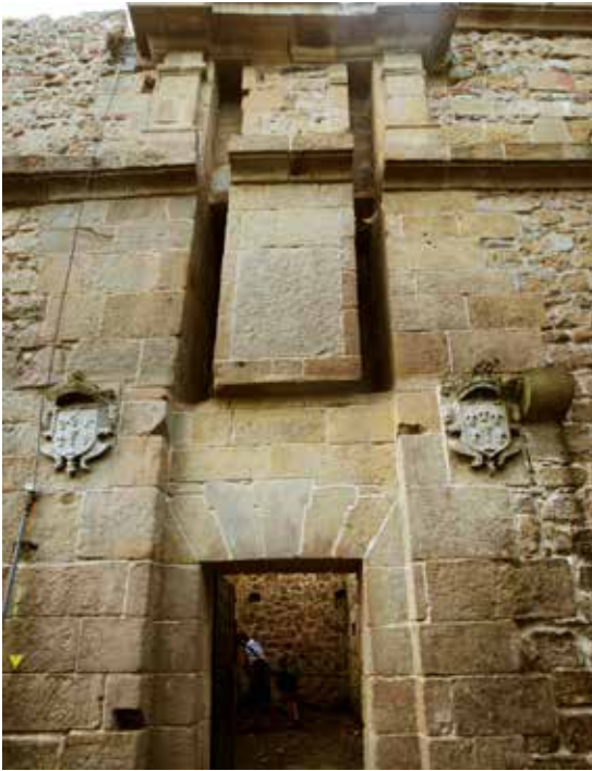
Puerta Norte. Exterior. Se aprecian las mortajas para los cigóñales de un puente levadizo.
