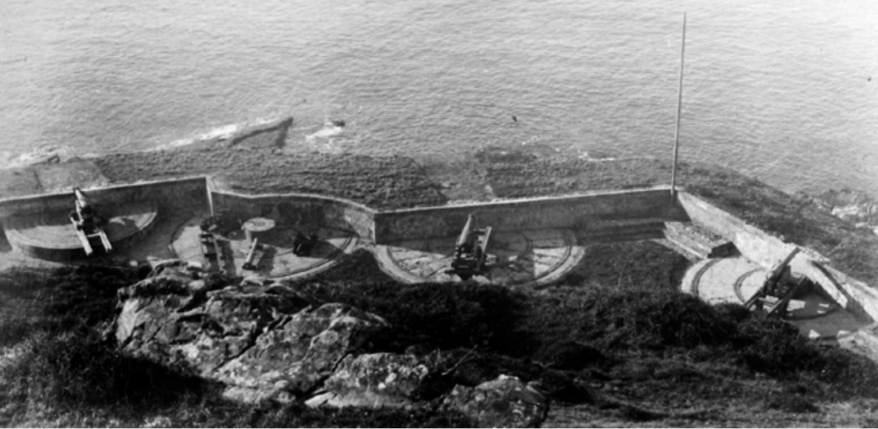
Batería de Bardocas a finales del siglo XIX. Se observan 4 piezas de artillería de avancarga (la segunda de ellas desmontada, dejando ver el morterete para giro del marco del cañón).
