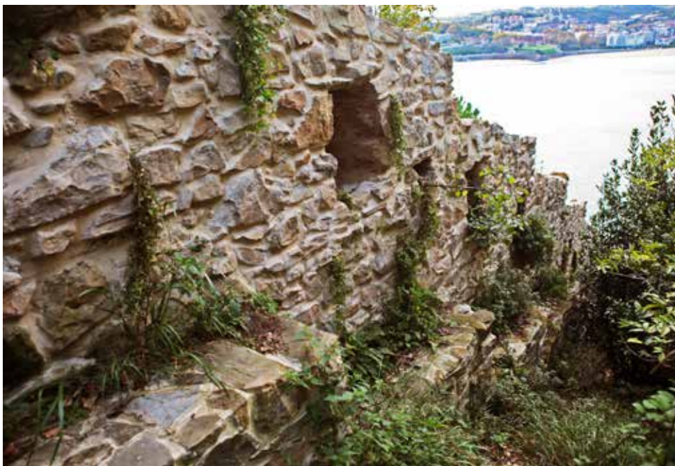
Muralla occidental de Villaturiel (?). Tramo 3. Vista orientada hacia la batería de las Damas. Coincide con el muro aspillerado de 1865 (?). Nótese el escalonamiento de muro y banqueta para salvar la fuerte pendiente.
