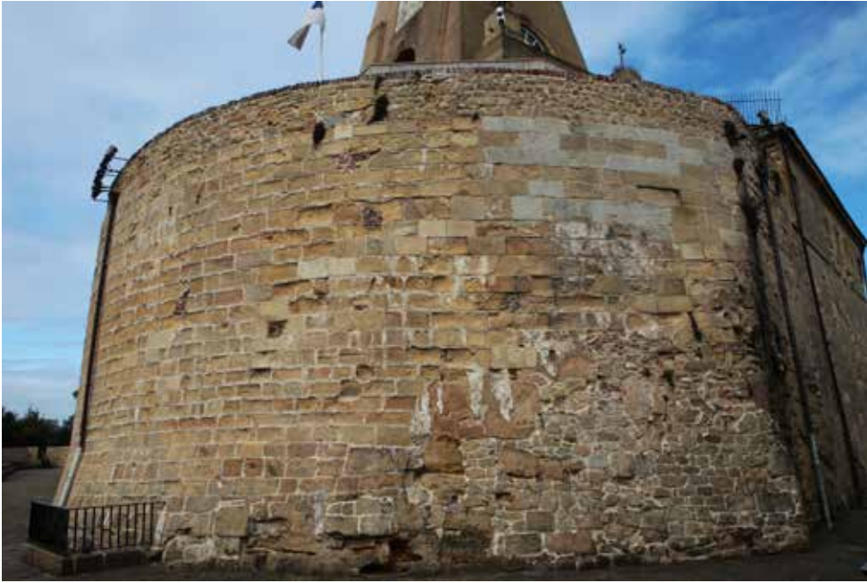
Cubo de la Reina. Se aprecia disparidad de aparejos: sillaría en la mayor parte, pero también mampostería rematada por ladrillo en el parapeto y sillarejo en la parte inferior derecha.
