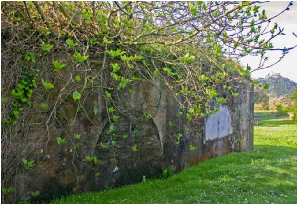
Fachada septentrional, con las ventanas actualmente tapiadas.
