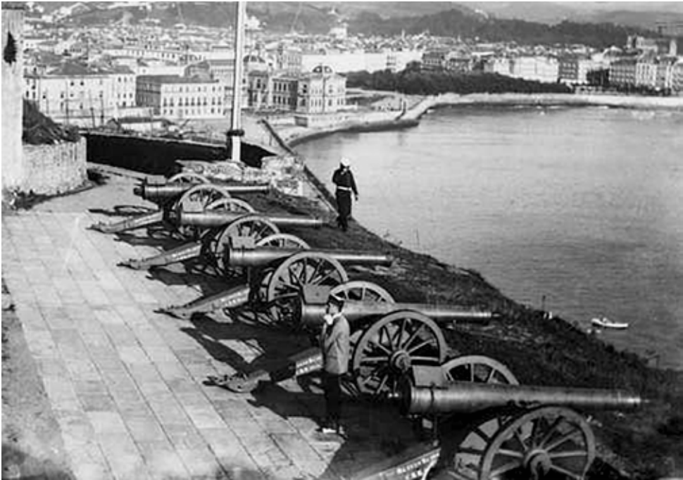
Bateria de las Damas. Cañones de Bronce de 12 cm. El “tejadillo” sobre la parte trasera del cañón es el cubichete, que servía para proteger de la lluvia el “oído”, orificio por el que podría entrar agua de lluvia (identificación provisional).
