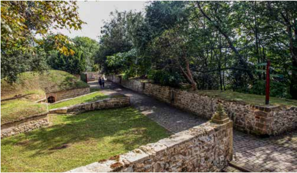
Vista general de la Bateria Alta del Gobernador.
