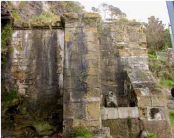
Fachada lateral con dos contrafuertes..
