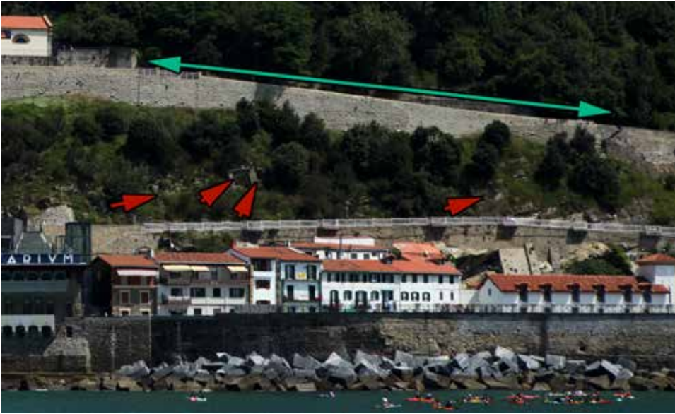
Lienzo comprendido entre la escalera del puerto (derecha) y la batería de las damas (izquierda). Las flechas rojas señalan las obras de fábrica a modo de estribos que aseguran la roca, posiblemente inestable en la zona. La flecha azul señala el recorrido de la muralla.
