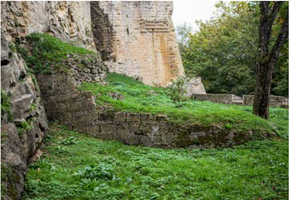
Estructuras murarias. Posiblemente correspondan a la muralla meridional Ide Villaturiel.
