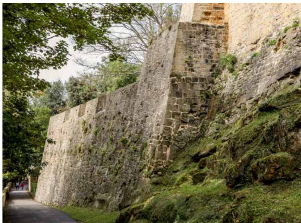
Vista desde su base. Se aprecian las tres cañoneras abiertas en su parapeto.
