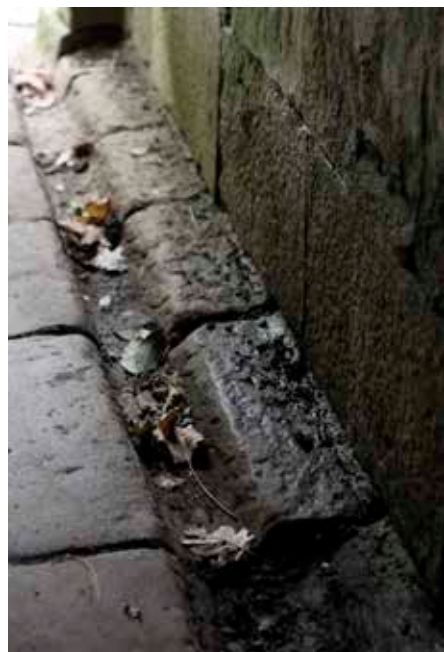
Canalización en el interior de la Poterna.
