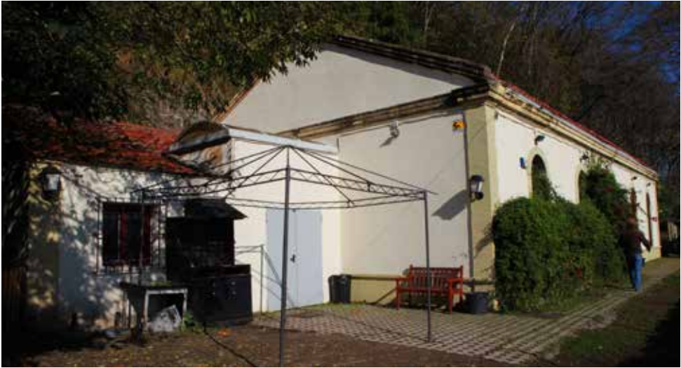
Fachada occidental y edificio anexo.
