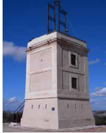
Torre n. 4 (Arganda) restaurada. Telégrafo óptico Madrid-Valencia. La de Urgull pudo ser parecida.
