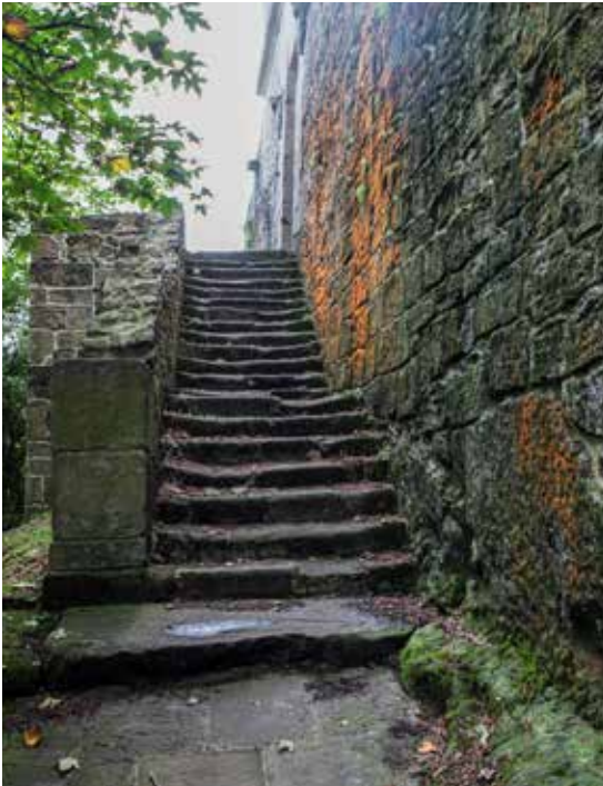
Puerta Norte. Exterior. Se aprecian las mortajas para los cigóñales de un puente levadizo.
