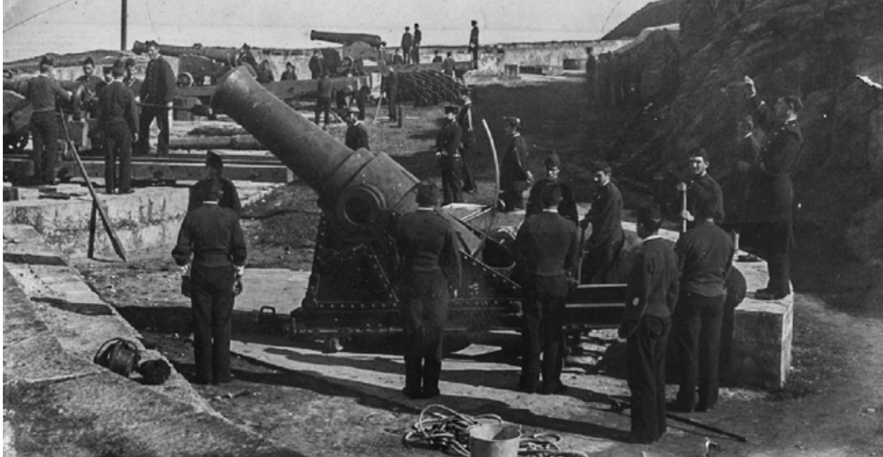
Fot. de finales del siglo XIX. En primer plano un Obús* de Hierro Sunchado de 21 cm. Las dos piezas en segundo plano es probable que se traten de cañones de bronce de 14 cm transformados a retrocarga, con cureñas de madera; una en montaje sobre marco bajo y la otra sobre marco alto. La pieza del fondo es un cañón de hierro rayado de 16 cm. Se trata de una pieza de artillería de avancarga, también sobre cureña y marco de madera.
