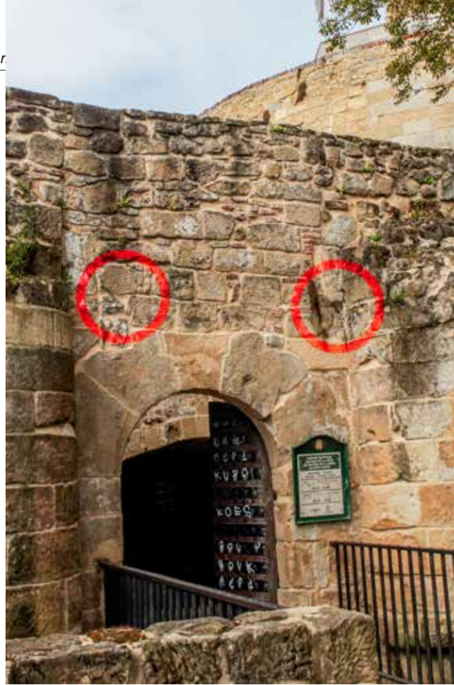
En rojo se señalan los posibles (?) vestigios huecos de las mortajas en un muro parcialmente reconstruido del acceso oriental.
