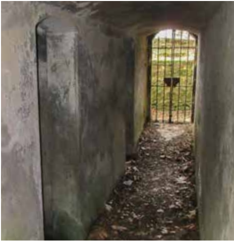
Interior del repuesto de munición de la batería alta del Gobernador (1899).
