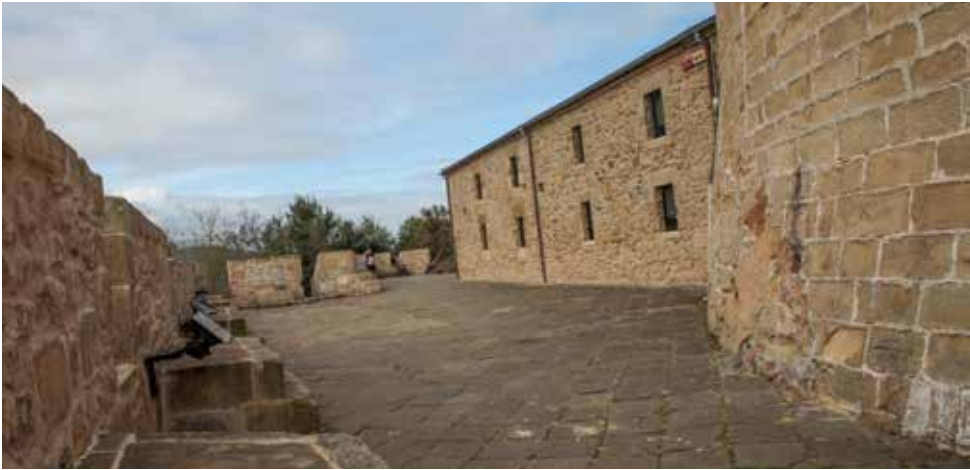
Plataforma artillera. A la izquierda, el parapeto meridional. En primer plano el cubo de Doña Juana y a continuación de éste, el cuartel del siglo XVIII.
