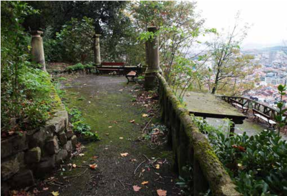
En primer plano la plataforma superior. A la derecha, la inferior.
