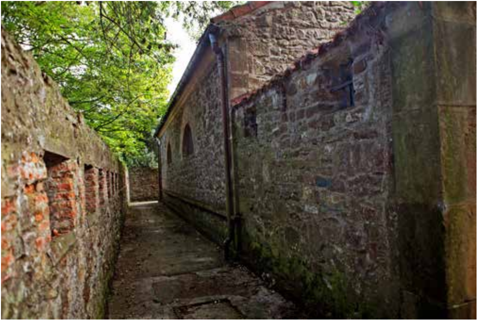
Cuerpo de Guardia, Está parcialmente rodeado por un parapeto de fusilería aspillerado.
