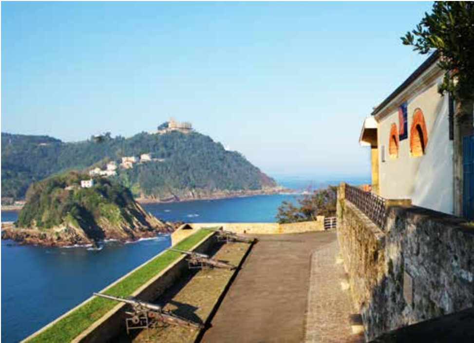
Vista parcial de la batería. A la izquierda de la fotografía, el parapeto artillado con cañones Saint Chamond de 7,5 cm y a la derecha, el cuerpo de guardia.
