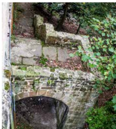
Actualmente el puente ha sido sustituido por otro fijo de piedras unido a una escalera de acceso diferente de la original.
