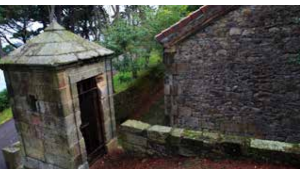
Garita del almacén de pólvora
