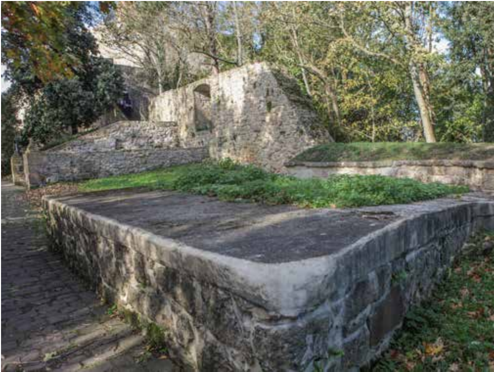
Vista de la explanada para OBC de 21 sobre afuste "Seraing". Se puede comparar con la foto contigua que actualmente presenta mampostería vista, mientras que originalmente presentaba enlucido.
