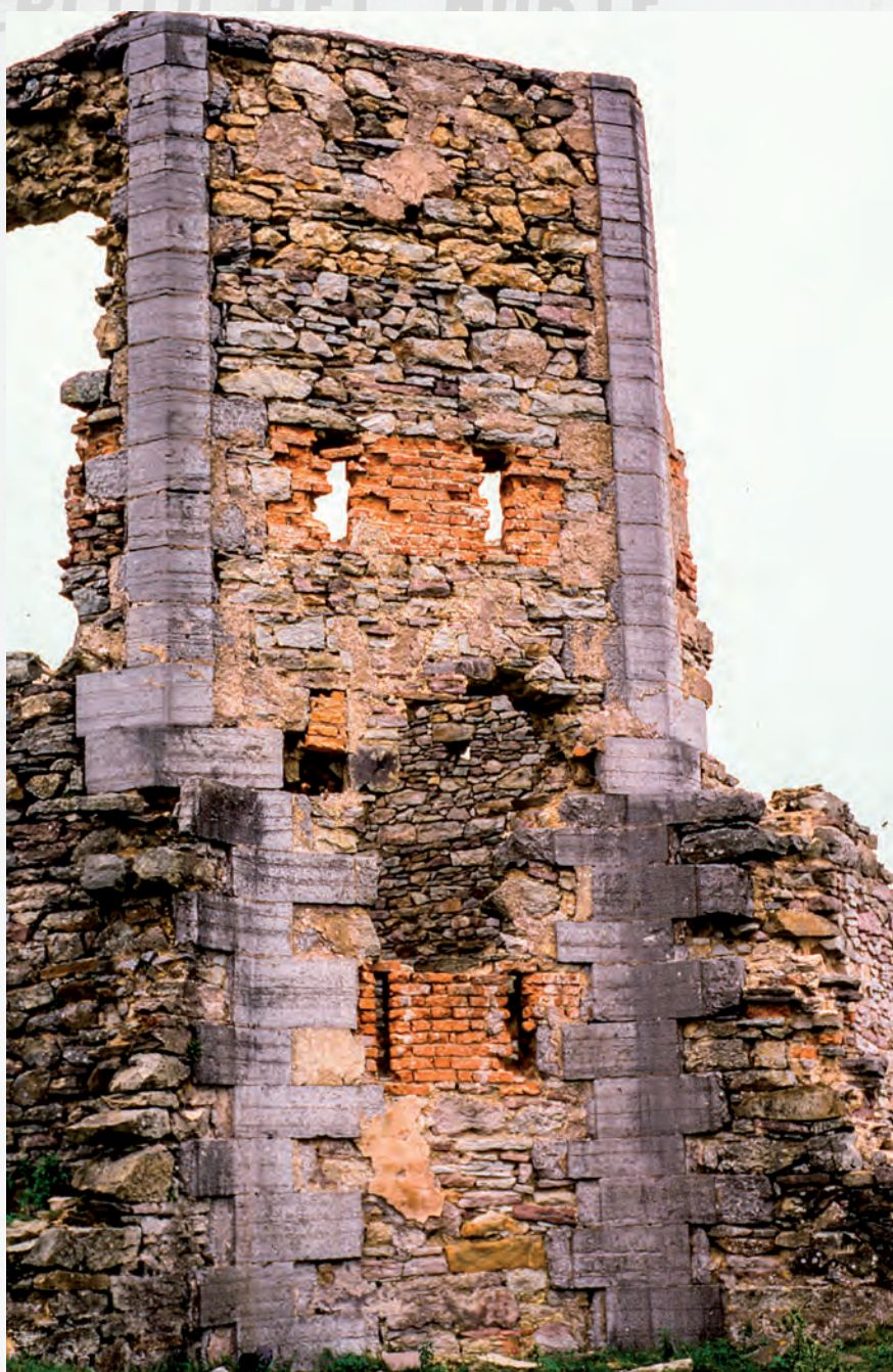
Torreón central, en el que se aprecia uno de los lados menores con los esquinales de sillería caliza y las aspilleras.
