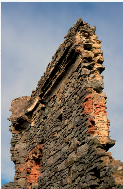
Una de las naves en su confluencia con el torreón. Se aprecian las aspilleras y otros elementos, confeccionados con ladrillo resaltando sobre la mampostería
