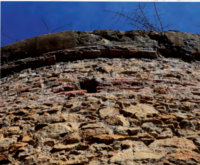
Sector superior de la torre de Endarlatsa, en al que se aprecia el corón y la mampostería desprovista del enfoscado que originalmente la recubría
