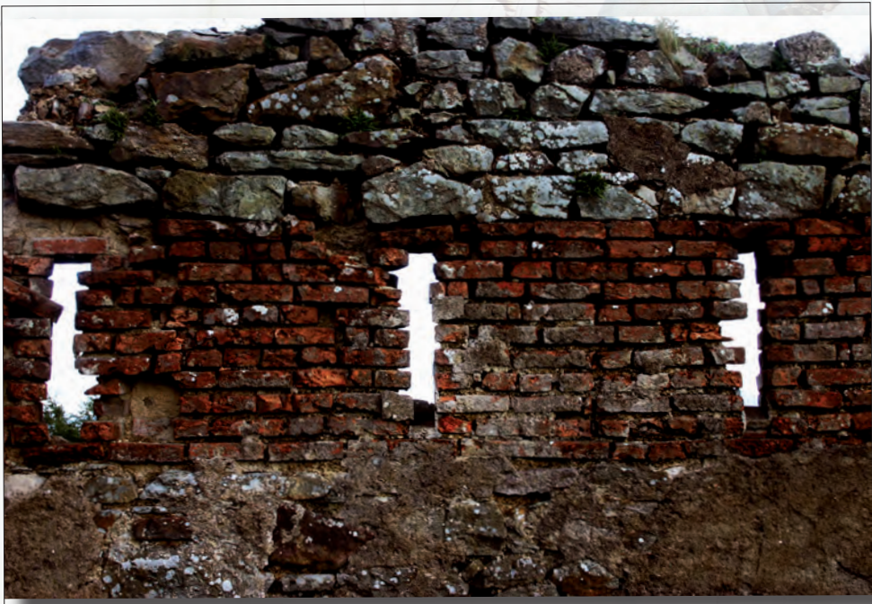
Aspilleras construidas en ladrillo
