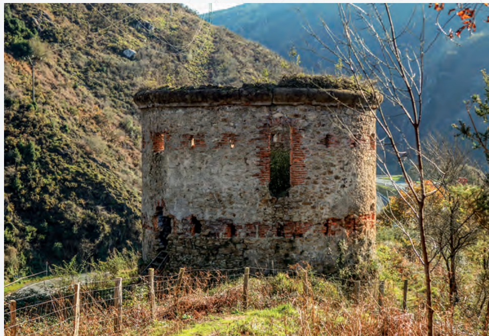
Vista de la torre de Endarlaza en la que se aprecia el acceso, situado en la primera planta.
