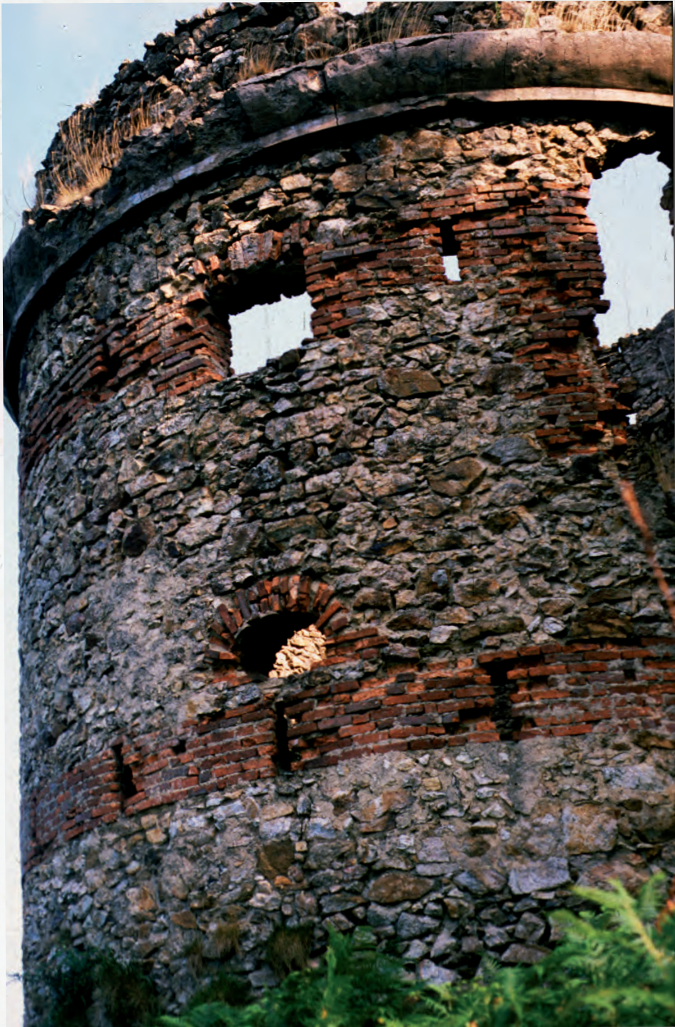
Exterior de la torre de Pika, en el que se aprecian las aspilleras, lucernas, ventanas, cordón, acceso (a la derecha) y vestigios del parapeto de la azotea.
