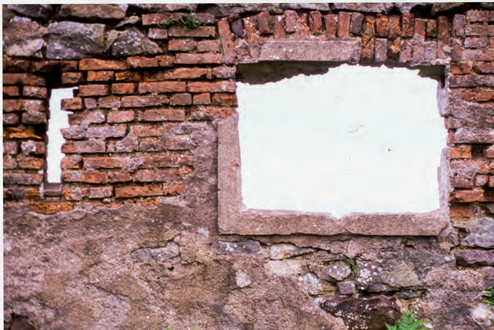
Una aspillera y una ventana de una de las naves del fuerte. Se aprecian los restos del enfoscado, que incluso formaban un marco en torno a la ventana
