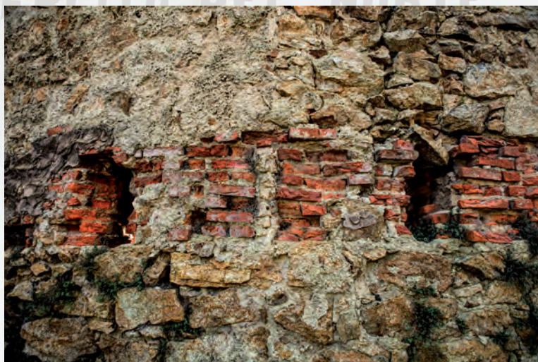
Aspilleras confeccionadas en ladrillo (la central aparece actualmente cegada).
