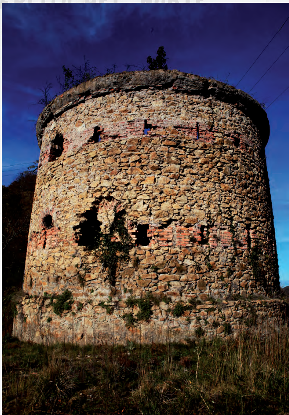
Torre de Endarlatsa. Se aprecia la base, ligeramente sobresaliente del paramento exterior y los dos órdenes de fuegos cuyas aspilleras están confeccionadas de ladrillo. El grueso cordón remata la torre, no habiéndose conservado el parapeto aspillerado de la azotea.
