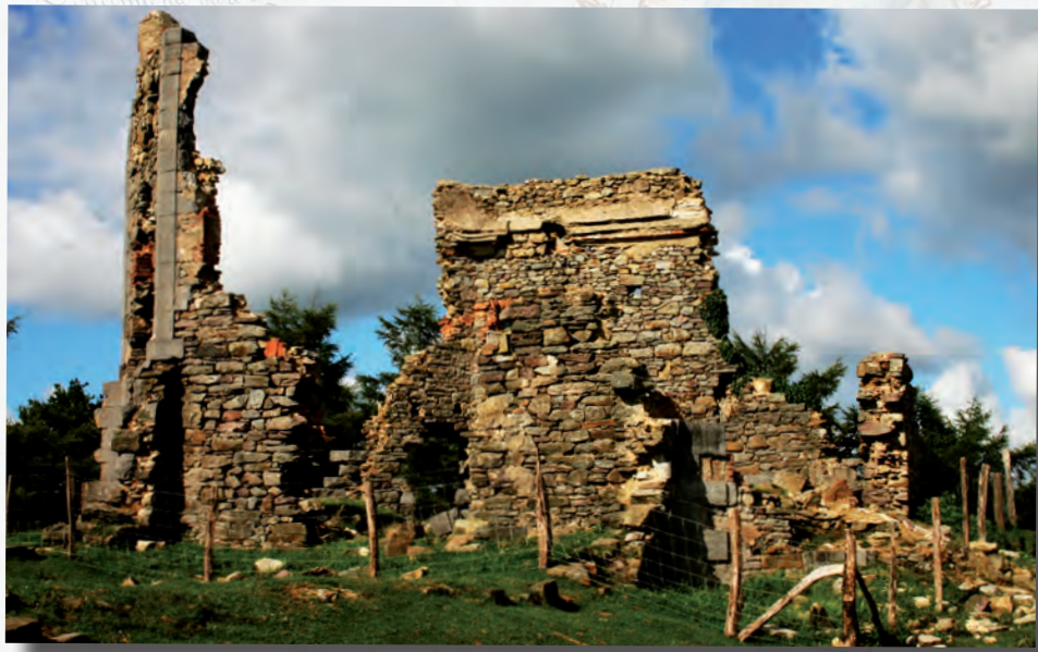
Vista del torreón central del fuerte de Pagogaña, en avanzado estado de ruina.
