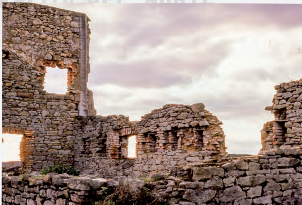
Una de las naves en su confluencia con el torreón. Se aprecian las aspilleras y otros elementos, confeccionados con ladrillo resaltando sobre la mampostería
