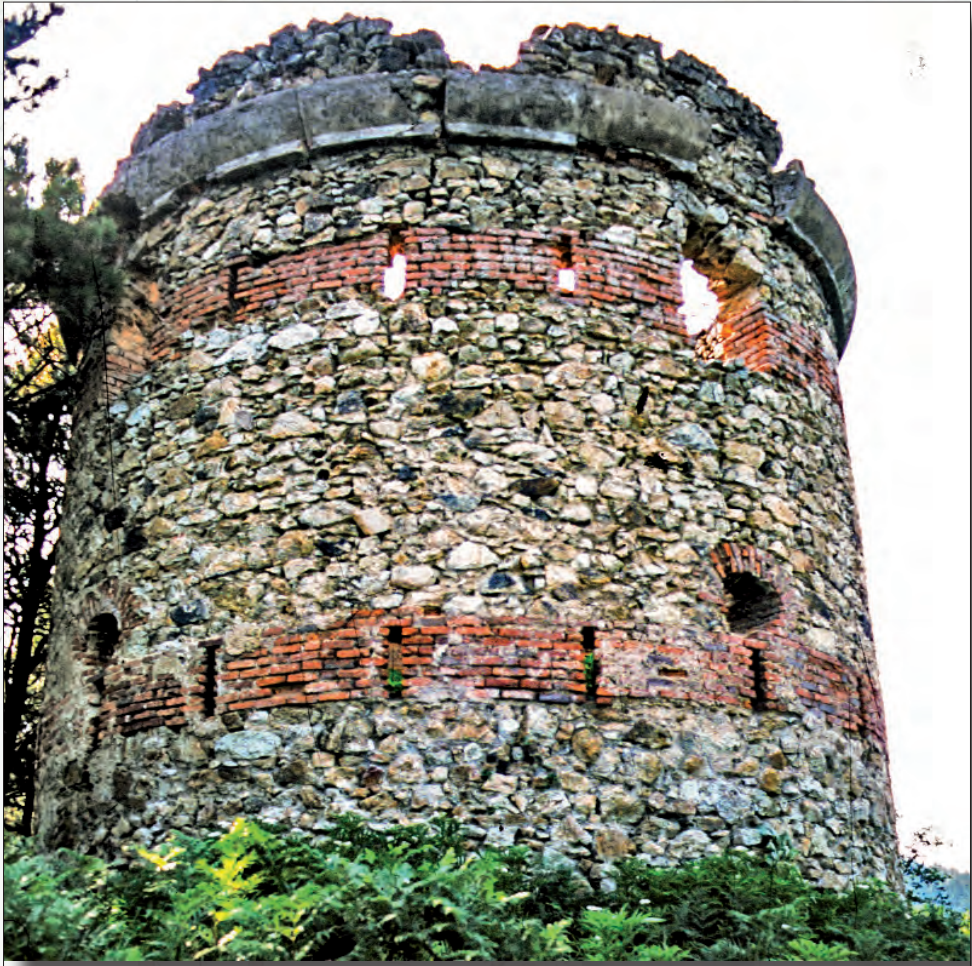
Torre de Pika. Se aprecian perfectamente los dos órdenes de fuegos de las aspilleras enmarcados por muro de ladrillo, el acceso en la primera planta, dos de los vanos semi-circulares de la primera planta, sobre las aspilleras, el grueso cordón y el parapeto de la azotea, al que le falta el almenado.
