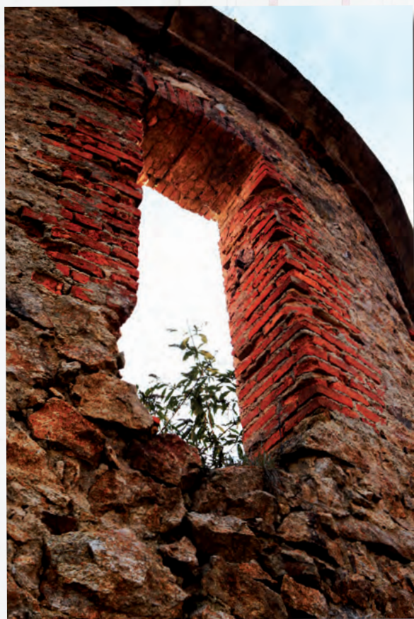
Acceso enmarcado con ladrillo. En este tipo de torres defensivas se encontraba normalmente en la primera planta y no en la planta baja, con objeto de dificultar la entrada del enemigo.
