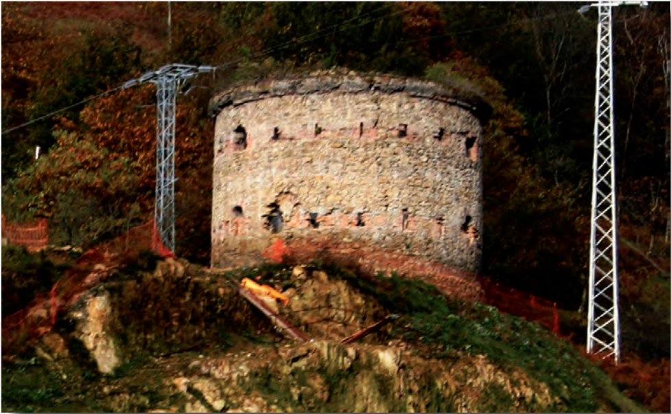
Torre de Endarlatsa , flanqueada por dos torres de transporte de energía eléctrica que degradan notablemente su entorno.
