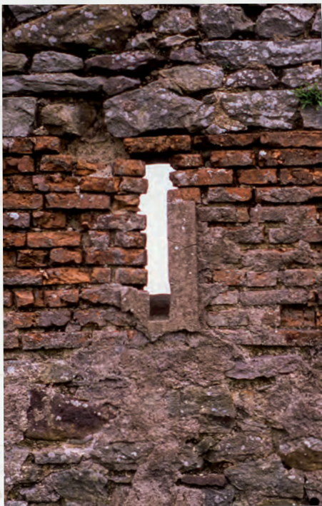
Una de las aspilleras de una de las naves. Realizada en ladrillo, conserva aún parte de del enfoscado que revistió la fachada de la fortificación y que en la actualidad ha desaparecido en su casi totalidad.
