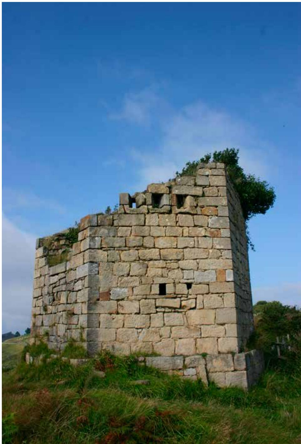
Torre III. Se aprecia la falta en algunos puntos de la mitad de la altura de su muro de cierre.
