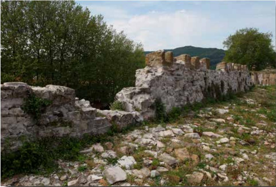
Parapeto de fusilería aspillerado establecido sobre la coronación de la cortina de muralla del sistema abaluartado que el cubo de Sta. María y el baluarte de la Reina.
