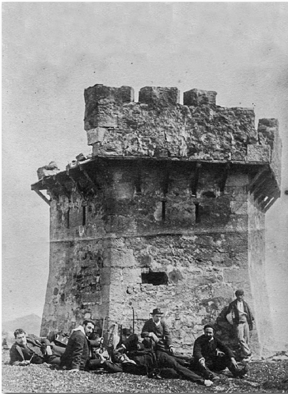
Torre de Santa Bárbara hacia principios del siglo XX, conservando parte del muro perimetral de la azotea aspillerada sostenido sobre una estructura de madera. La pudrición de esta estructura es la principal razón por la que el parapeto que rodeaba la azotea no ha llegado a nuestros días.
