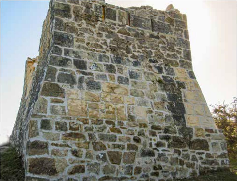
La torre tras la consolidación de 2022. El cuerpo inferior corresponde a la base ejecutada para nivelar el terreno
