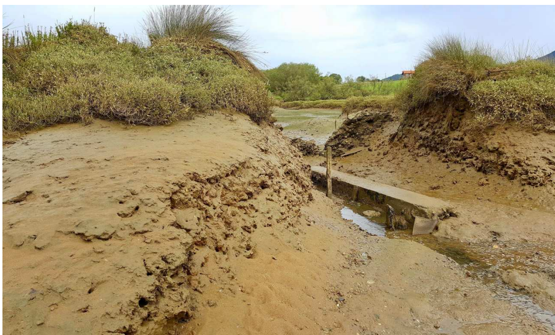
Fotografía 1.2.4. Las marismas de Urdaibai fueron objeto de desecaciones históricas mediante un complejo sistema, hoy periclitado, de diques, esclusas y drenajes. Fotografía de los autores.
