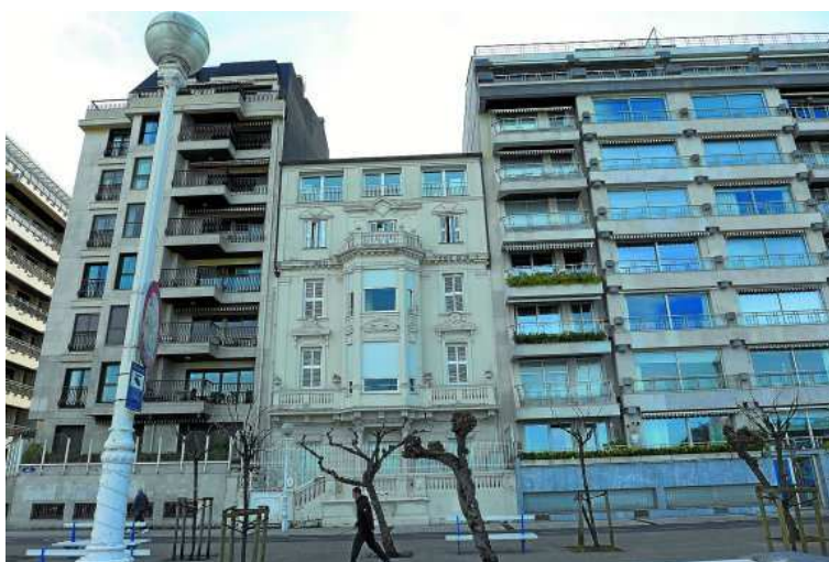
Fotografía 0.1.34. El 1 de febrero de 2017, el Diario Vasco informaba a la ciudadanía de que “La última casa del siglo XIX del paseo de La Concha será vaciada para convertirse en hotel.” Se derribará por completo el interior, se mantendrá la fachada y se reconstruirá por completo hasta alcanzar la altura de los edificios colindantes. Recuperada de https://www.diariovasco.com/san-sebastian/201702/01/ultima-casa-siglo-paseo-20170201001733-v.html
