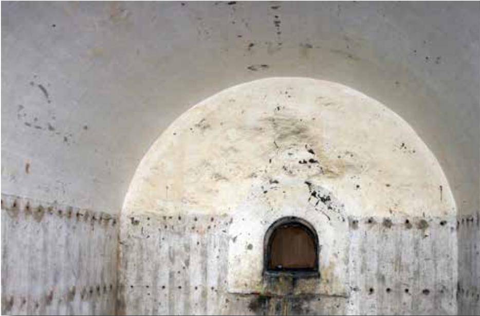
Almacén de pólvora. Se aprecia, al fondo, la ventana que permitía la iluminación mediante una lámpara situada tras un cristal, así como los clavos y marcas dejadas por la madera que revestía las paredes del recinto.
