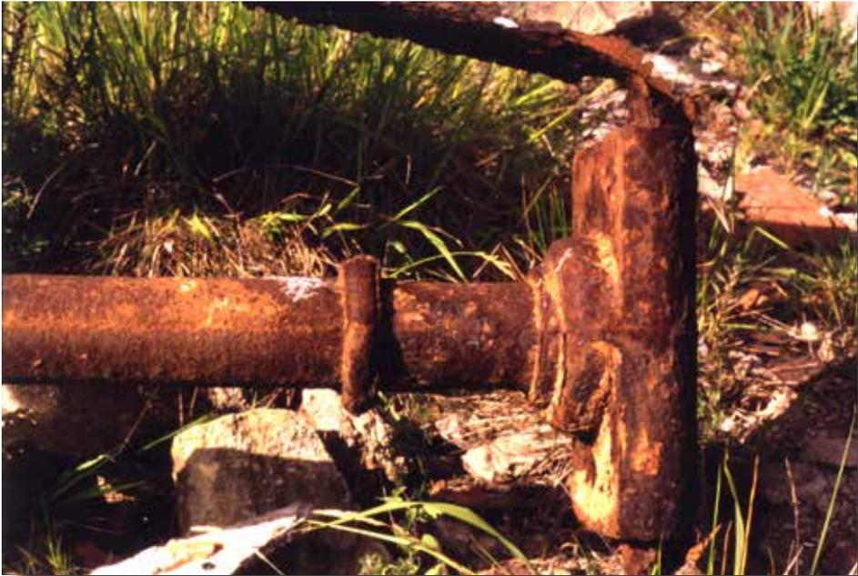
Pilarillo metálico del cuartel. Tras la ruina de la cubierta, los pilarillos están en el suelo.
