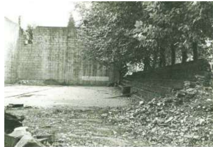
Imagen de la fase de derribo, se supone que la fotografía es de 1970. A.M.Hondarribia
