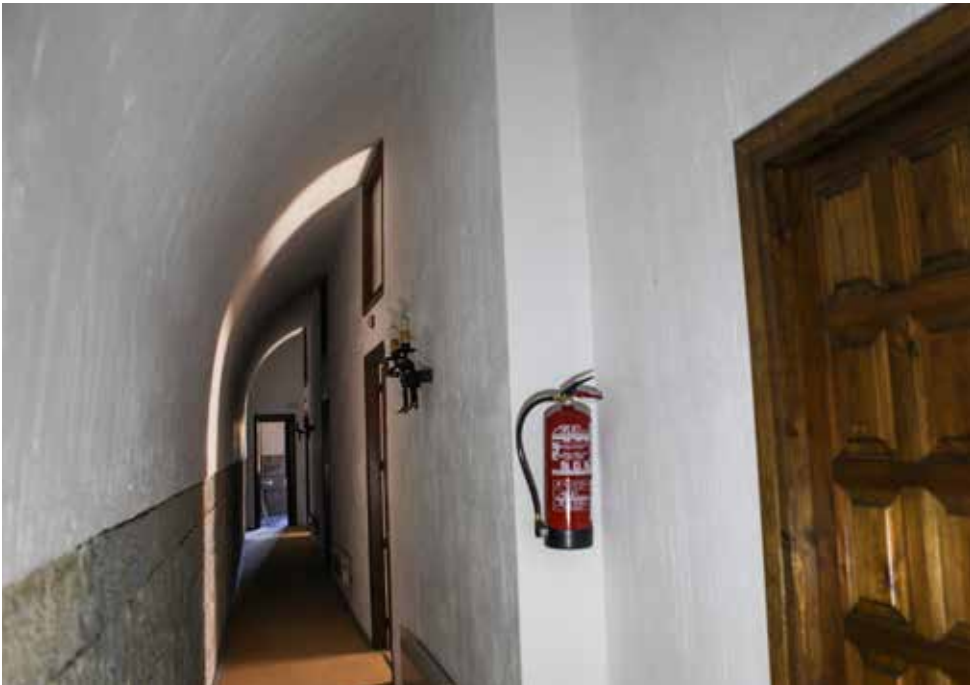
Pabellón para el Gobernador (62). Disponía de siete estancias, incluyendo cocina y WC. La bóveda fue convertida también en habitaciones para la Residencia.
