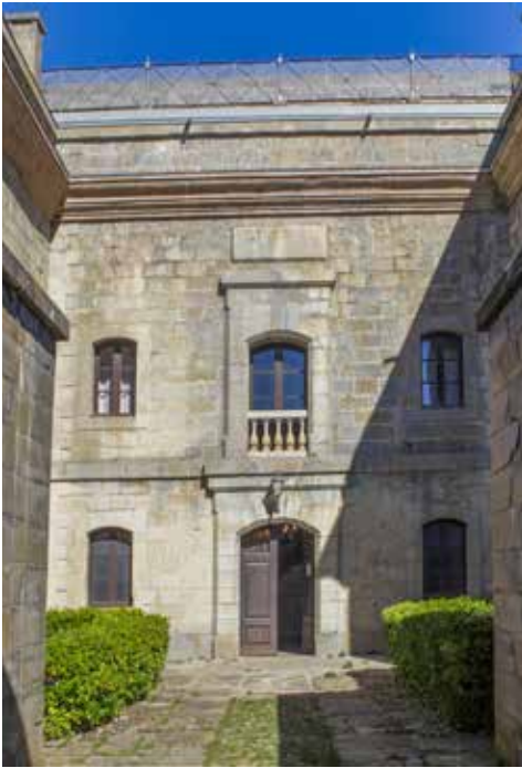
Patio visto desde el acceso.
