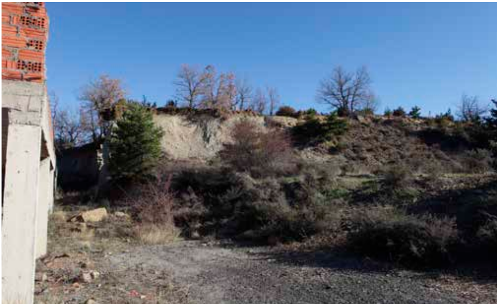
La construcción de la izquierda de la fotografía corresponde a un frustrado hotel que permanece, en parte, inconcluso. Para su construcción se utilizó la cantera.
