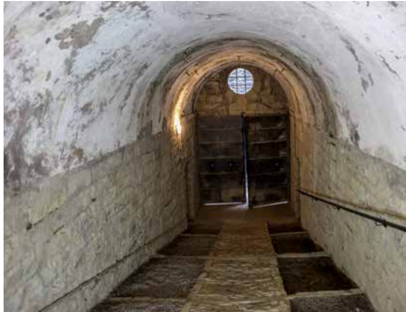
La poterna posee bóveda de medio punto que acoge a una escalera rampa en cuyo final se abren lateralmente los accesos a una galería de escarpa y al frente posee un gran portón metálico con un óculo de iluminación.
