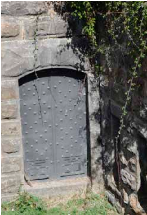
Puerta 1 de acceso al foso en la caponera de gola. (sector occidental). A la derecha se observan varias aspilleras de la caponera.
