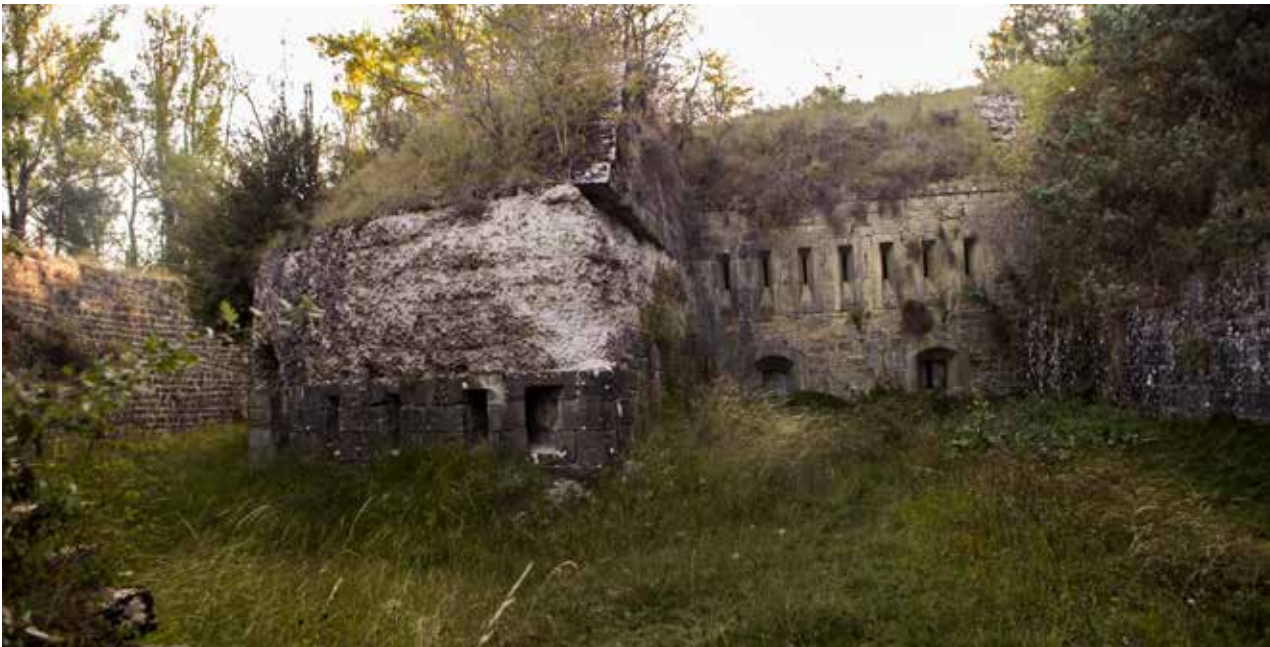
El frente occidental de la caponera de cabeza visto desde el foso, protegido por un orejón (a la izquierda de la fotografía). Se aprecia el orden de fuegos de artillería (inferior) y el orden intermedio de fusilería. El orden de fuegos superior no se aprecia, pero su parapeto se encuentra al descubierto sobre la caponera, formando una azotea.
