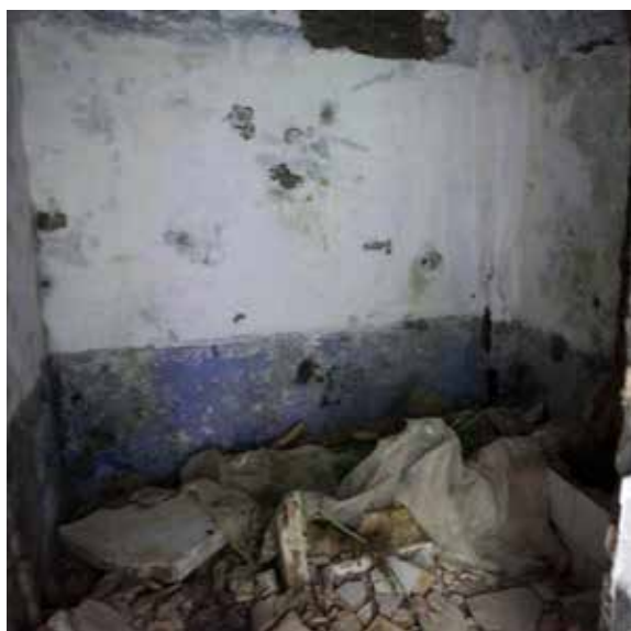
Interior y acceso a las letrinas (3).
