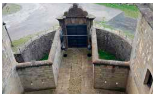
Vista desde el cuartel del acceso aspillerado que constituye el segundo orden de fuegos de la caponera de gola. Se observa también la puerta exterior de acceso al cuartel, con su sistema Derché para el manejo del puente levadizo y rodeada por el foso. La parte más próxima corresponde al pequeño patio del cuartel
