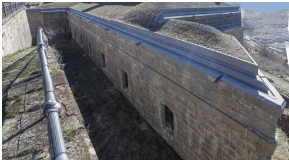
Fachada posterior del cuartel, sector occidental. Al fondo, la caponera del cuartel.
