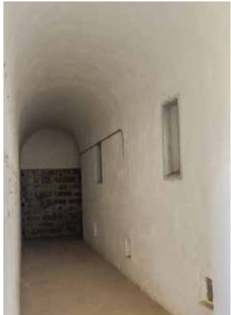
Galería de servicio (4) con las ventanas de iluminación de pólvoras y proyectiles, así como ventiladores..
