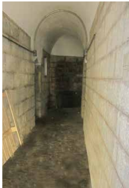
Galería. A la izquierda, el acceso al depósito pequeño (3)
