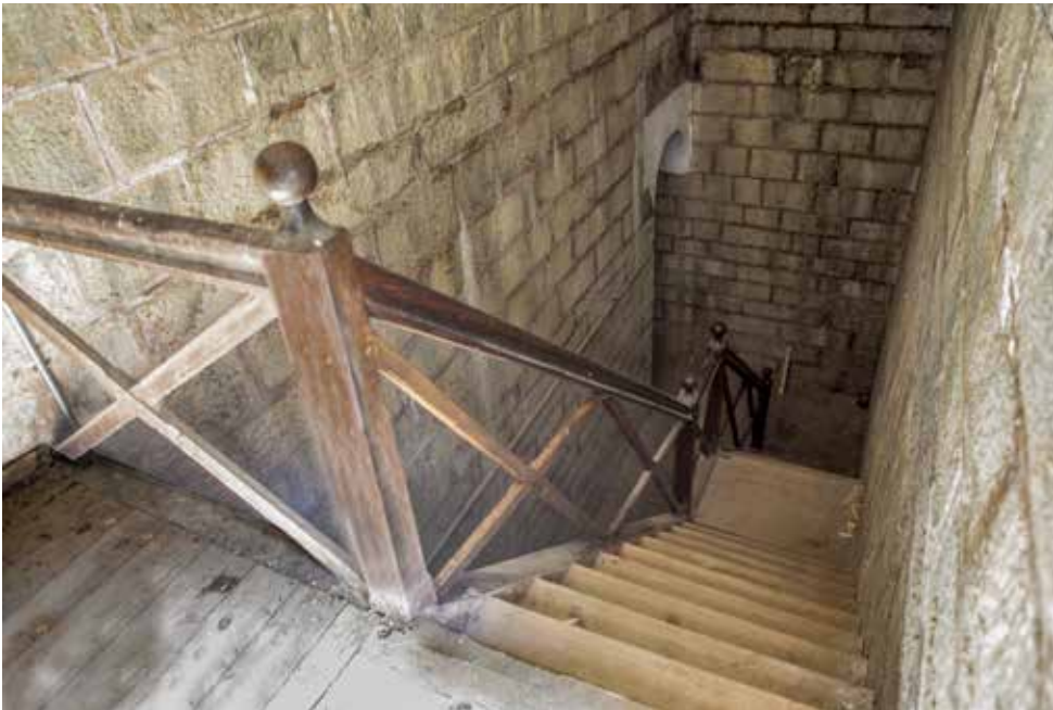
Escalera (6) del almacén oriental, con un descansillo. Vista desde la planta superior (5).
