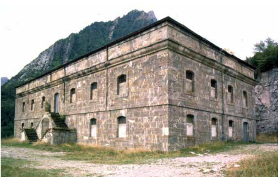
Fuerte de Santa Elena. Sus obras fueron paralizadas cuando todavía faltaba bastante trabajo por realizar. Los principales elementos construidos fueron el camino de acceso, el cuartel (en la fotografía) y varias casamatas, total o parcialmente excavadas en la roca .
