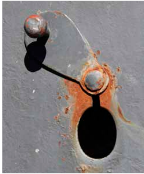
Detalle del roblonado y de la mirilla/aspillera
