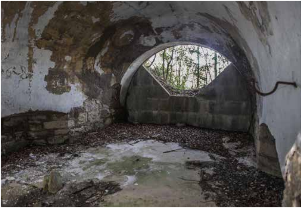
Casamata oriental (12) de la batería. En primer plano un soporte para el juego de armas del cañón
