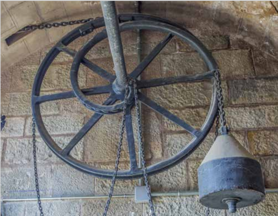
Mecanismo Derché del puente levadizo en la puerta del Cuartel. Falta la cadena delgada.
