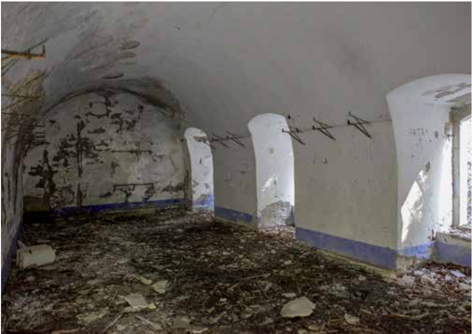
Cuerpo de guardia (11) para 157-20 soldados. En ella se observan dos ventanas y una puerta, así como dos armeros y las palomillas de las tablas de equipo..
