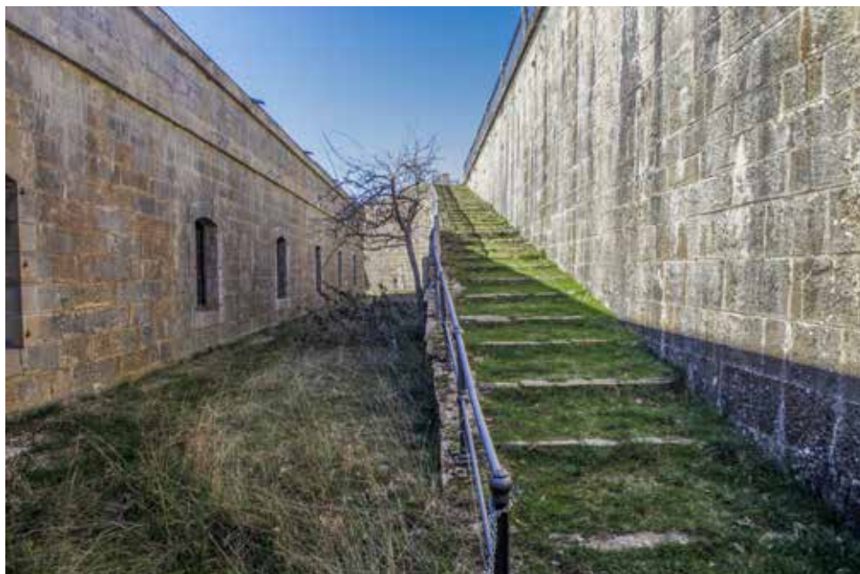
Foso del cuartel. Sector occidental. A la izquierda se aprecian las ventanas del cuartel y a la derecha la rampa escalonada de comunicación del foso del cuartel con la plaza de armas del Fuerte..
