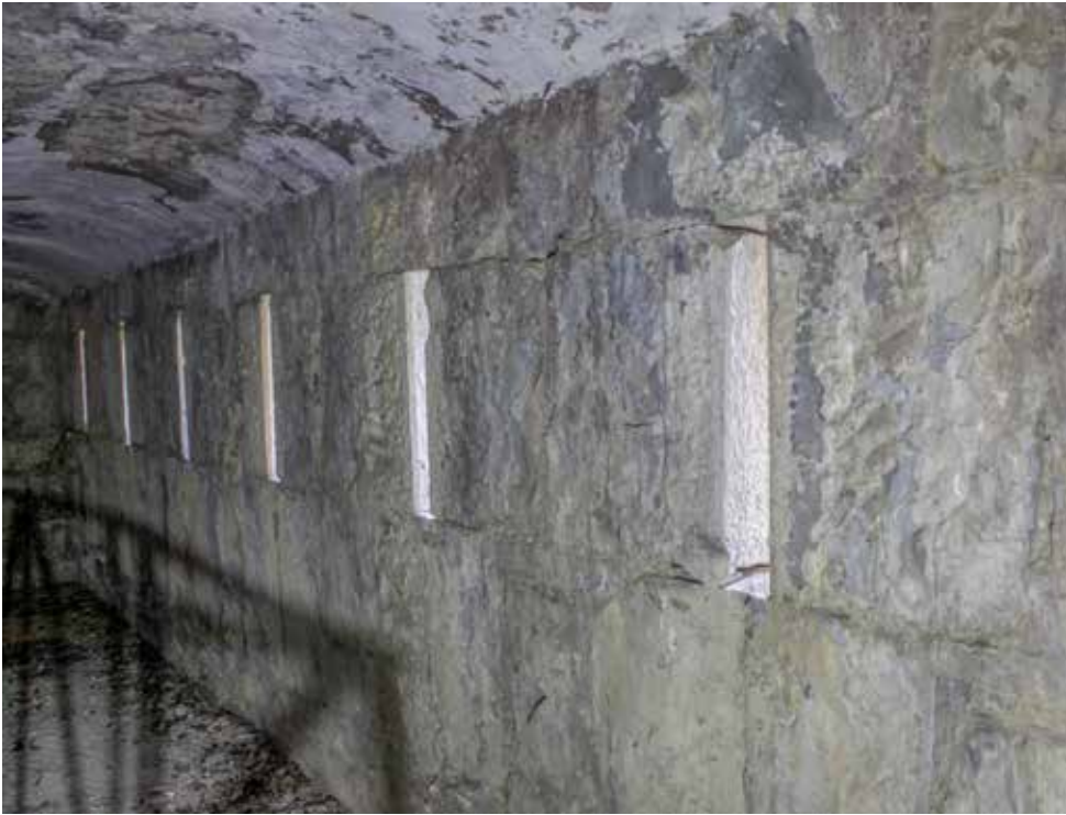
Segundo orden de fuegos de la caponera de cabeza. Aspilleras sobre plataforma.
