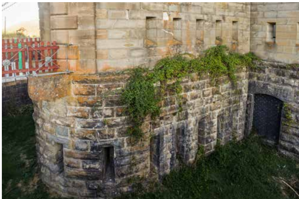
Caponera de gola, con sus dos órdenes de fuegos para fusilería que permiten batir el foso hacia el este. Nótese la puerta este de salida al foso, para servicio del camino cubierto.
