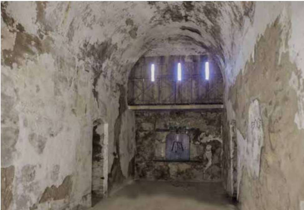
Las escaleras son metálicas y están en muy buen estado. La pasarela de servicio para el segundo orden de fuegos tiene también estructura metálica.
