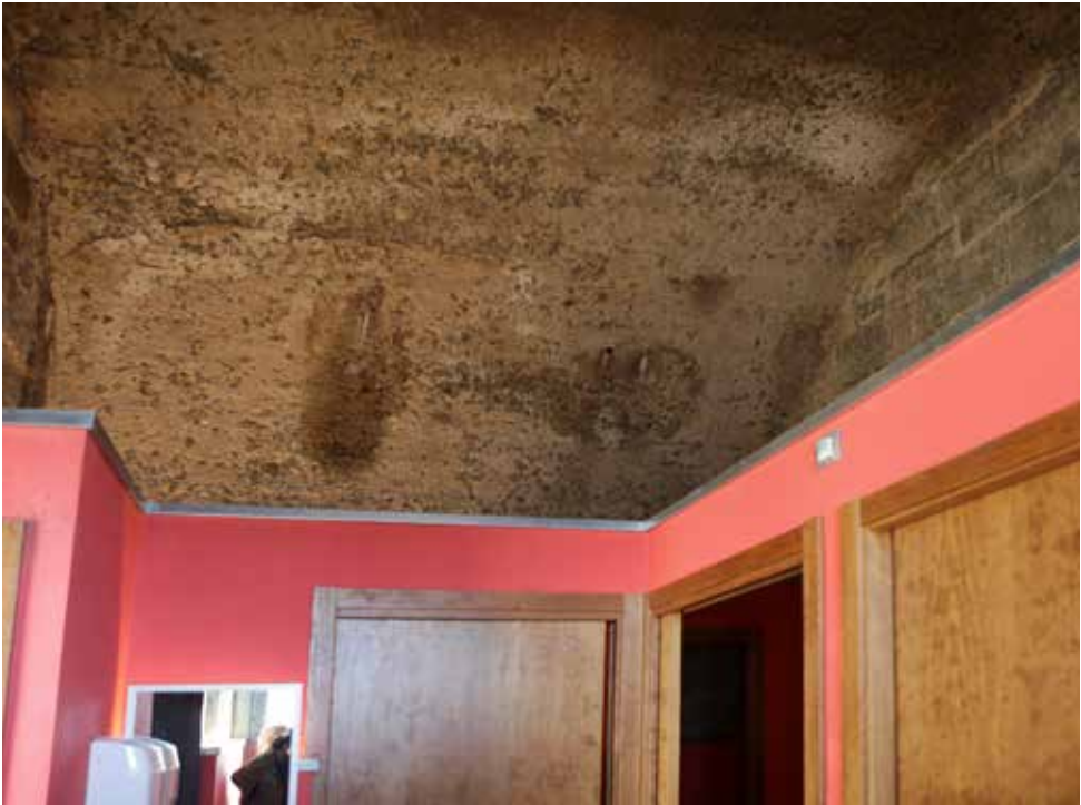
Cuerpo de guardia para oficial, reutilizado como servicios bajo la bóveda de hormigón.
