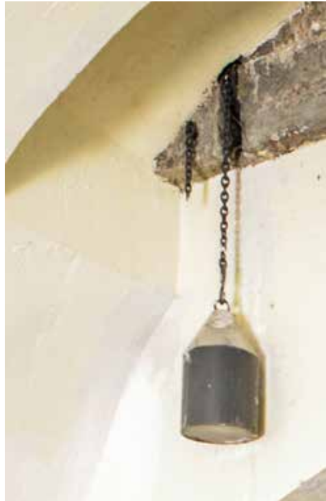
Contrapeso del puente levadizo.
