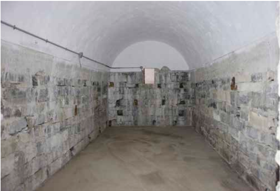
Depósito de pólvoras (2) visto desde el acceso. Se aprecia en el muro del fondo el nicho de luces. El suelo, de hormigón, es de reciente factura, como el de todo el recinto.
