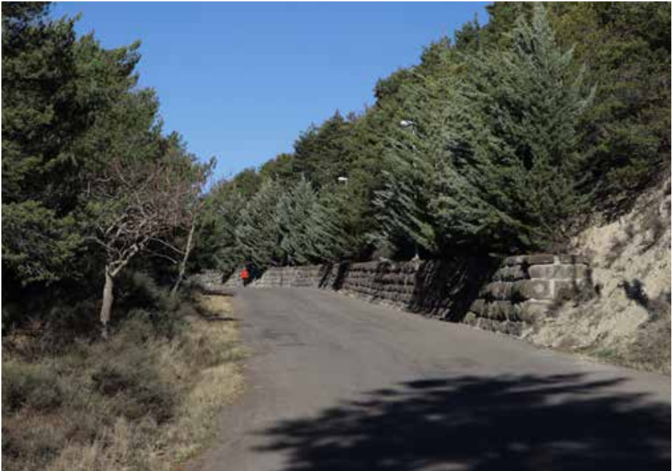
La topografía del monte obligó a ejecutar la carretera realizando numerosas curvas cerradas, desmontes y terraplenes, siendo obligada la construcción de diversos muros de contención revestidos de sillarejo, tal y como se aprecia a la derecha de la fotografía.
