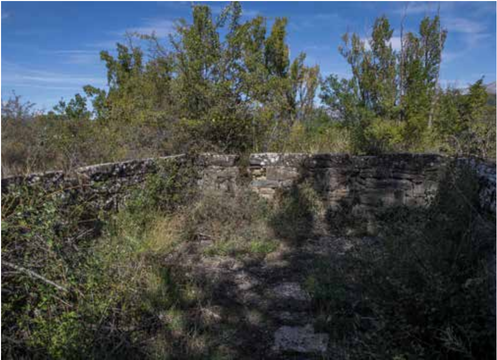
Azotea de fusilería sobre la caponera de cabeza, constituyen su tercer orden de fuegos de fusilería.
