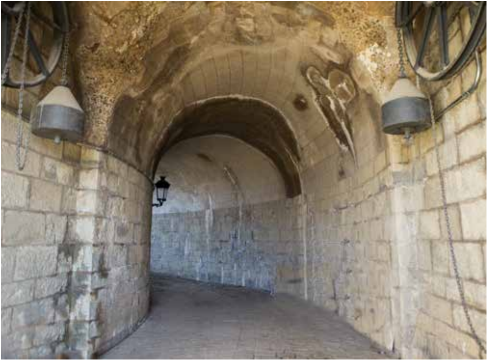
Interior del túnel de acceso con el sistema Derché para maniobra del puente levadizo.
