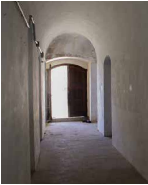
Acceso a la galería de servicio (4) del almacén occidental. El acceso de la derecha es el almacén de proyectiles y los de la izda el cuarto de carga y de cartuchos Mauser.
