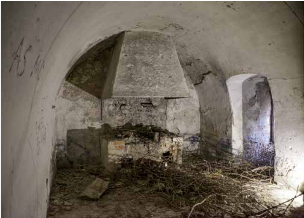
Cocina (13) de la batería, en la que destaca el fogón y la campana. A la derecha, el acceso a la cocina desde el camino de servicio.
