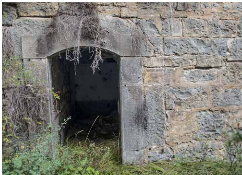
Acceso a las letrinas. Se aprecia el aparejo de mampostería concertada con las juntas tomadas. Las jambas y arco son de sillería.
