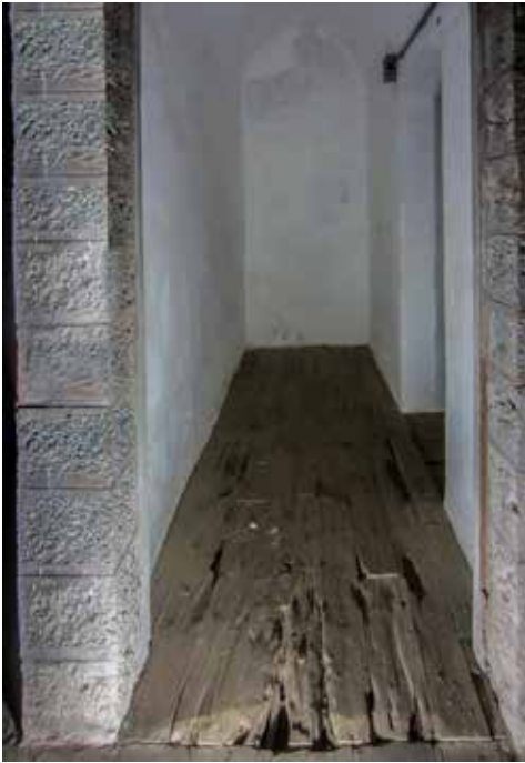
Depósito de munición oriental. Estancia de protección (10). Entarimado original.
