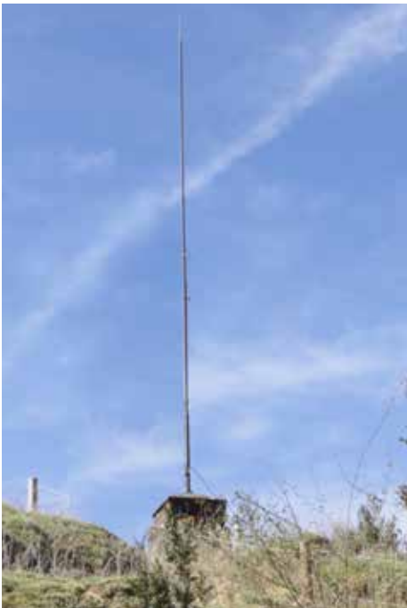
Pararrayos sobre los almacenes de munición occidental y oriental.
