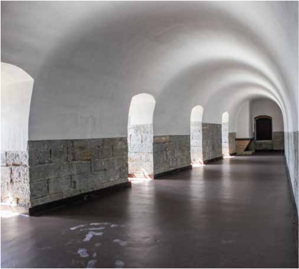
Bóveda (65) que adecuadamente compartimentada albergó principalmente los pabellones de tres tenientes, así como su cocina, sala de estar y cuarto de para un ordenanza.
