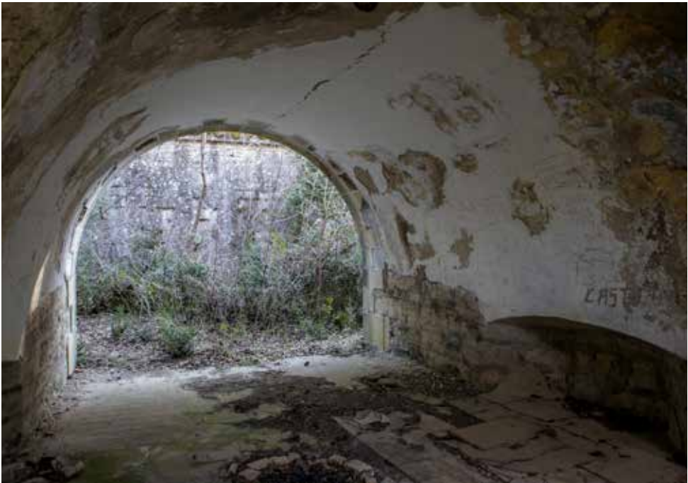
Casamata central tipo Haxo, abierta por la gola. Al fondo la calle de servicio y muro de contención del monte que se construyó tras un deslizamiento de tierras..
