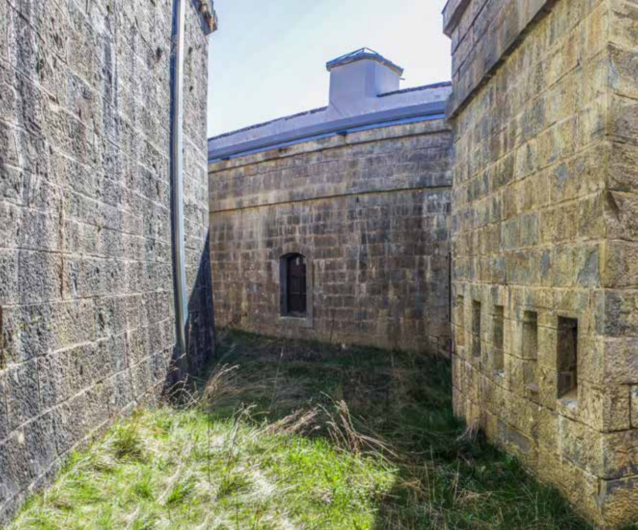
Foso del cuartel. Sector central. Fotografía tomada desde el punto 1. En primer plano la caponera de cabeza y a su derecha la entrada al cuartel.
