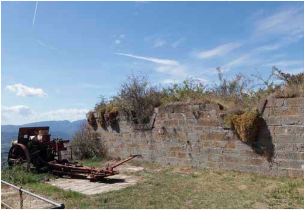
Emplazamientos en cañonera n.2 y 3. Se aprecian las cañoneras. El obús Schneider de 155 está apuntando por encima de una barandilla, prescindiendo de su posición natural que sería en una de las cañoneras (su altura de rodillera es muy baja para las mismas)
