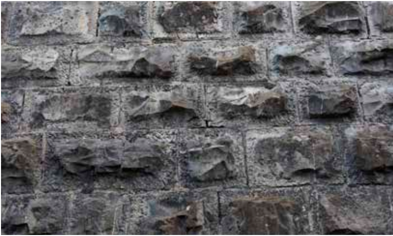
Mampostería concertada y almohadillada. en la escapa del foso en las inmediaciones de l cuartel. Está cerca de considerarse sillarejo.
