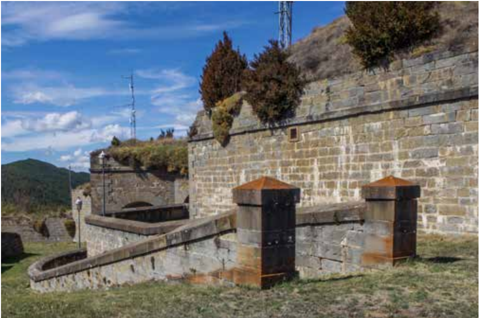
La rampa en trinchera situada entre los pretilos centrales es la que conduce a la poterna de la semicaponera occidental.
