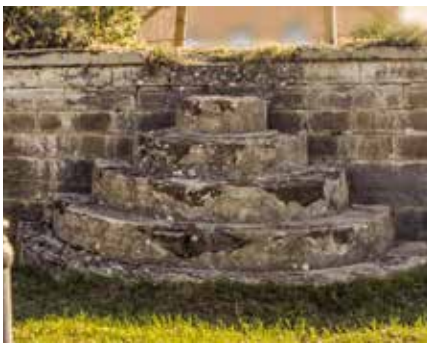
Emplazamiento para una pieza de artillería o ametralladora (¿antiaérea?) sobre el parapeto que correspondería a la cañonera 13. La escalera de hormigón parece realizada en fecha muy posterior al Fuerte..
