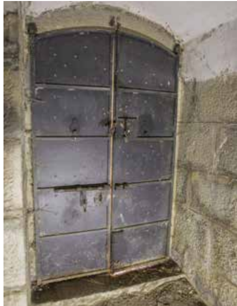
Puerta 5 de acceso al foso en la semicaponera oriental. Vista interior.
