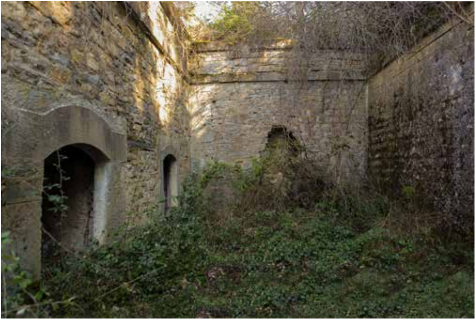
Sector final de la calle de servicio. A la izquierda ventana y acceso a la cocina de la batería oriental. El muro central cierra la batería posee un boquete. El de la derecha es el añadido.
