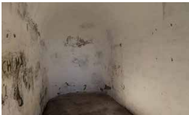
Interior del abrigo, dotado de bóveda de horno en el extremo opuesto al acceso.
