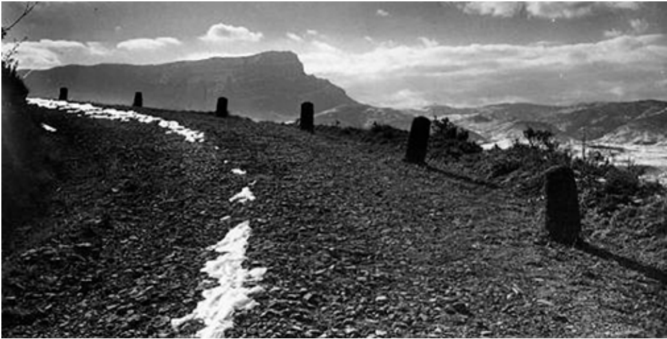
Carretera de acceso a Rapitán a principios del siglo XX con los guardarruedas.
