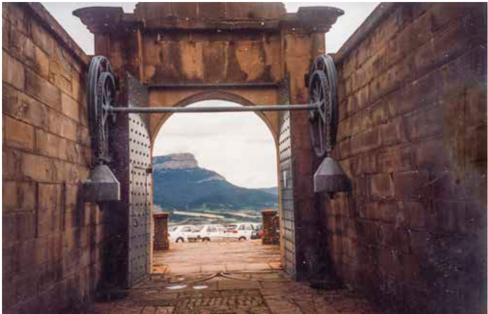
Planta superior, al aire libre, en la que se abre el acceso al patio del cuartel.
