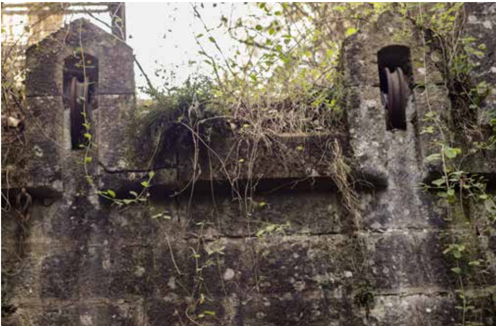
Poleas para maniobra de uno de los dos puentes levadizos que comunican el foso con la caponera de cabeza y con la poterna de acceso a la misma desde el núcleo del Fuerte.
