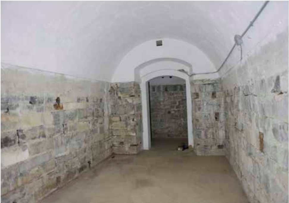
Acceso al depósito de pólvoras (2) visto desde el interior. El original tenía el suelo y las paredes revestidos de madera, así como la puerta, también de madera.
