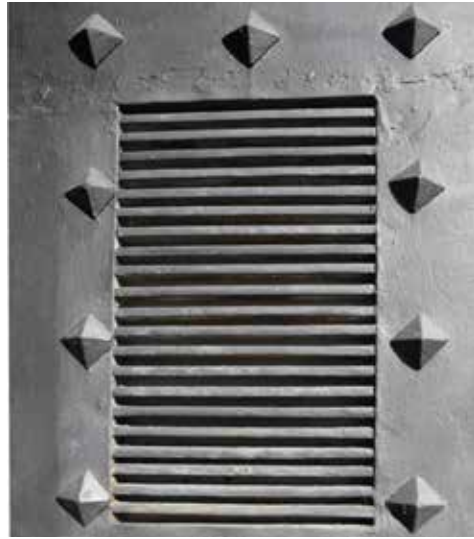
Cerradura de la puerta del abrigo y abajo, exterior de la rejilla de ventilación
