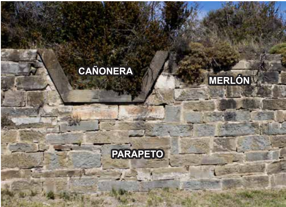
Cañonera (rebaje en el parapeto), merlón (zona no rebajada del parapeto entre dos cañoneras)
