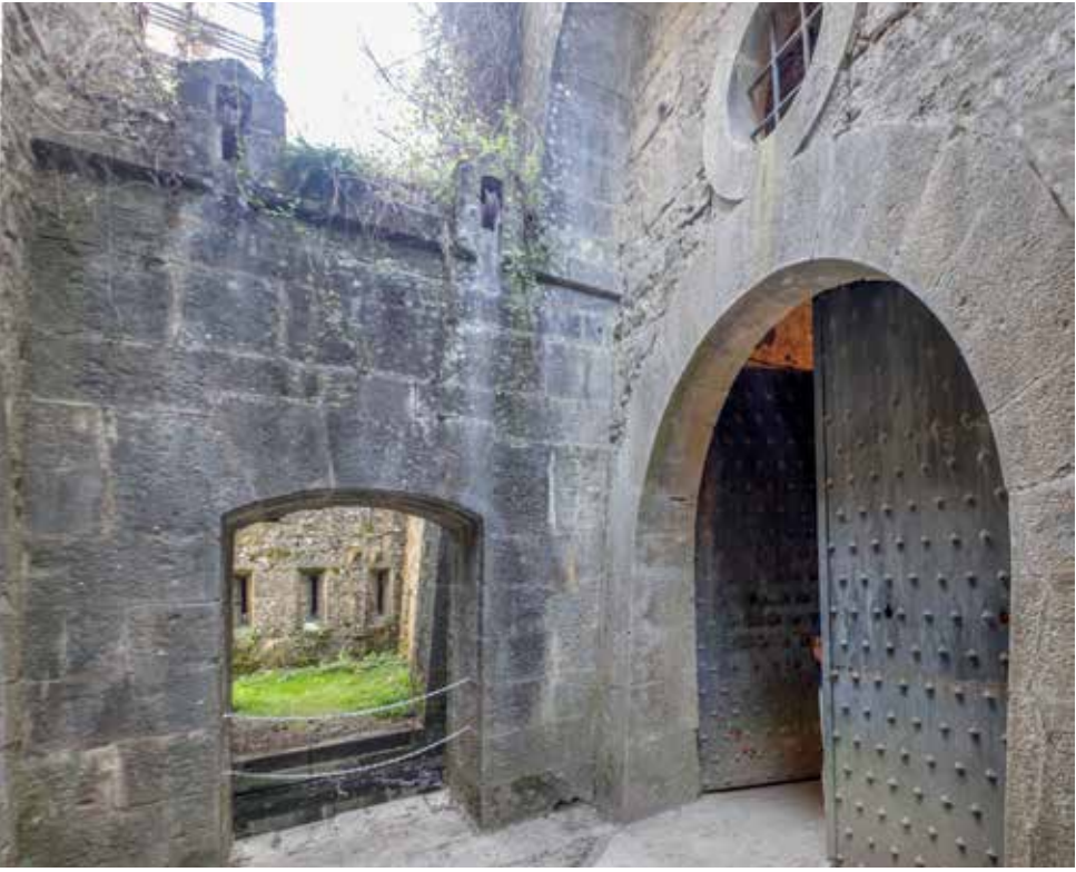
A la derecha de la fotografía, la puerta metálica que cierra la poterna de acceso, con su óculo superior. A la izquierda, una de las dos puertas con fosetes y puentes levadizos que cierran el foso de la caponera. Al fondo tres aspilleras de la galería de escarpa.
