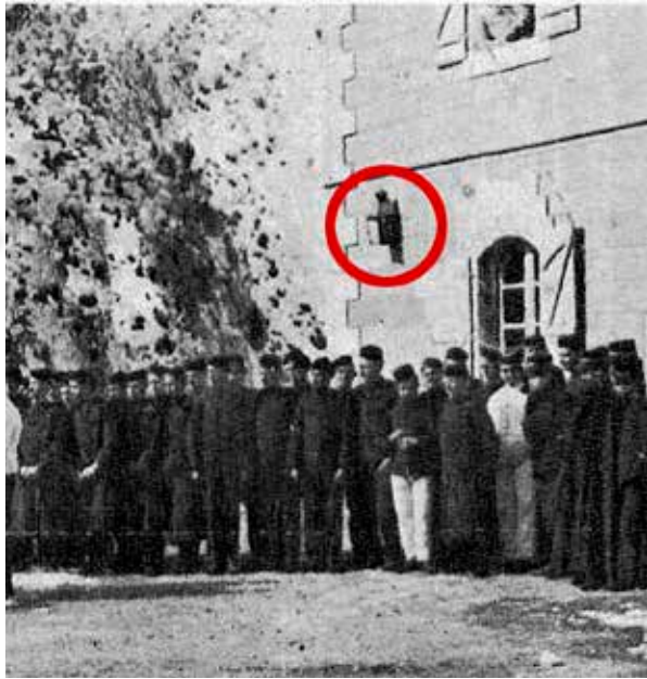
Se ha señalado con un círculo uno de los faroles que iluminaban el cercano fuerte de Coll de Ladrones, colgado de la fachada principal del edificio de pabellones. La iluminación del fuerte de Rapitán sería probablemente similar.
