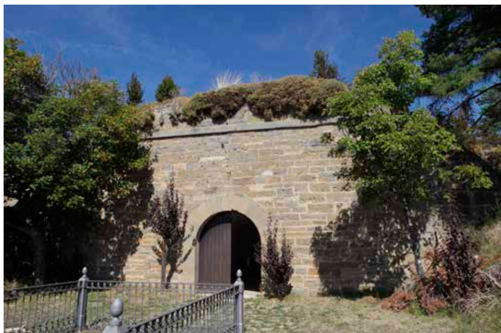
Exterior del través de cabeza visto desde la plaza de armas, con su puerta actual.
