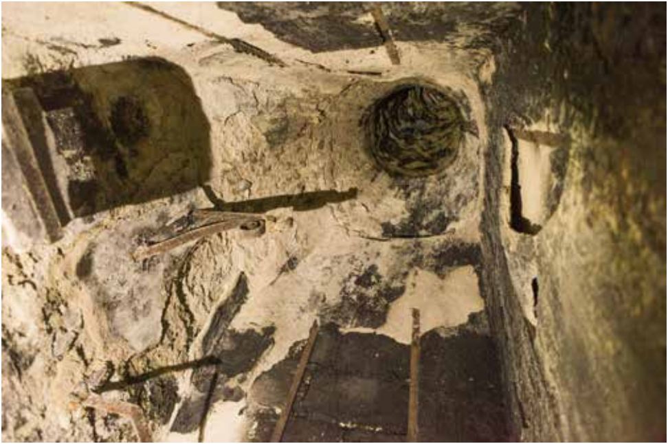
Fotografía a contrapicado del interior de la campana de la cocina. Se aprecia el tubo de salida del humo y el gancho para colgar la marmita.
