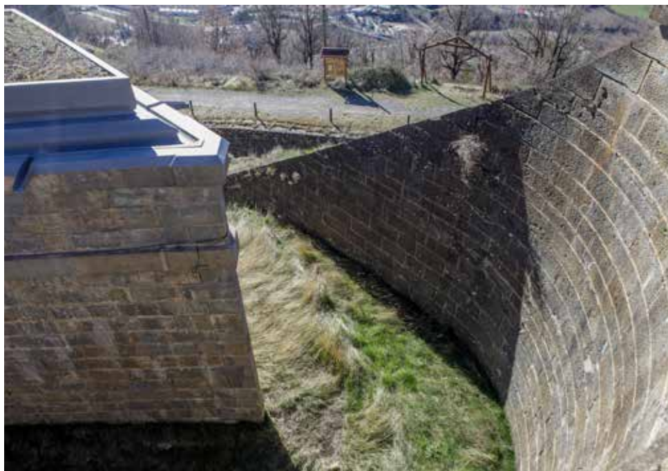
Foso del cuartel en su extremo occidental. A la izquierda se aprecia la parte trasera de la semicaponera y, frena a ella, el redondeo de la contraescarpa
