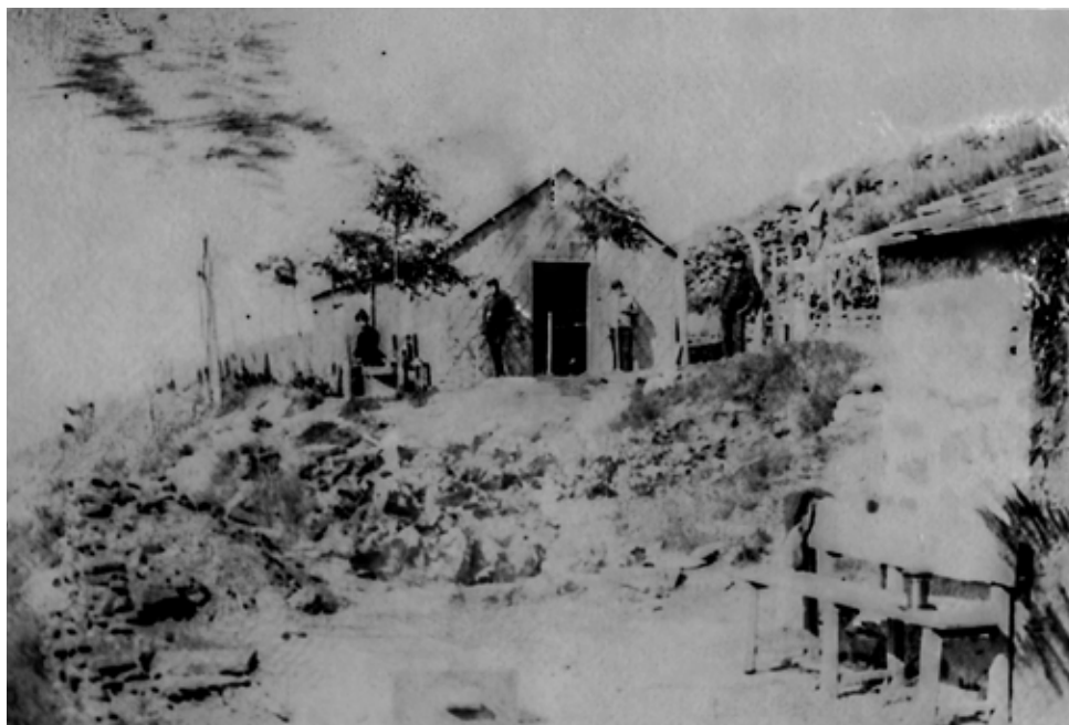
Fotografía que incorpora varios de los barracones que probablemente formaban parte del campamento de obra del Fuerte.
