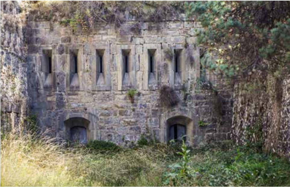
Flanco occidental de la caponera de cabeza, con sus dos cañoneras y siete aspilleras. Un tercer orden de fuegos estaría formado por el parapeto de la azotea.
