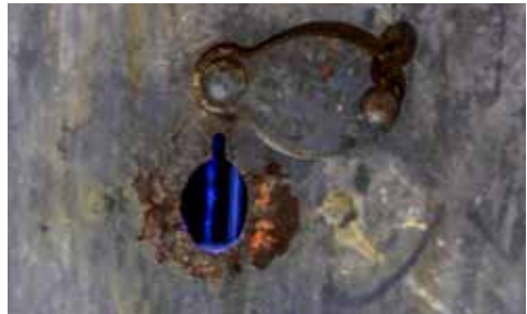
Mirilla-aspillera de la puerta metálica de salida de la caionera de cabeza al foso
