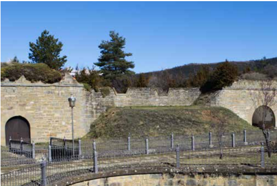
Emplazamientos en cañonera 8 y 9, situado entre el abrigo (izquierda) y el través/casamata n. 5 (derecha)..
