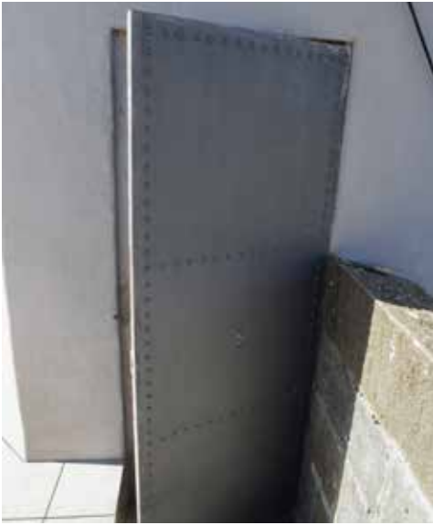
Puerta metálica roblonada con mirilla.
