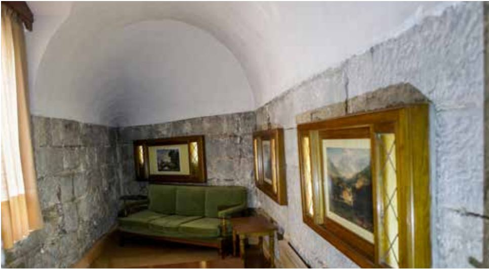
Interior de una semicaponera del foso del cuartel, convertida en zona de estancia de una habitación en la rehabilitación de finales del siglo XX. Las aspilleras están convenientemente enmarcadas con objeto de disimularlas..
