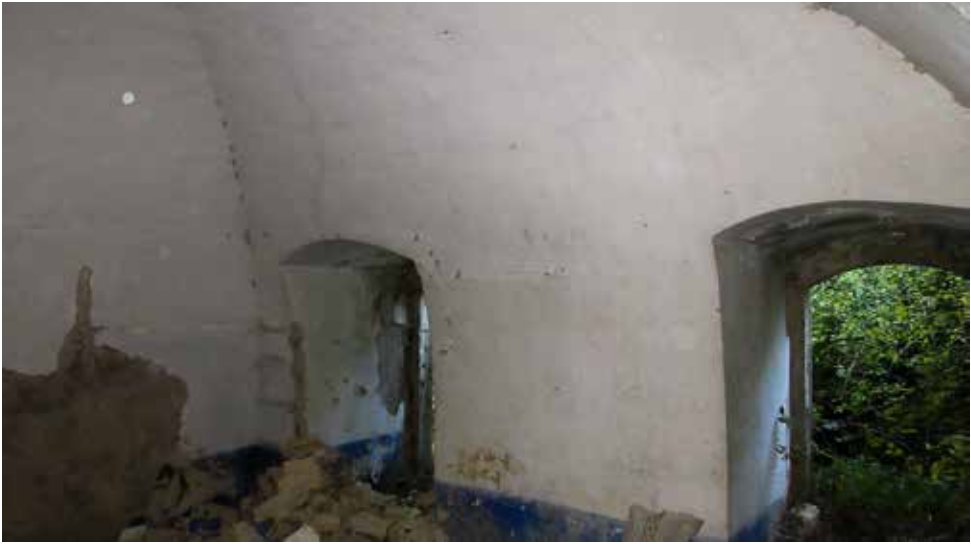
Interior del pabellón del oficial (4). A la izquierda la puerta con acceso desde la calle de circulación y a la derecha la única ventana que posee
