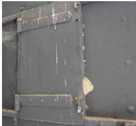
La misma portezuela de la fotografía de la izquierda, cerrada, ocultando la rejilla de aireación para más seguridad.
