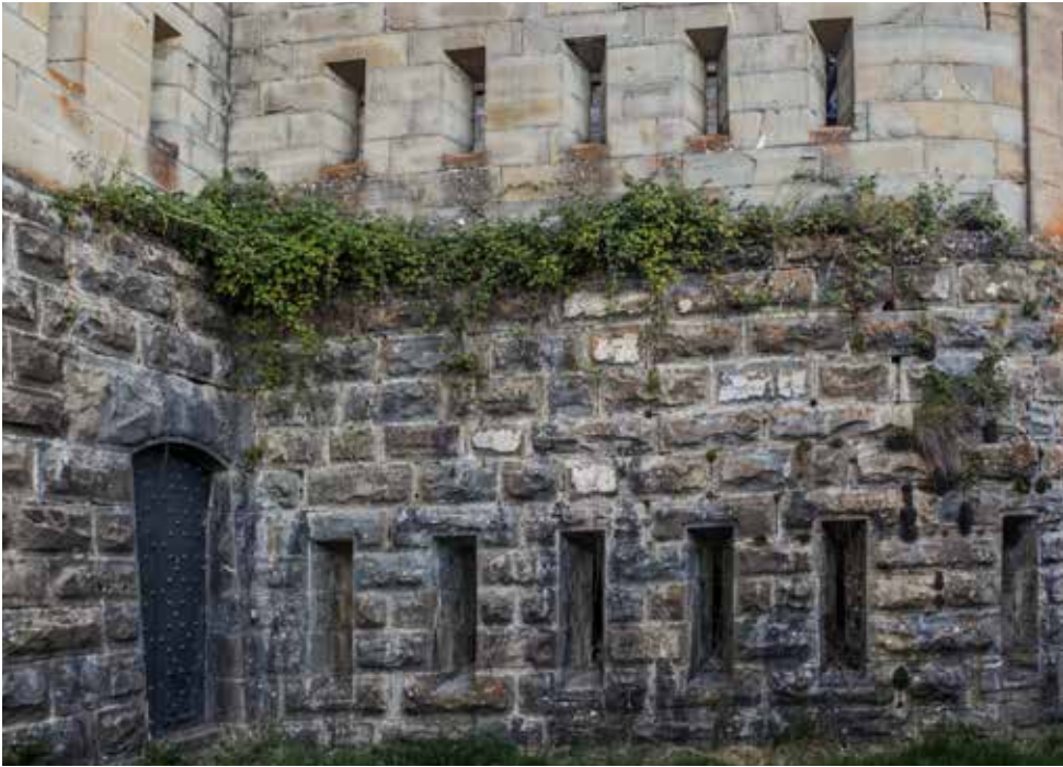
Caponera de gola, con sus dos órdenes de fuegos para fusilería que permiten batir el foso hacia el oeste. También se aprecia la puerta oeste de salida al foso.
