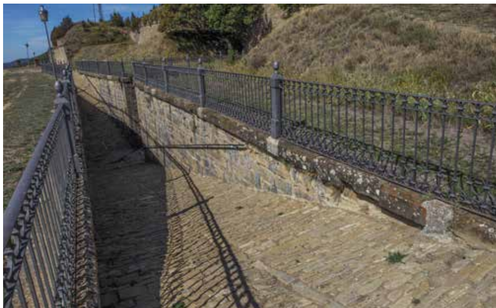
Acceso a la caponera de cabeza por una de las dos rampas confluyentes. En la parte inferior se aprecia el inicio de una única trinchera que desemboca en la poterna de acceso.
