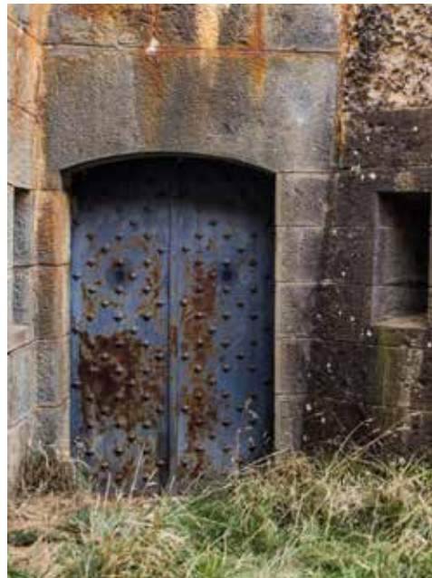
Puerta 5 de acceso al foso en la semicaponera oriental.
