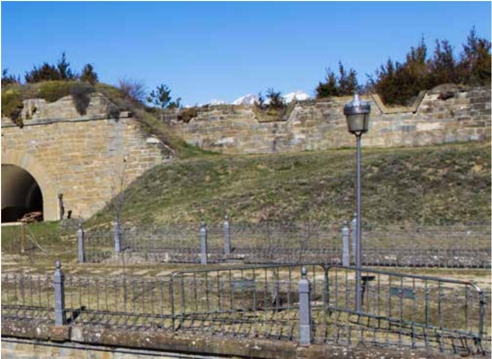
Emplazamientos en cañonera 6 y 7, con su rampa. A la izquierda se aprecia parte de la casamata n. 4
