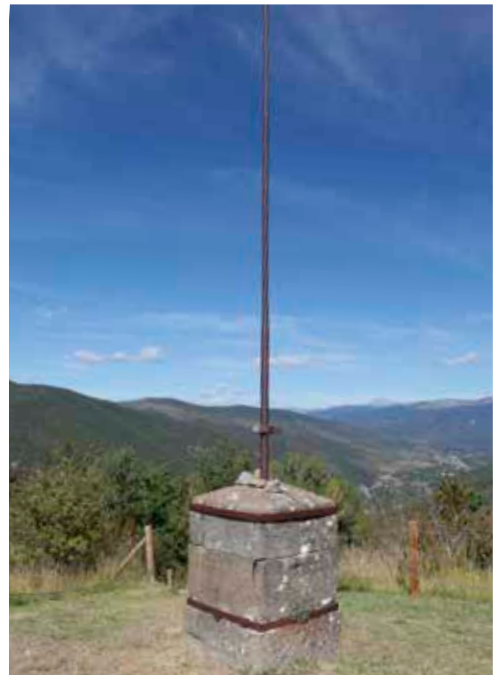
Pararrayos sobre los almacenes de munición occidental y oriental.
