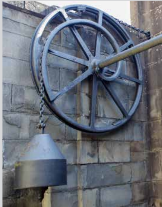
Mecanismo Derché del puente levadizo en la puerta del Cuartel. Falta la cadena delgada.
