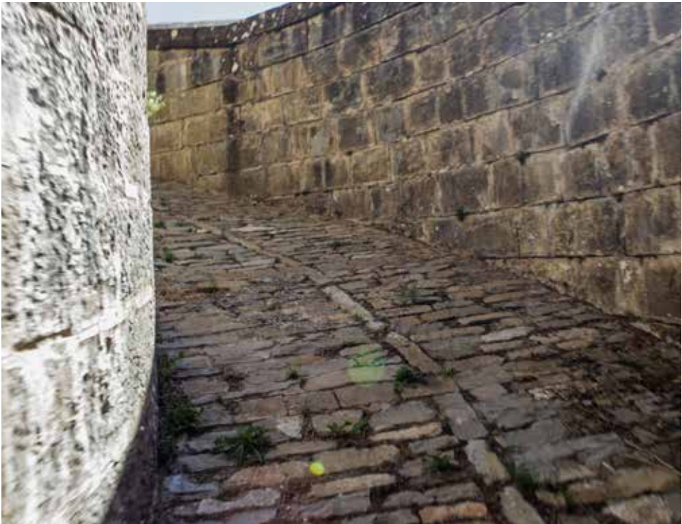
Rampa en trinchera que conduce a la poterna de la semicaponera occidental.
