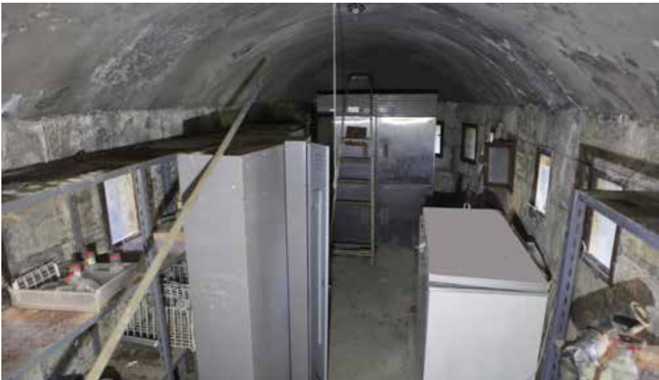
Interior de la planta inferior, utilizada actualmente como almacén de cocina.
