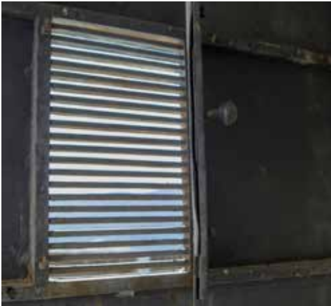
Rejilla suficientemente tupida como para impedir la entrada de cascos de proyectiles, dota de una portezuela con su cierra.
