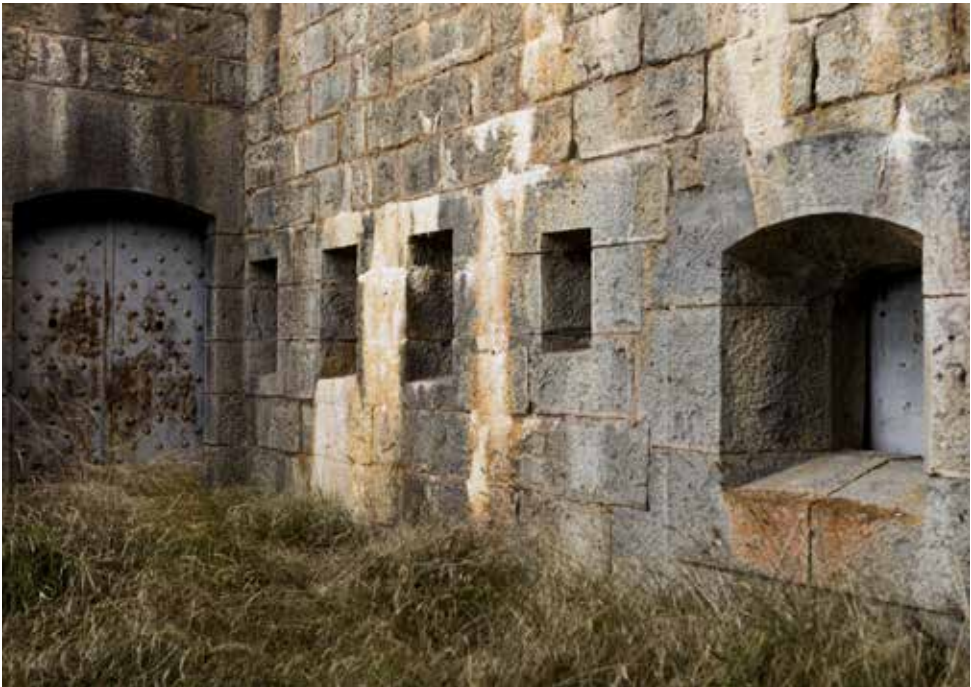
Puerta de salida al foso (8) de la semicaponera occidental y una parte del frente de la misma de la que se observan la cañonera (3) y cuatro de sus aspilleras.
