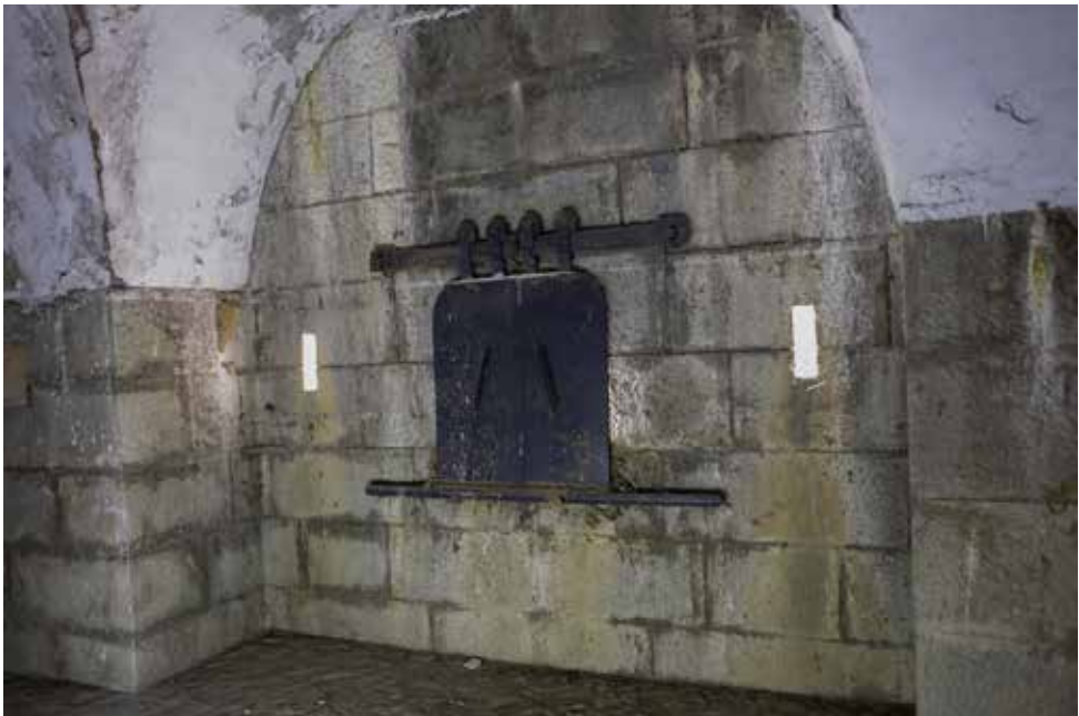
Vista parcial de la casamata (3) de la semicaponera oriental, con su cañonera con la porta perfectamente conservadas y dos dos aspilleras laterales.
