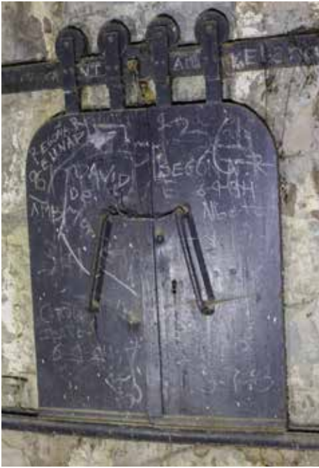
Porta deslizante para la cañonera de los cañones Maxim-Nordenfelt de 5,7 cm
