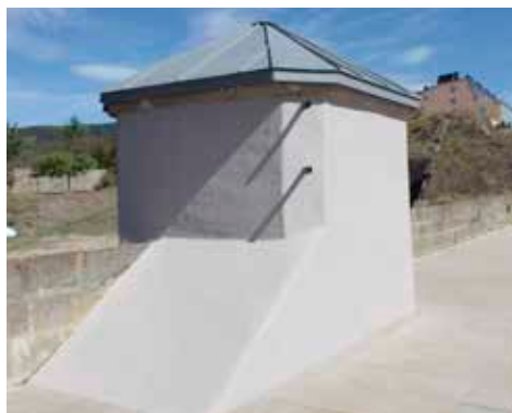
Casetón cubriendo la caja de escaleras este.
