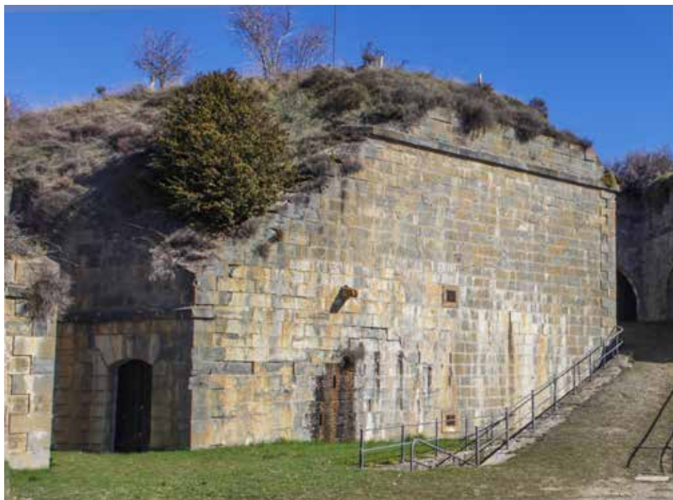
Exterior del depósito oriental de munición. La puerta corresponde a la planta inferior.
