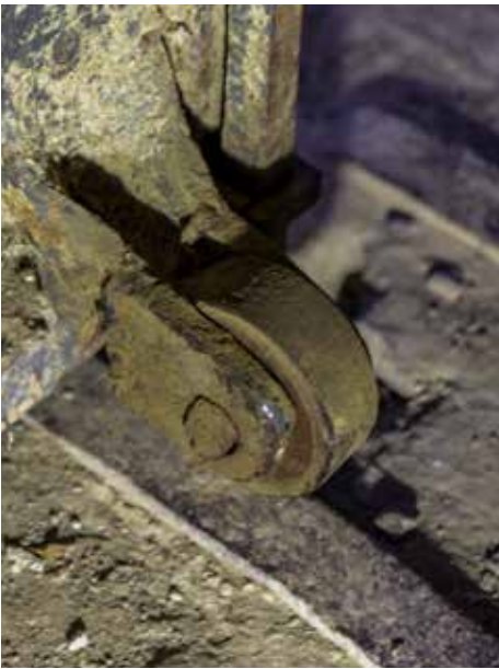
La puerta metálica que cierra la poterna dispone de ruedas y carrileras para facilitar su movimiento.
