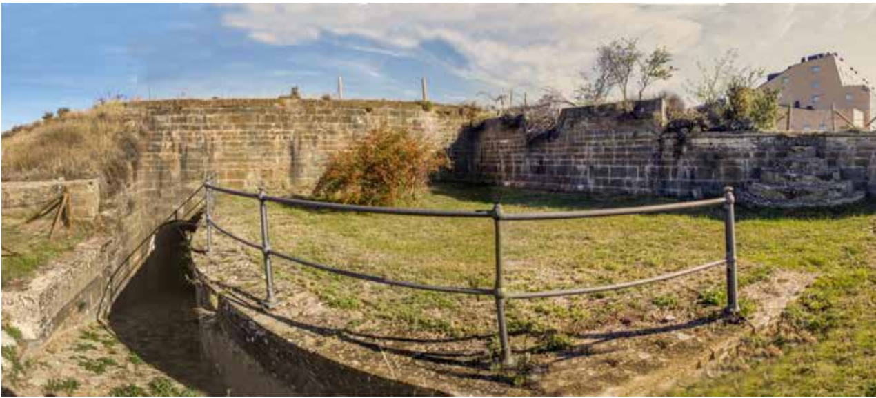
Emplazamientos en cañonera n. 12 y 13. El 13 es más bien una barbata, ya que actualmente falta el derrame derecho de la misma. A la izquierda se aprecia el acceso en rampa.
