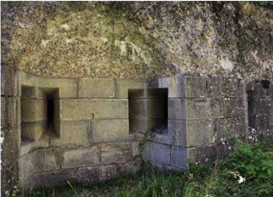
La galería de escarpa presenta exteriormente siete hornacinas aspilleradas, solución original para mejorar el flanqueo del foso. Se observa el muro de sillería y sobre él el hormigón de las bóvedas y donde se forma una pequeña bóveda de horno de la hornacina.
