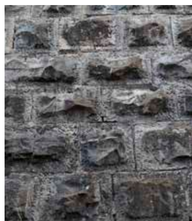
Mampostería concertada almohadillada, bajo la fachada del cuartel.
