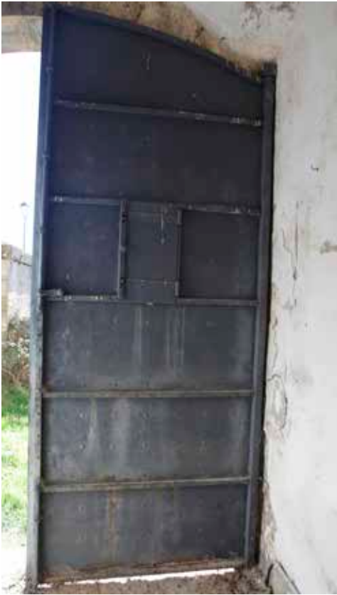
Vista interior de la puerta del abrigo, con su armazón metálico y la portezuela de ventilación cerrada.
