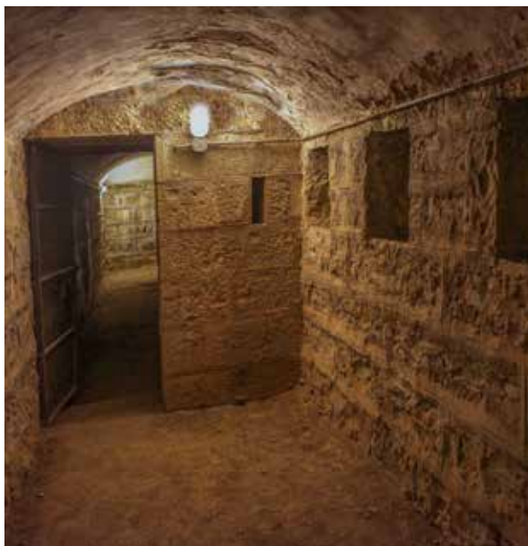
Galería de escarpa del foso particular de la caponera de cabeza. Se aprecia una "cortadura" con una aspillera y una puerta metálica con pestillo exterior que permitiría impedir el acceso del enemigo al interior del Fuerte si éste consiguiera romper el muro aspillerado.
