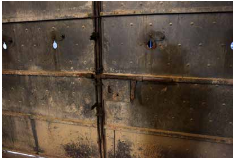
La puerta que cierra el acceso a la caponera está formada por dos batientes de palastro montadas sobre una estructura también metálica. Se conserva tanto las cerradura como el sistema de fallebas de fijación al suelo y a la parte superior. En el palastro se abren tres mirillas/aspilleras con su correspondiente cierre giratorio.
