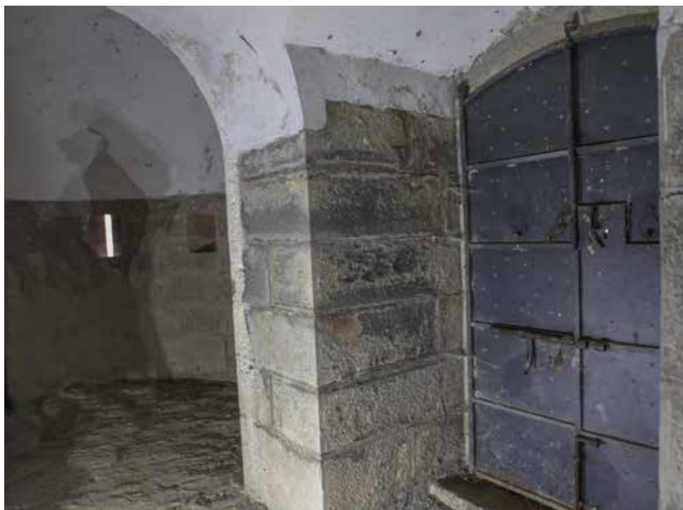
Puerta de acceso al foso en la galería de escarpa.
