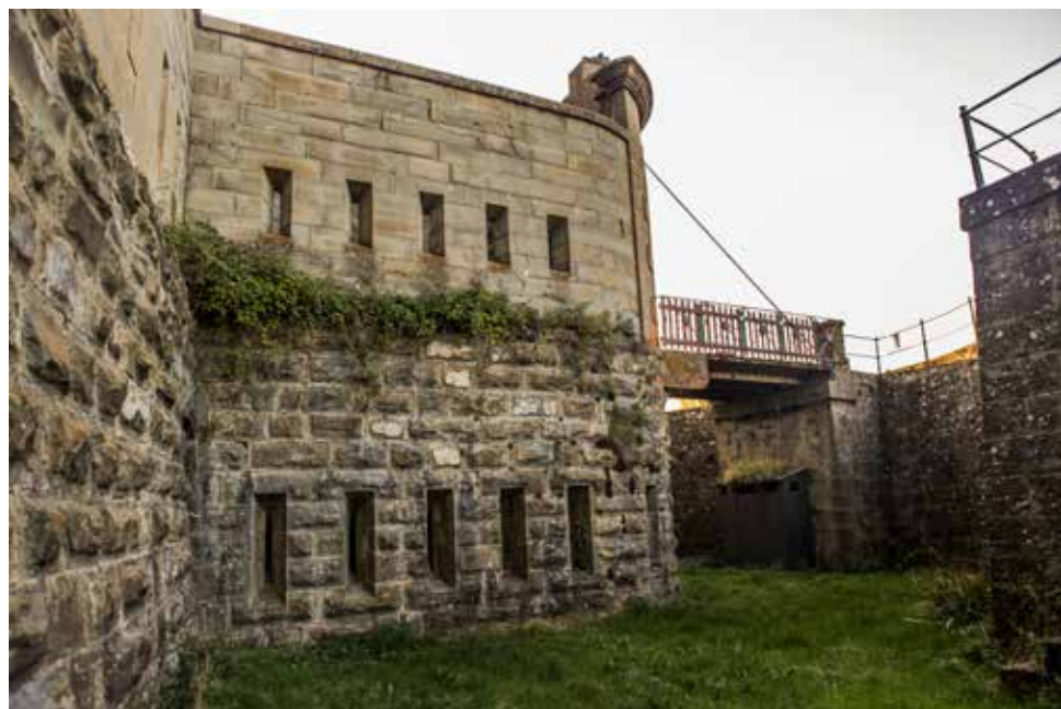
La planta superior que alberga el segundo orden de fuegos constituye la entrada del cuartel. Se aprecia su puente levadizo.
