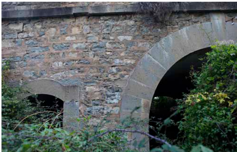
Accesos al pabellón del oficial (izquierda) y a la casamata occidental. Se aprecia el aparejo de mampostería concertada y juntas tomadas con mortero, así como la sillería de los arcos, jambas y cordón del muro.
