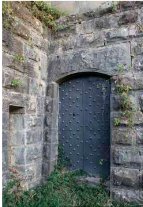
Puerta 6 de acceso al foso en la caponera de gola (sector oriental). A la izquierda e observa una aspillera de la caponera.
