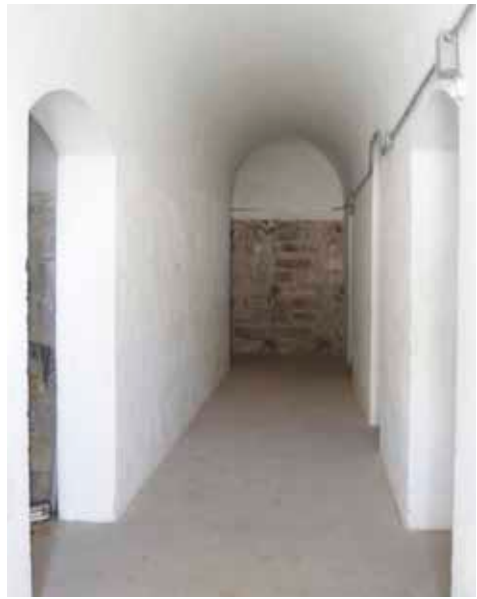
Galería de servicio (4). Acceso a proyectiles (izquierda), cuarto de carga, galería de nichos de luces y almacén de cartuchos para fusil (derecha)
