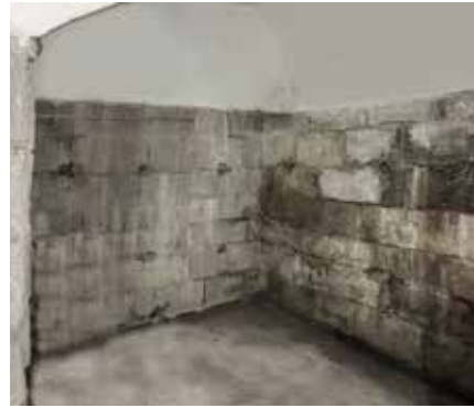
Depósito pequeño (3), falta de suelo original y de revestimiento de madera. En el lado de la puerta posee una ventana de luces.
