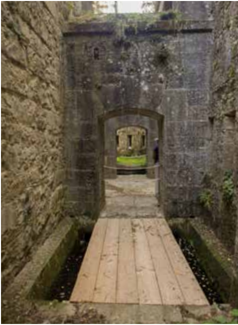
Puerta 3 de acceso al foso en la caponera de cabeza vista desde el exterior. Presenta un fosete provisto de puente levadizo (actualmente sustituido por un tablero).
