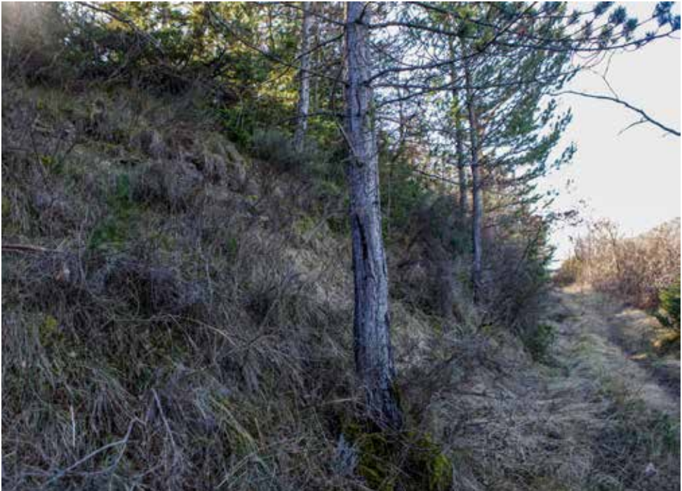
A la izquierda de la fotografía se aprecian los blindajes exteriores de la batería y a la derecha el actual camino que la recorre exteriormente teóricamente realizado sobre el foso.
