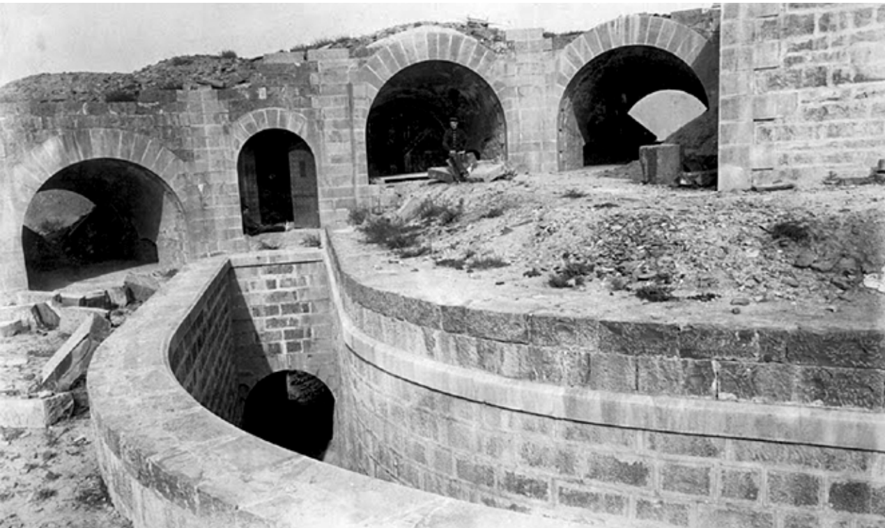
Fotografía de la construcción del Fuerte. De izquierda a derecha: casamata n. 1 y abrigo para los servidores, casamatas n. 2 y 3. Abajo: el acceso a la semicaponera occidental.
