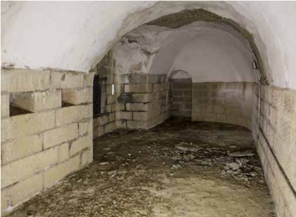
Casamata (2) de la semicaponera occidental. La hornacina del fondo tiene por misión posibilitar el disparo desde la aspillerada que está más cerca de la misma.
