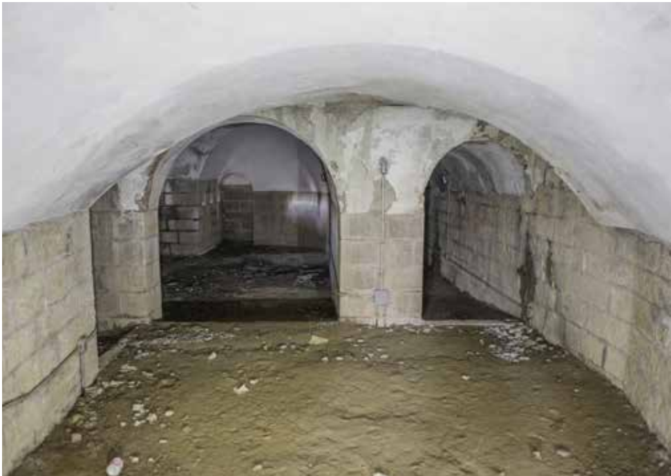
La poterna de la semicaponera occidental se amplía hacia su final, dando acceso a un sector de galería de escarpa (5) (izquierda), la casamata de flanqueo (2) (centro) y el acceso (9) a la galería de escarpa que rodea la caponera y puerta de acceso al foso.
