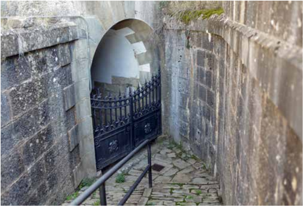
Acceso en trinchera a la poterna de la semicaponera oriental
