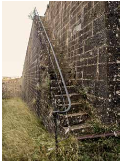
Escalera 2. Es larga por la gran altura de la contraescarpa, posee barandilla original.
