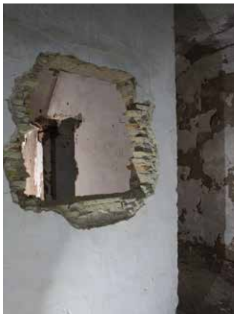
nicho de luces del depósito de proyectiles (6), desprovisto de su marco. Otro nicho de luces similar existe en el almacén de pólvoras (7).
