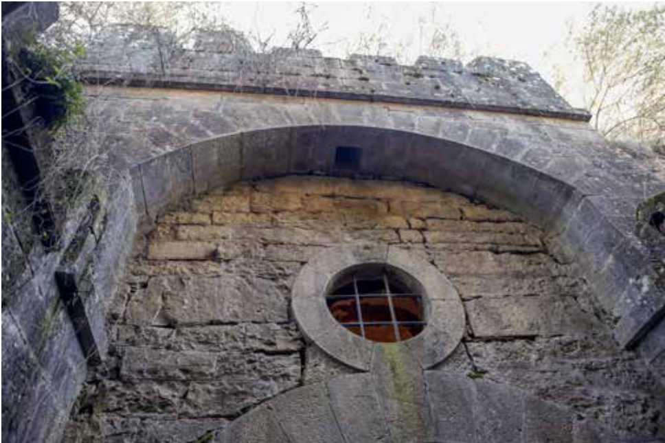
Enmarcado en un arco se observa la boca exterior del matacán para defensa del espacio comprendido entre las cuatro puertas de acceso a la caponera de cabeza. Sobre el arco se pueden apreciar un parapeto de fusilería almenado de cinco puestos de tirador con acceso desde las bermas del talud exterior..
