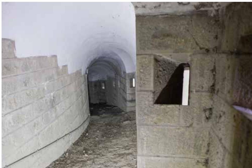
Galería de escarpa (5), en pendiente, con sus aspilleras capaces de flanquear con ventaja el sector curvo de foso.
