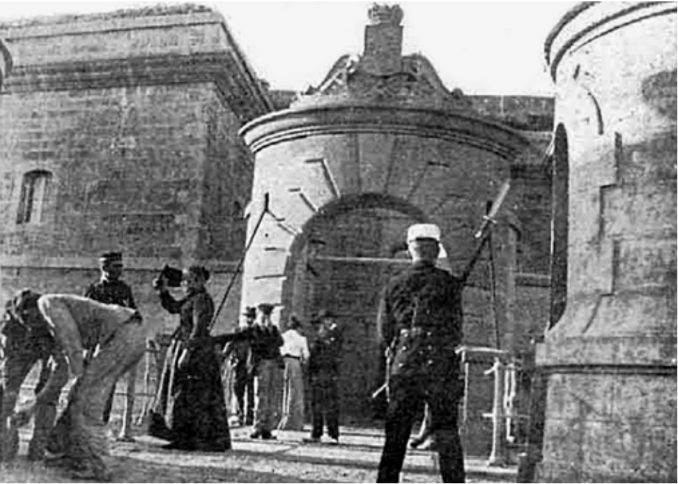
La fotografía indica la presencia de dos garitas de buena factura delante de la puerta del Cuartel (La ilustración Española y Americana, 1903.). De la garita izquierda apenas se aprecia en la fot. la moldura que la remata por su parte superior. Están consignadas en plano 3[bis] del proyecto (estado actual), pero no en el 3 inicial. Constituyen el remate del parapeto del camino cubierto que debía quedar interrumpido en las entradas del Cuartel.
