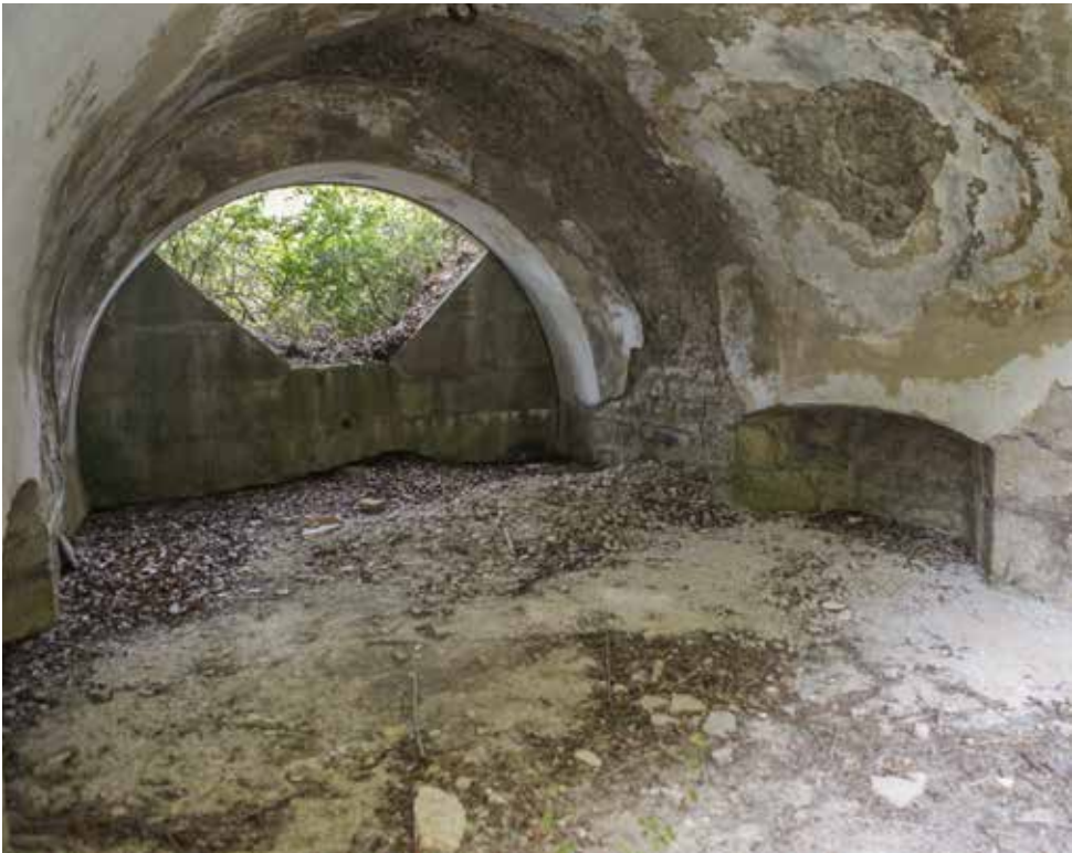
Interior de la casamata occidental (5). Se aprecia la cañonera y el hueco inferior en los estribos de la bóveda para facilitar el movimiento del marco del cañón.
