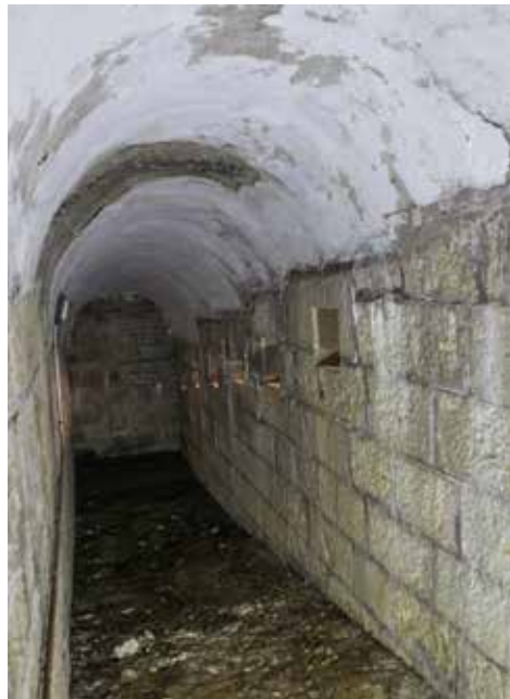
Sector aspillerado (5) de la galería de escarpa situado frente al orejón.
