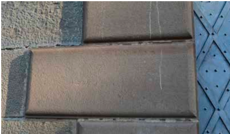
Sillares almohadillados en la puerta principal del fuerte.
