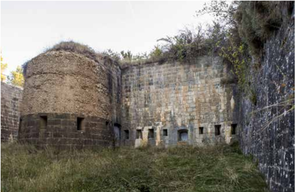
Izquierda: orejón que incorpora un tambor aspillerado (4) y la puerta de acceso al foso (8) y protege el frente de la semicaponera, con su cañonera (3) y aspilleras. A la derecha un sector de escarpa (5) con sus aspilleras.
