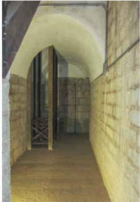
Galería y montacargas. La bóveda sostiene una reducida planta superior.
