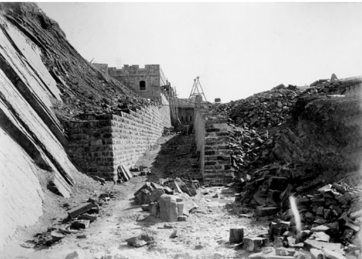
Fotografía de finales del siglo XIX en la que se aprecia la construcción del foso principal (sector 1) . La pared de la izquierda es la escarpa y la de la derecha la contraescarpa.
