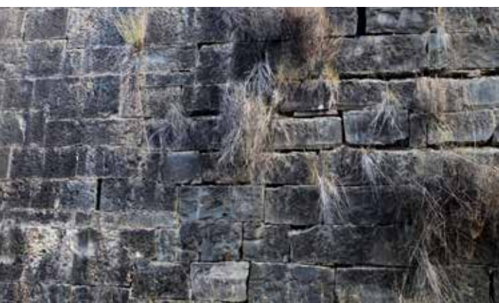
A la izquierda sillarejo y a la derecha mampostería concertada en un punto de la contraescarpa
