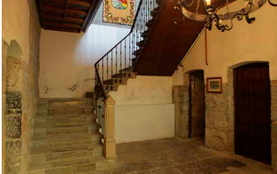
Vestíbulo (72) y escalera (71) de acceso a la planta superior. Las dos puertas conducían al las letrinas y almacén de cartuchos (75), actualmente recepción y cuadro eléctrico.
