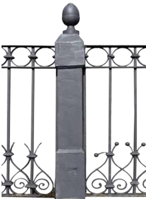
Barandilla de las rampas de la poterna (A)
