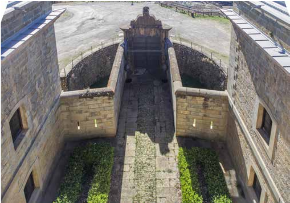
Patio visto desde el parapeto de la azotea. Se aprecian las aspilleras abiertas en el muro que cierra el patio por el sur y la planta superior de la caponera de gola que forma parte del acceso
