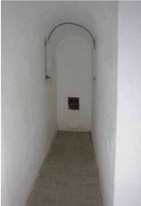
Galería (8) con dos ventanas de iluminación enfrentadas y un ventilador al fondo.
