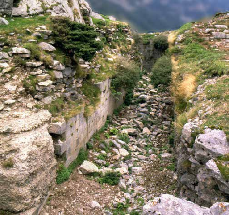
Inconclusa batería de la Sagüeta. Se aprecia uno de los sectores del foso con la escarpa y contraescarpas revestidas. Su mayor originalidad era la defensa del foso por medio de cofres de contraescarpa.
