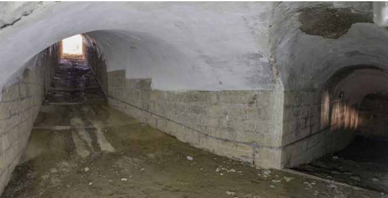
Poterna (7) de acceso a la semicaponera occidental (izquierda) y sector de galería de escarpa (5). La poterna se ensancha formando un vestíbulo.
