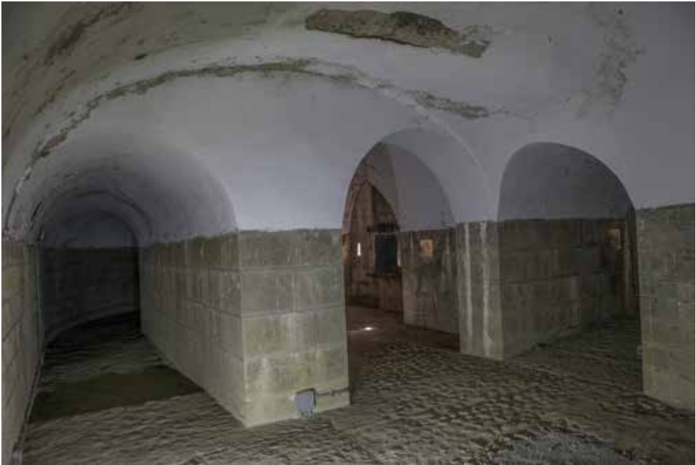
La poterna de acceso a la semicaponera oriental termina en un espacio sin pendiente (2) que sirve de distribuidor a la galería de escarpa (4 y 5) (izquierda), casamata de flanqueo (3) (centro) y galería de escarpa (6) frente a la puerta de acceso al foso (derecha).
