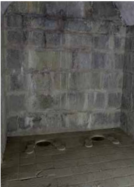
Excusados de la galería de escarpa de la caponera de cabeza, con dos puestos marcados con pisadas en el suelo..
