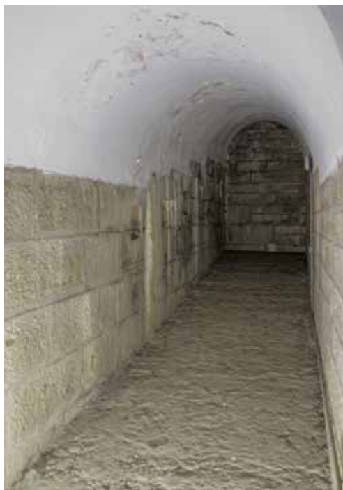
Galería de escarpa (6) en el orejón de la semicapонера.
