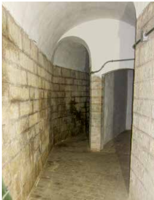
Galería y espacio de protección de la entrada al depósito de pólvoras (10).
