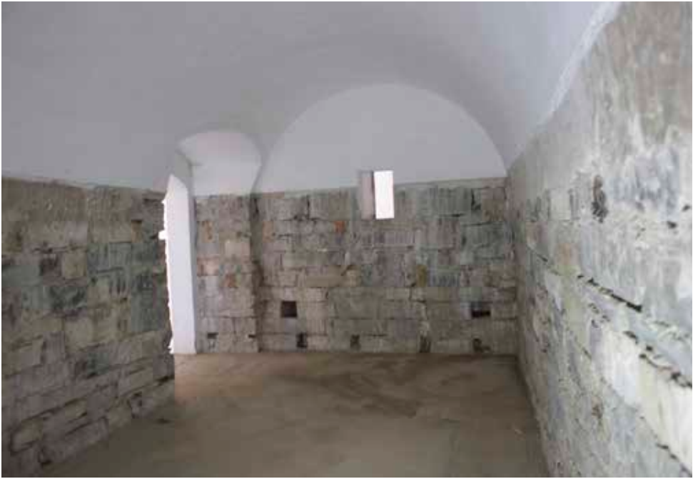
Depósito de proyectiles (3), con su acceso (izquierda) y nicho de luces. el suelo estaba entarimado, al igual que las paredes en el sector que se aprecia la piedra.
