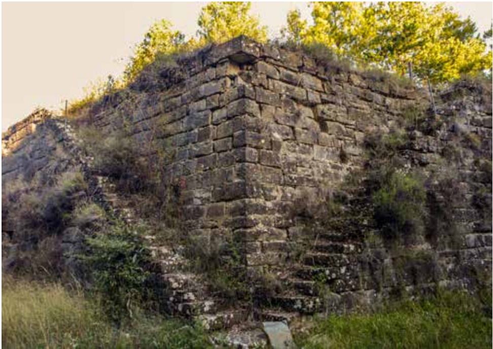
Escaleras 3 y 4, formando ángulo en la contraescarpa, frente a la caponera de cabeza, poseen en común el último escalón común
