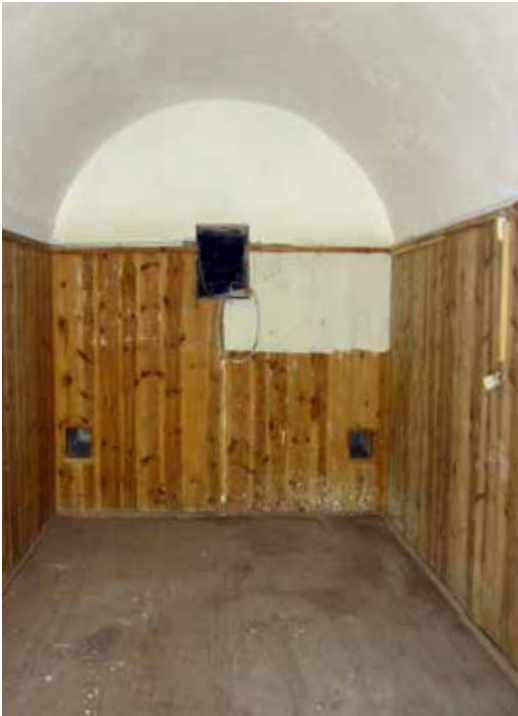
Depósito de pólvoras (1) del almacén oriental de munición. Posee suelo y paredes forradas de madera similares a los originales. Se observa la ventana de iluminación y, bajo la misma, dos de los conductos de ventilación
