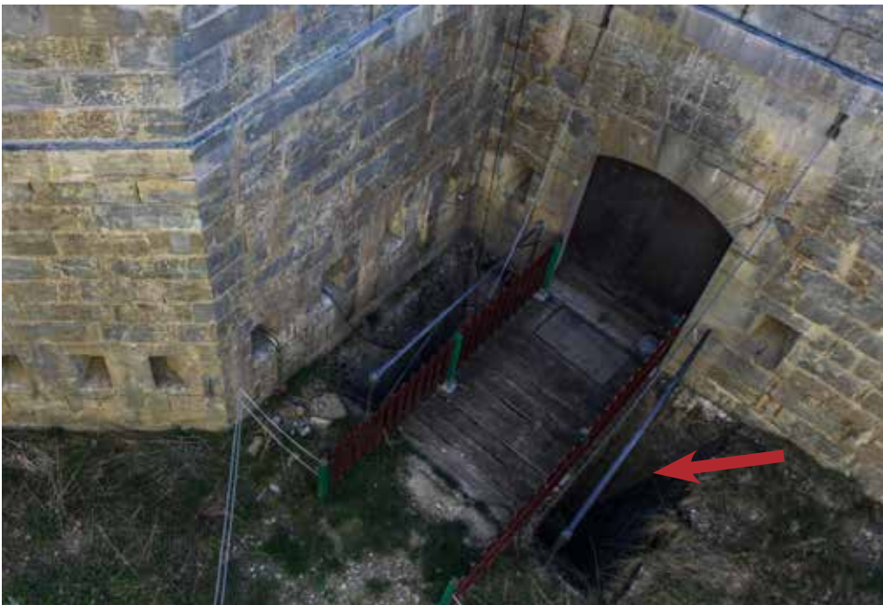
Foso diamante (flecha). El fondo es apuntado, dificultando así la permanencia de un enemigo en su interior. El puente levadizo permite salvar el mismo.
