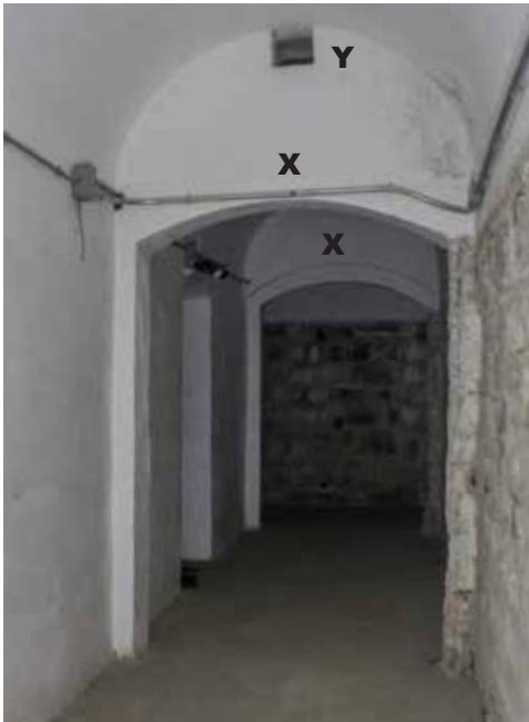
Galería de servicio (4) con el vestíbulo (9) con puertas (X) que cerraban el acceso al depósito de pólvoras, pero con aireación (Y)
