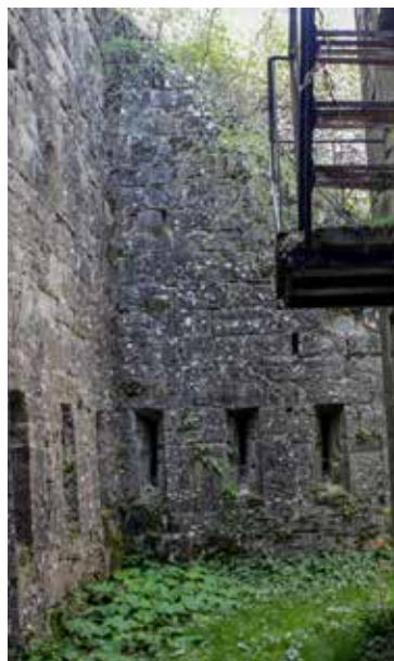
Vista exterior de la galería de escarpa del foso particular de la caponera de cabeza. Posee tres aspilleras tras el recodo y siete antes del mismo.
