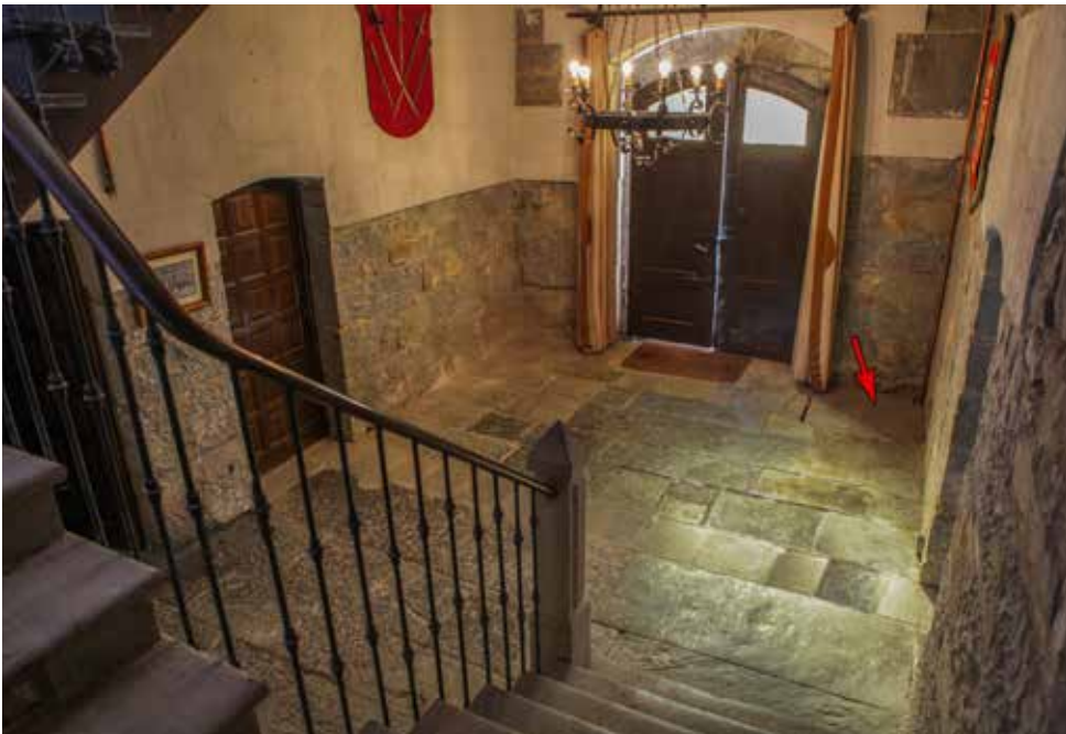
Vestíbulo (72) y escalera de acceso a la planta superior (71). La flecha señala la posición de la bomba de mano del aljibe (cubierto actualmente con tablas). La puerta frontal es el acceso al cuartel y las de la izquierda corresponden en origen a las letrinas y almacén de cartuchos para fusiles; a la derecha accesos a la cocina y almacén de herramienta.
