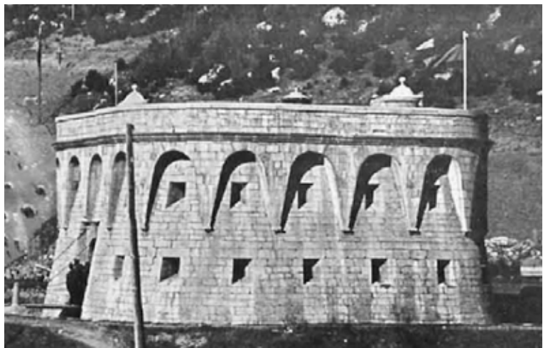
Inconclusa batería de la Sagüeta. Se aprecia uno de los sectores del foso con la escarpa y contraescarpas revestidas. Su mayor originalidad era la defensa del foso por medio de cofres de contraescarpa.
