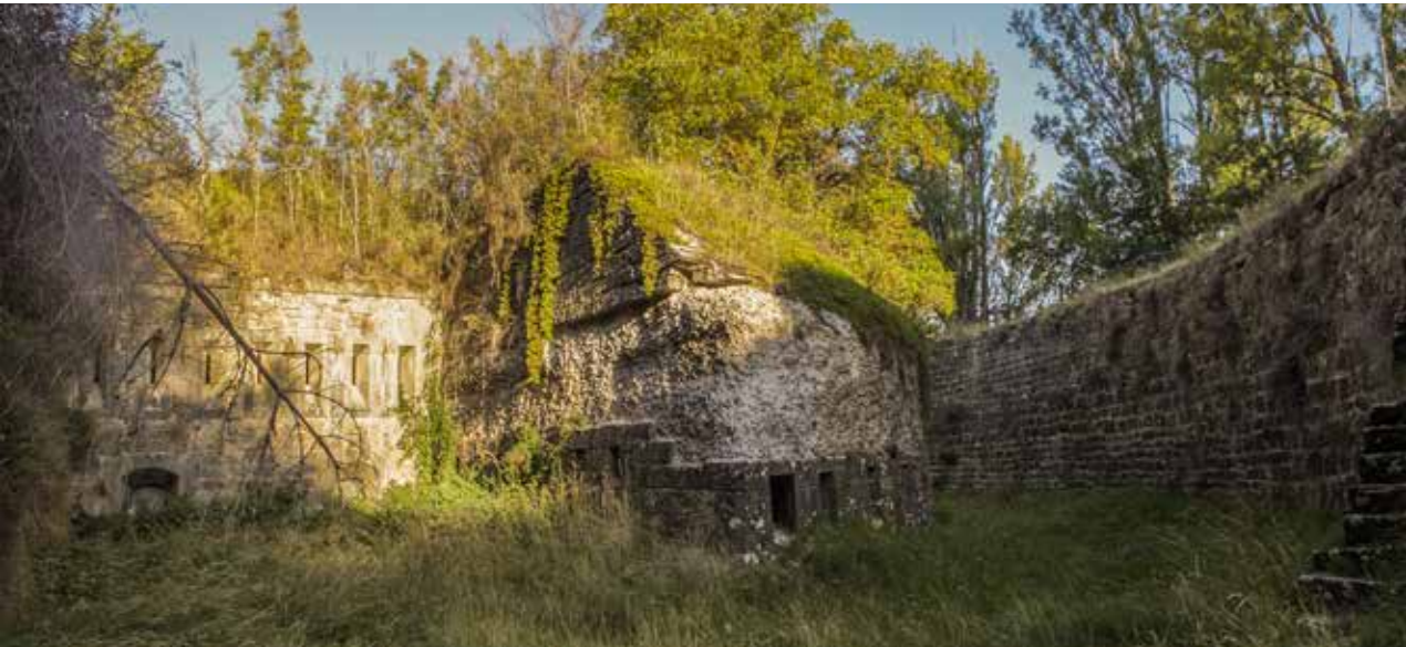
El frente oriental de la caponera de cabeza visto desde el foso, protegido por un orejón aspillado (a la derecha de la fotografía). Se aprecia también el sector redondeado de la caponera formando la escarpa aspillada con la contraescarpa del foso general situada enfrente. En el extremo derecho de la fotografía se aprecia parte de una de las escaleras de contraescarpa
