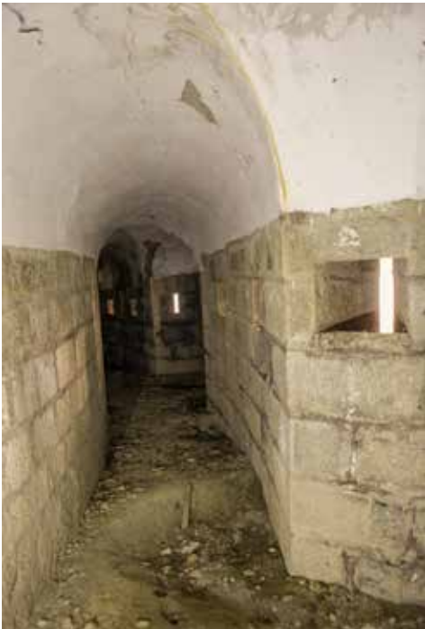
Galería de escarpa (6) de la semicaponera occidental.
