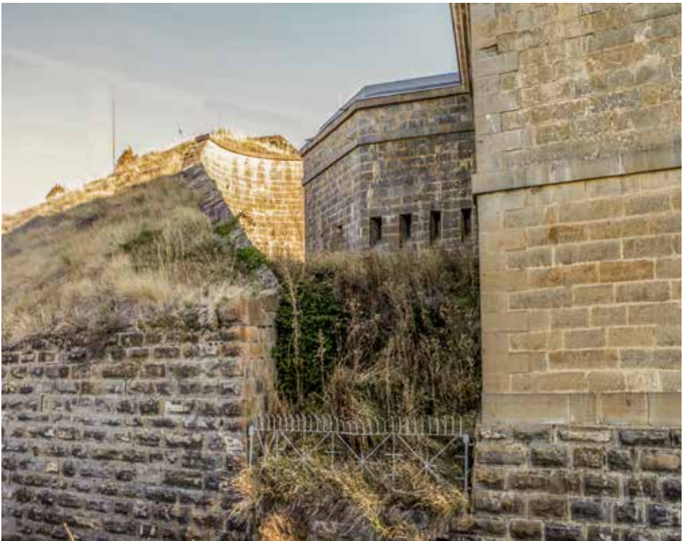
Desembocadura del foso del cuartel en el foso principal del Fuerte, cerrado mediante una reja. Al fondo se aprecia la semicaponera occidental defendiendo con cuatro aspilleras el sector de foso . El muro de la derecha corresponde a la fachada meridional de cuartel.
