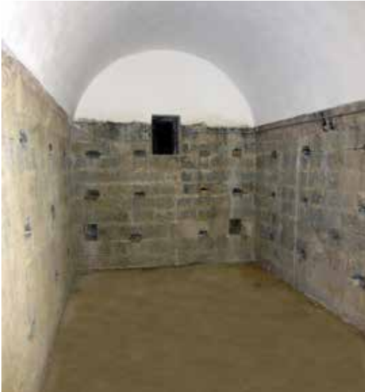
Depósito de proyectiles (2) con su ventana de luces.
