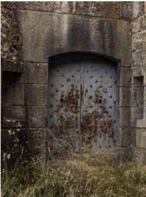
Puerta 2 de acceso al foso en la semicaponera occidental.
