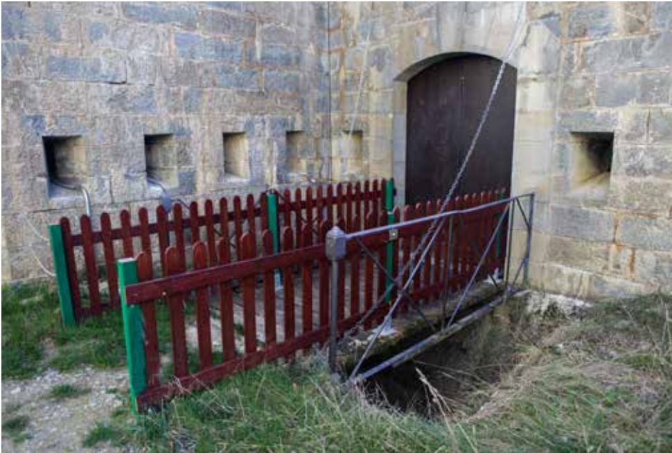
Exterior de la puerta de acceso a la planta superior del cuartel. Está protegida por un foso diamante con puente levadizo y por diversas aspilleras. Las barandillas originales son móviles, mientras que las de madera se instalaron para evitar posibles accidentes.
