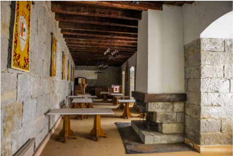
La misma nave de la fotografía anterior destinada originariamente a enfermería, fotografiada desde el extremo opuesto, más estrecho que el que se aprecia al fondo de la fotografía.
