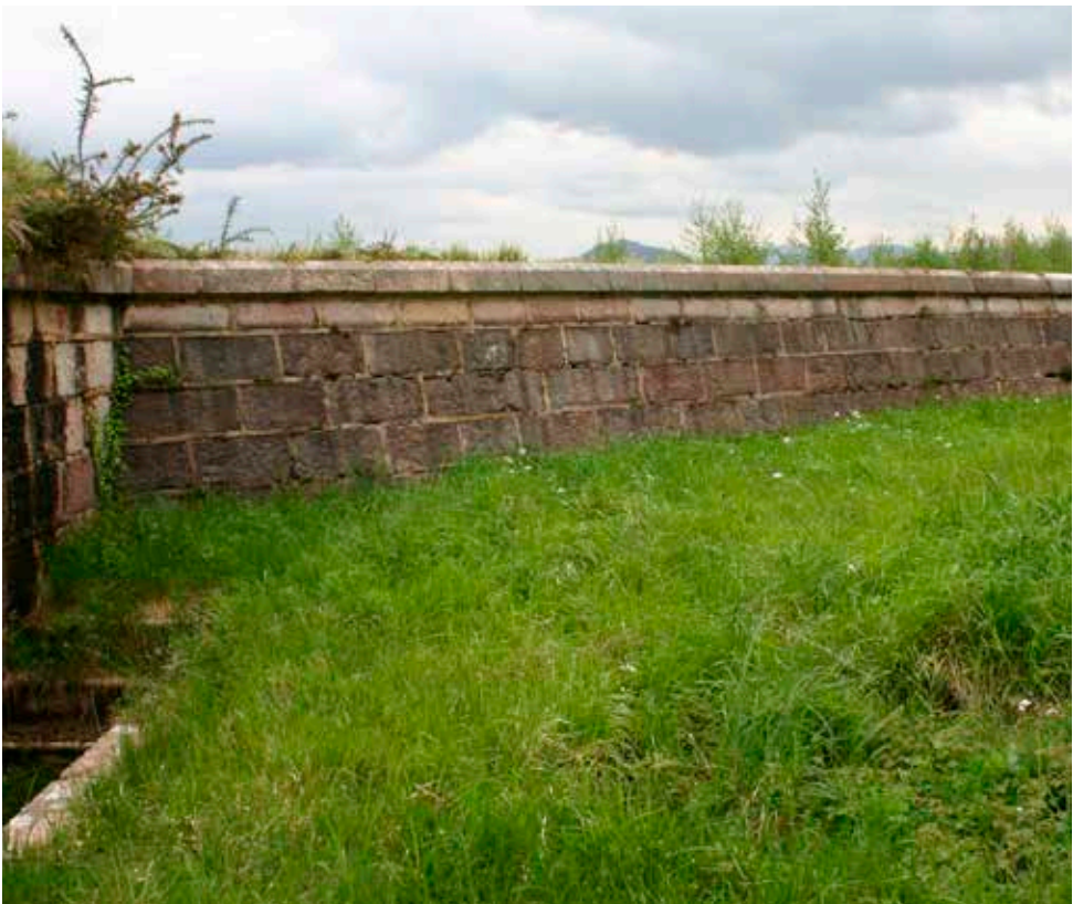
Parapeto de la batería a barbete. A la izquierda se aprecia el acceso al interior del través.
