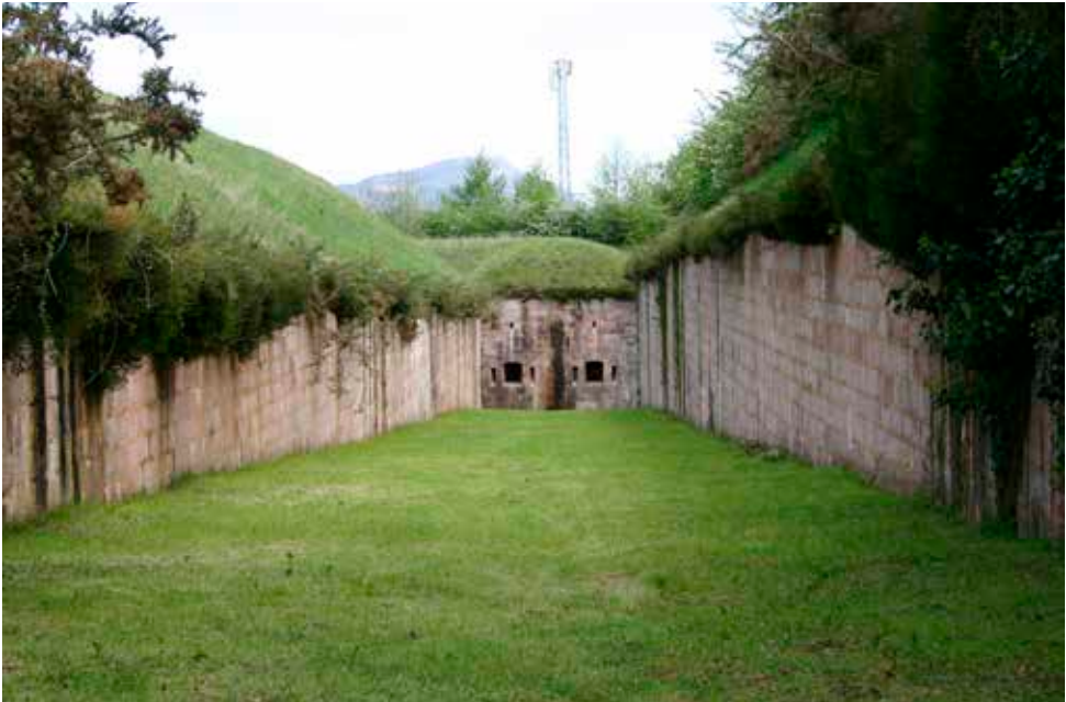
Caponera de cabeza flanqueando el foso. Se aprecian las dos cañoneras para las ametralladoras y las cuatro aspilleras de fusilería. A la izquierda la escarpa y a la derecha la contraescarpa del foso.
