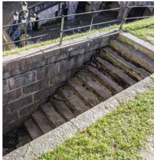
Doce escalones (2) que unen la batería acasamatada y el parapeto de fusilería de gola
