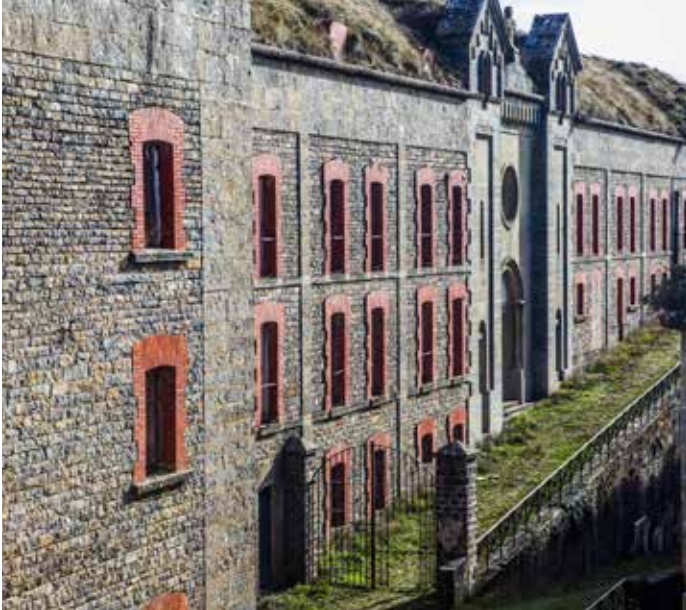
1 Fuerte de San Cristóbal o Alfonso XII (Navarra). Es el mayor fuerte poligonal de mayores dimensiones del Pirineo. Se aprecia en la fot. la entrada de la capilla.
