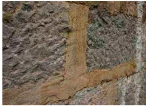
Sillarejo desbastado con las juntas tomadas con mortero, sin formar cinta.
