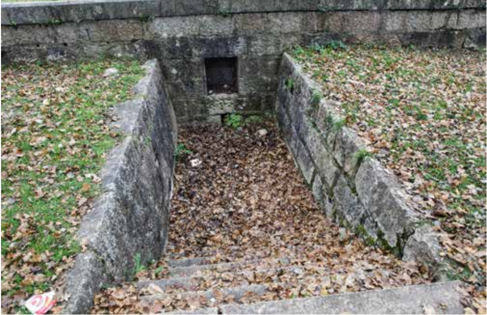
Trinchera-abrigo en la batería auxiliar de Los Barracones.
