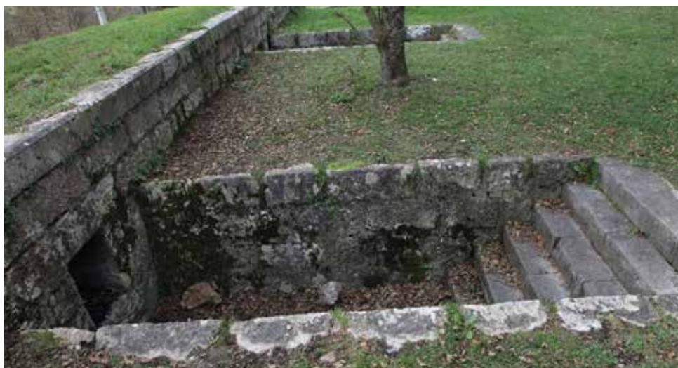
Trinchera-abrigo en la batería auxiliar de Los Barracones
