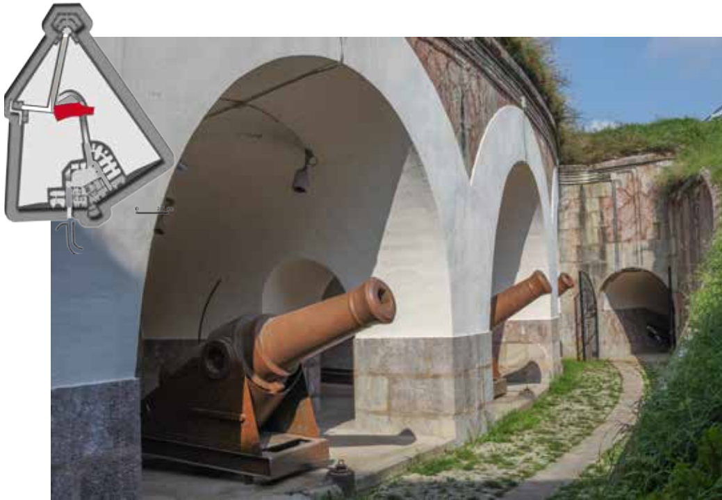
Las tres casamatas de la batería de fuegos curvos, con las tres réplicas de OHS de 21cm. Delante tienen el corredor que comunica con el acceso a las caponeras (al fondo) y a la derecha el muro de contención de la rampa de acceso a la batería a barbata.
