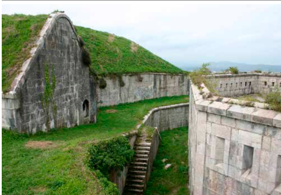
A la izquierda, el gran través cruciforme. La escalera del foso interior y a la dcha el cuartel.
