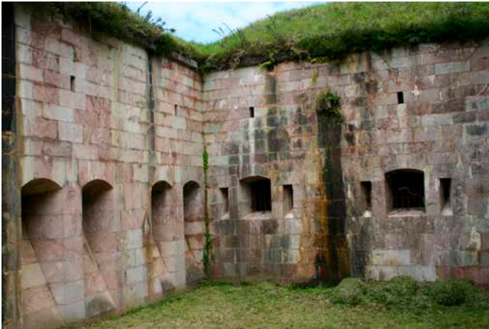
Uno de los flancos de la caponera de cabeza. Se aprecian las dos cañoneras para las ametralladoras, con dos aspilleras a cada lado. A la izquierda de la fotografía se aprecian cuatro matacanes correspondientes a los pequeños sectores anexos de galería de escarpa.
