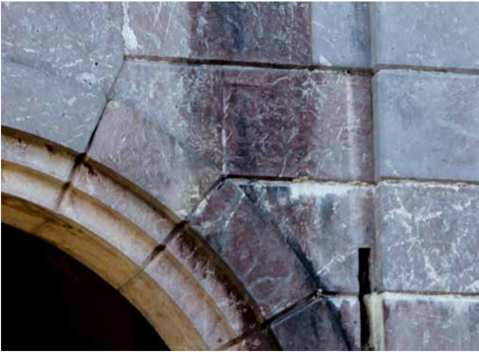
Detalle de sillería caliza en la puerta principal del Fuerte.
