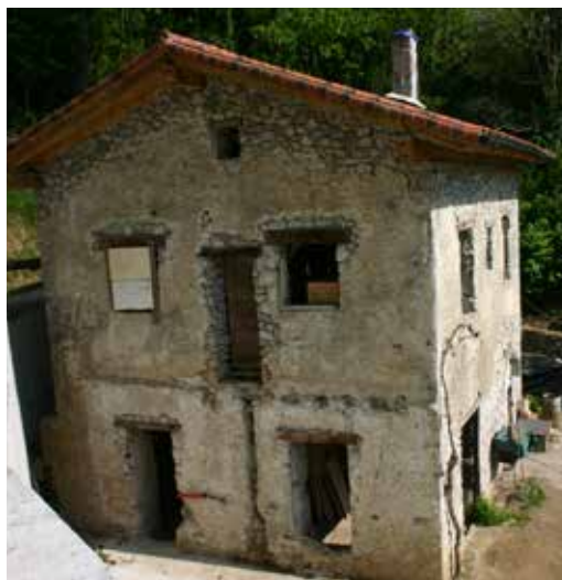
Estado del edificio en el año 2005, obtenida durante el proceso de rehabilitación, permitiendo observar la mampostería.
