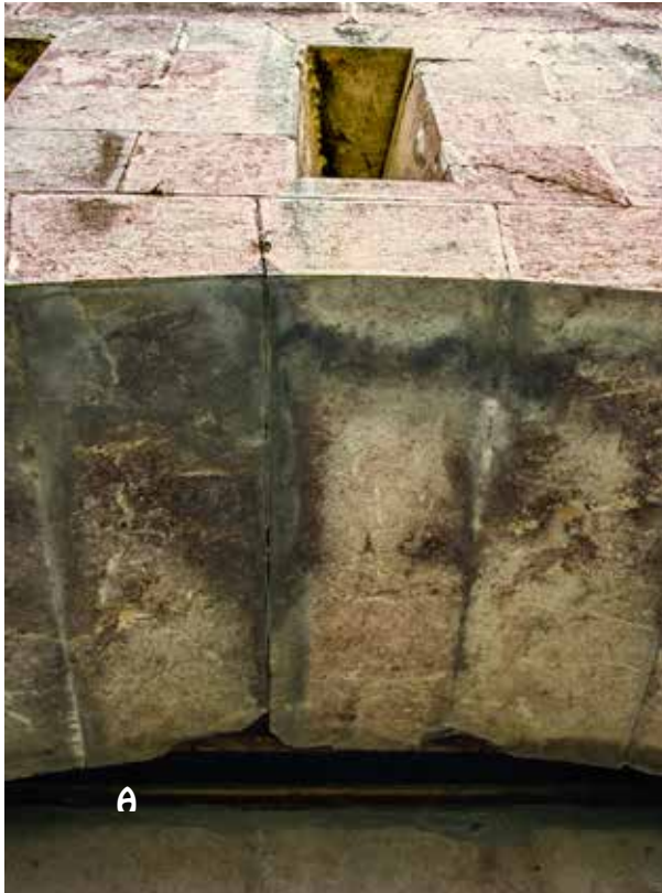
Vista en contrapicado de uno de los matacanes (A) de la caponera de gola. Sobre él se aprecia una de las aspilleras.
