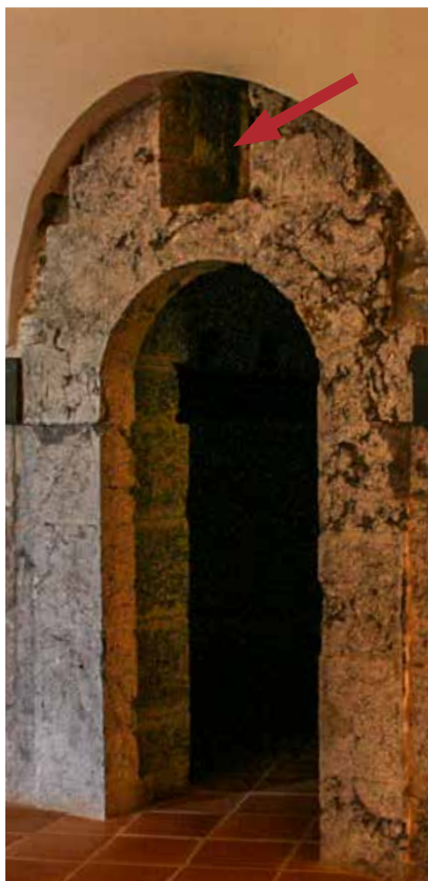
Ventana de iluminación o nicho de luces de la estación superior de los montacargas de munición de la batería acasamatada (exterior).
