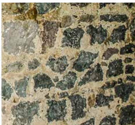
Mampostería ordinaria con las juntas tomadas en una caponera. La mampostería ordinaria originalmente estaba rebocada.
