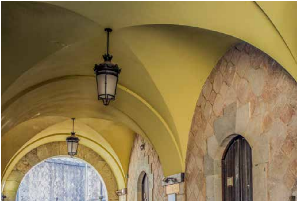
Vestíbulo del fuerte. cubierta mediante dos bóvedas de arista.
