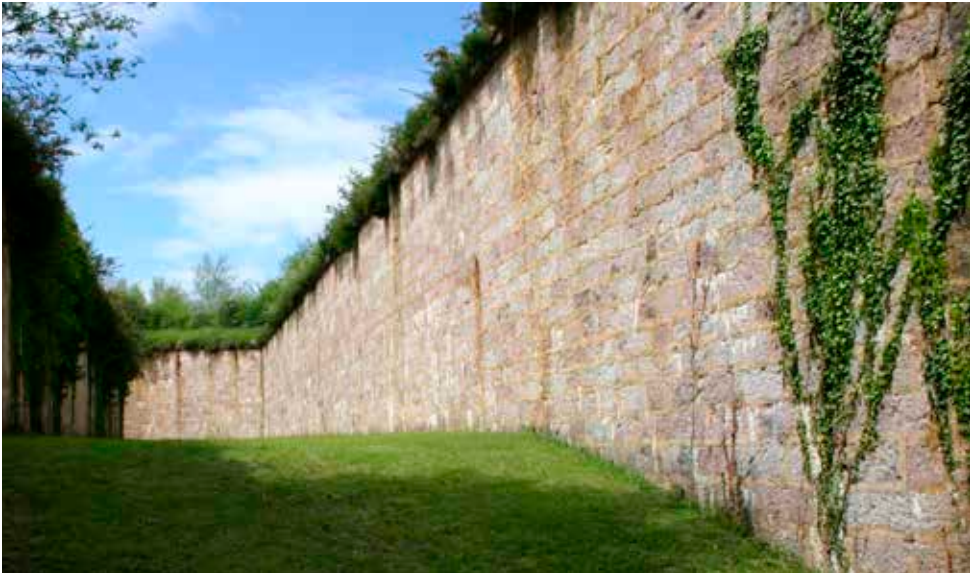
La contraescarpa, a la derecha de la fotografía y la escarpa a la izquierda.
