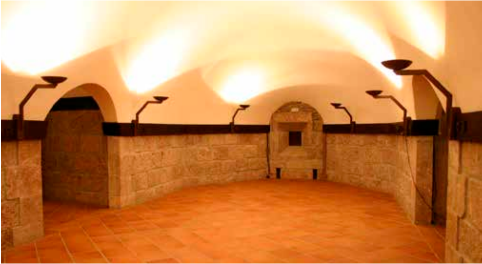
Vista longitudinal del almacén de pólvoras. Al fondo se aprecia la ventana de iluminación y a los lados las comunicaciones con las estancias destinadas a los montacargas de pólvoras (derecha) y de proyectiles (izquierda).
