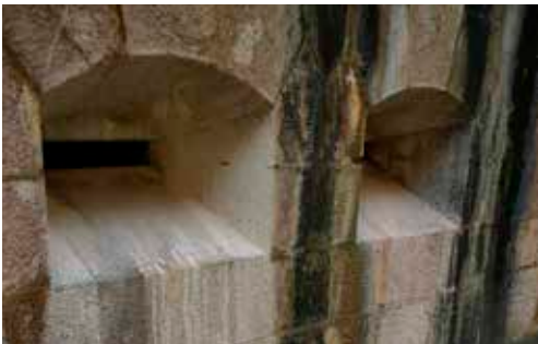
Aspilleras horizontales de la semicaponera.
