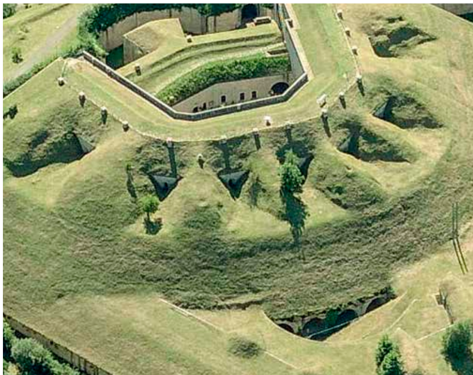
Batería acasamatada vista por su frente, con las siete cañoneras abiertas y los blindajes de las que están en reserva cegados por blindajes de tierra. (Fot. aérea: Diputación Foral de Gipuzkoa).
