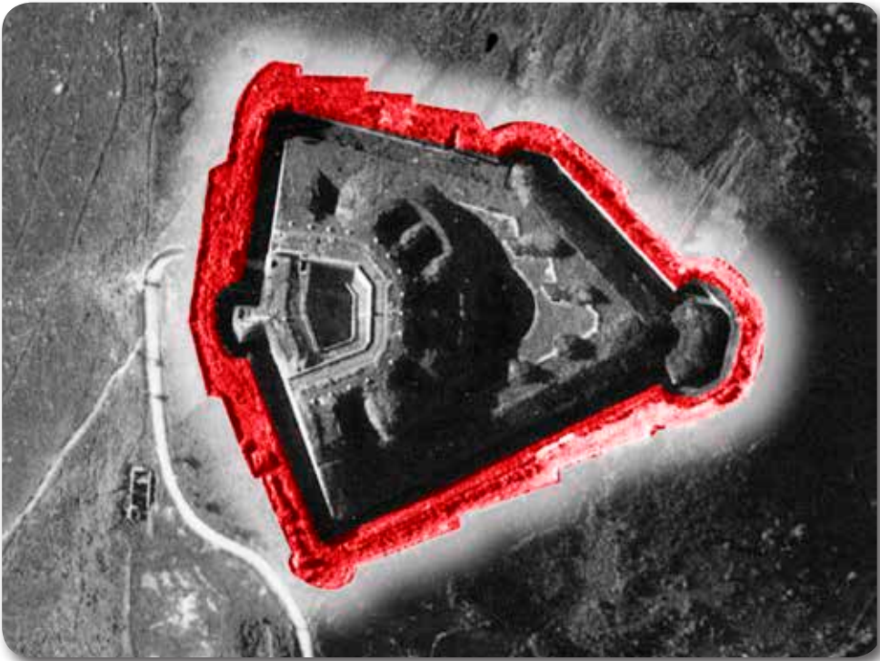
Sobre la fotografía aérea de 1954 se ha señalado en rojo el camino cubierto , todavía con su configuración original (Fot. Diputación Foral de Gipuzkoa).
