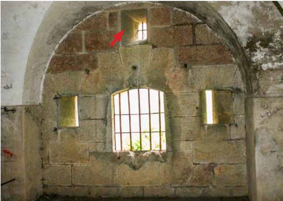
Ventilador de una de las casamatas de la caponera de cabeza visto por el interior en su estado original. Actualmente están cubiertos por una chapa.
