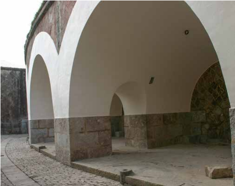
Bóvedas cónicas de la batería de fuegos curvos. Abajo planta y sección de una de estas casamatas antes de colocar las réplicas de los obuses.
