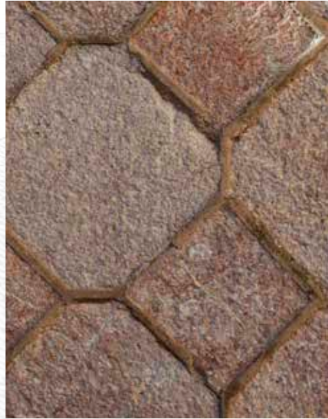
Mampostería concertada poligonal encintada (patio). El encintado consiste en la toma de las juntas formando relieve esmerado.
