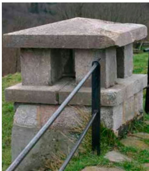
Exterior (15) de la chimenea de ventilación que evita la entrada de agua.
