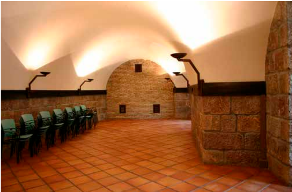
Pabellón para dos tenientes (60 m 2 ), sin compartimentaciones y con nuevo pavimento (el original era entarimado de madera de pino). Al fondo, los ventiladores.
