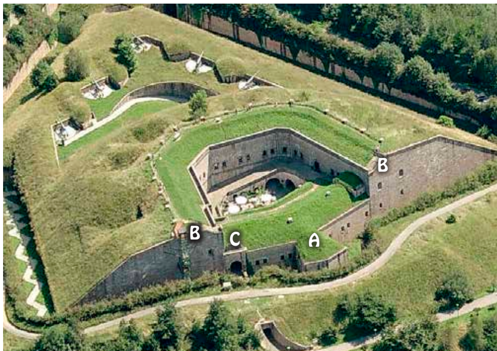
La gola se corresponde con el sector derecho de la fotografía. En ella se aprecia tanto la caponera “de gola” (A) como las cuatro cañoneras septentrionales de la batería acasamatada (B) o el acceso (C). (Fotografía aérea: Diputación Foral de Gipuzkoa).
