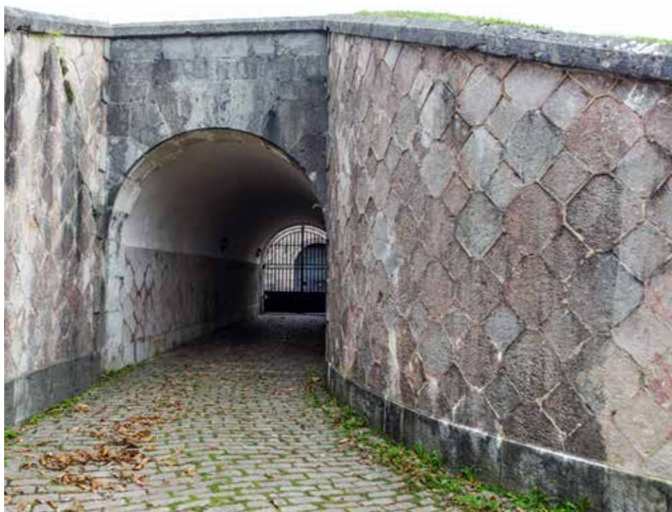
Boca exterior del túnel de acceso al Fuerte. Se aprecian las dos alas en curva y al fondo, la puerta principal y la reja de cierre que impide el paso al puente sobre el foso.
