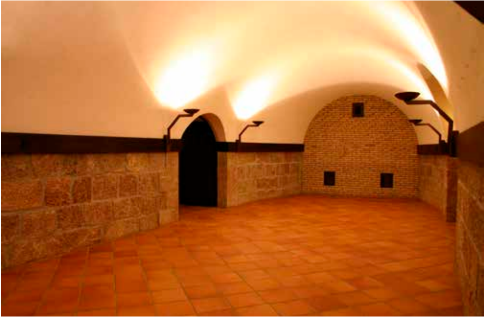
Vista longitudinal tomada desde el acceso. A la izquierda se aprecia la comunicación con el depósito de pólvoras y a la derecha se intuye el que permite la comunicación con el almacén de efectos de artillería.
