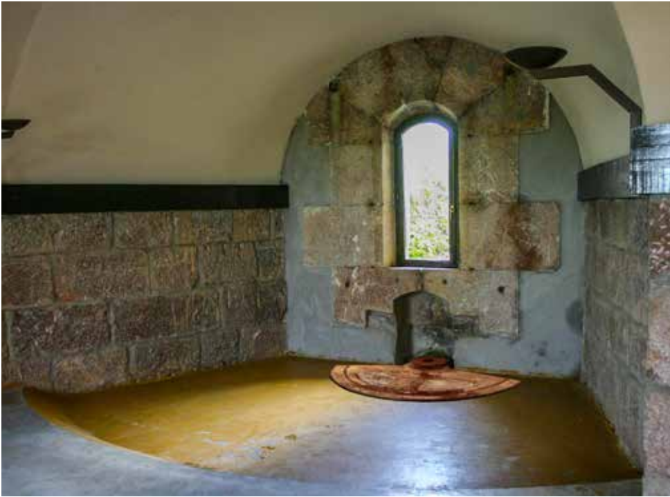
Montaje fotográfico de la basacarril completa en una de las casamatas de la Obra Alta. Está actualmene a la vista la pieza circular que acoge al perno pinzote, pero está presumiblemente bajo el revestimiento de hormigón el resto de la basacarril. El rebaje en el hormigón corresponde a la adaptación de la explanada original a los Ordóñez de 15 cm.
