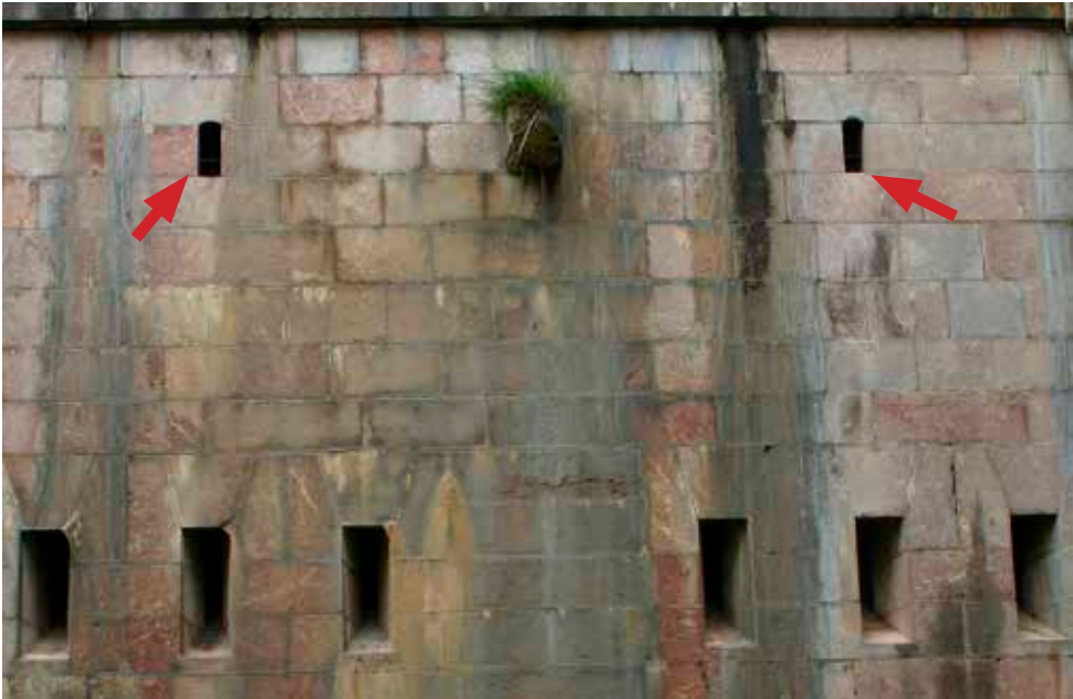
Ventiladores en uno de los flancos de la caponera de gola visto por el exterior. Los orificios inferiores, algo más grandes, son aspilleras de fusilería. En el centro de ambos, un vierteaguas.
