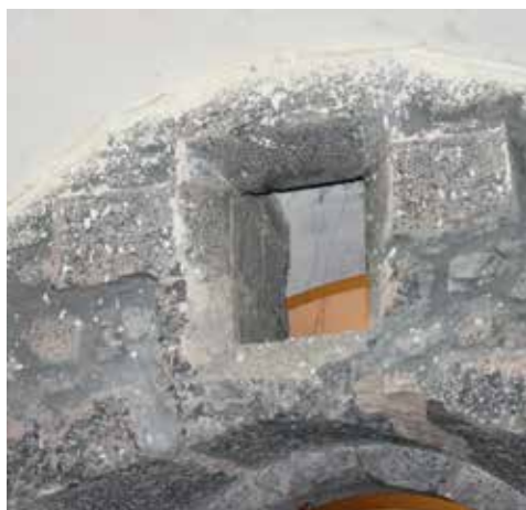
Ventana de iluminación de la estación superior de los montacargas de munición de la batería acasamatada (interior).
