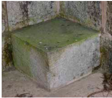
Repuesto de mano en una casamata de la batería de fuegos curvos, constituido por un sillar sobre el que se depositaban los proyectiles en espera de su uso inmediato.
