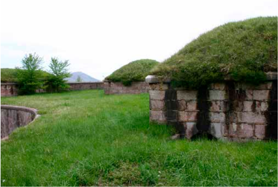
Adarve de combate. Al fondo se aprecia el parapeto, así como tres traveses (uno de ellos en primer plano). Fotografía obtenida con antelación a la incorporación de réplicas de artillería.
