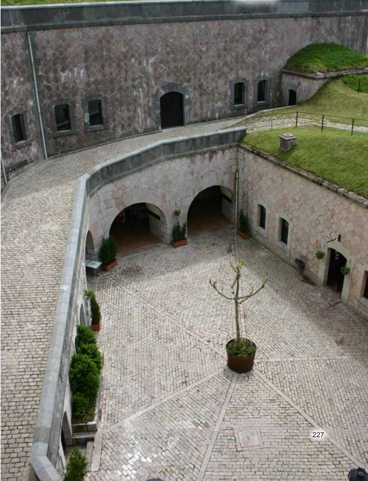
Rampa de comunicación entre el Patio principal y el terraplén de servicio de la Obra de la Izquierda.
