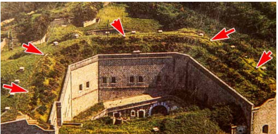
En la fotografía aérea antigua se observan incluso las barras metálicas de los pararrayos.
