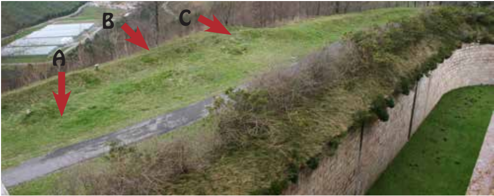
A camino cubierto, parcialmente asfaltado B parapeto del camino cubierto (alterado) C Rediente.
