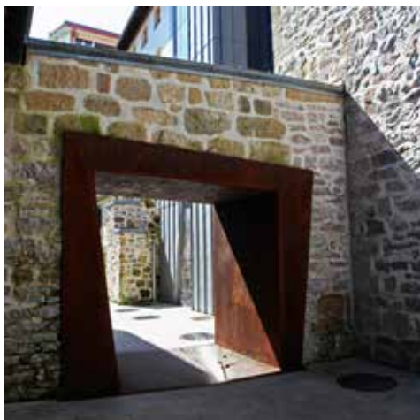
Estructuras de la muralla moderna.
