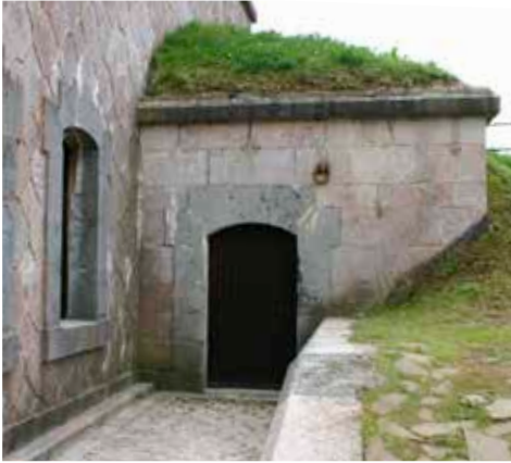
Pequeño edificio contiguo a la batería acasamatada que acoge las letrinas principales del Fuerte.
