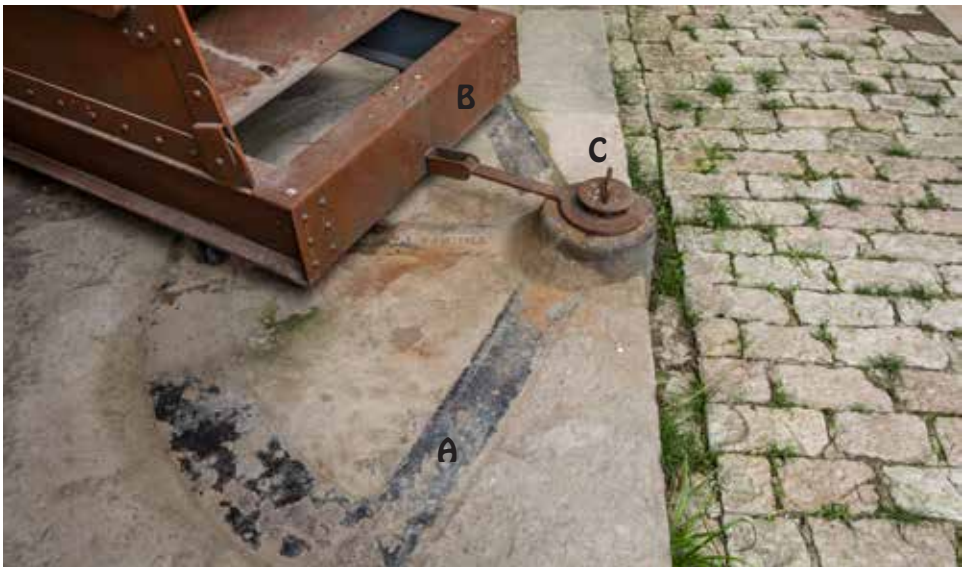
Unión (simplificada) entre la basacarril (original) (A) y el marco de la reproducción del Obús (B) con intermediación del perno pinzote (C).
