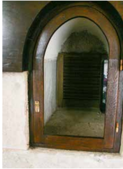
La misma ventana de iluminación vista por el otro lado, en las arcadas existentes en el patio de armas. Está muy intervenida. En los planos aparece un conducto para salida de humos pero no se constata su existencia.
