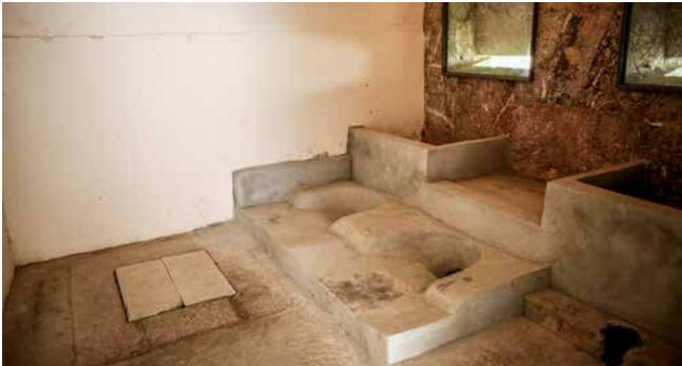
WC parcialmente restaurados instalados en 1939 para dar servicio a la prisión militar de oficiales. Se aprecian dos WC turcos y a la derecha correspondía un inodoro. El registro que se aprecia corresponde al antiguo WC situado en otra posición.
