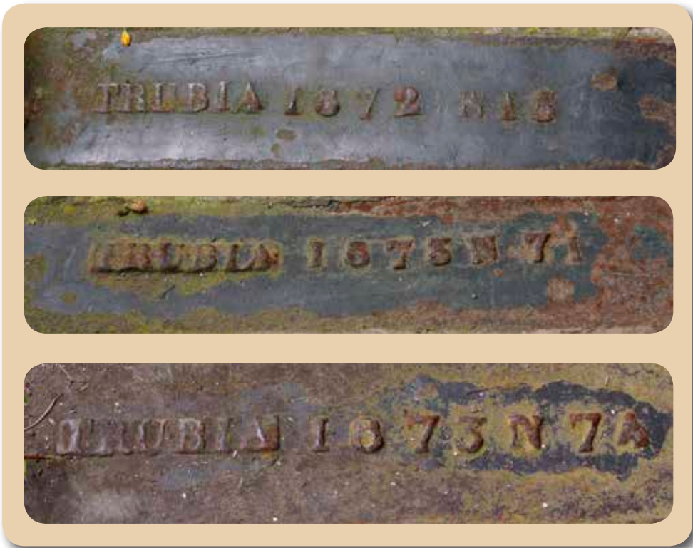
Inscripciones en las basacarriles: Trubia (se refiere a la fábrica de artillería de Trubia, Asturias): los años: 1872 y 1873 y los números 15, 71 y 74.
