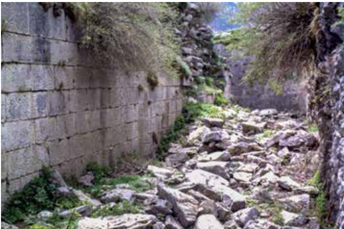
3 Batería de La Sagüeta en Canfranc (Huesca). A la izquierda la escarpa y a la derecha la contraescarpa.
