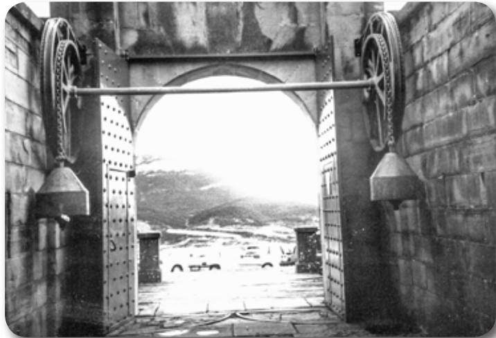
Uno de los dos fosos (cubierto por una puerta) para acoger el contrapeso del sistema.
