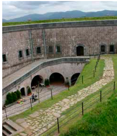
Vista parcial de la Obra Alta.
