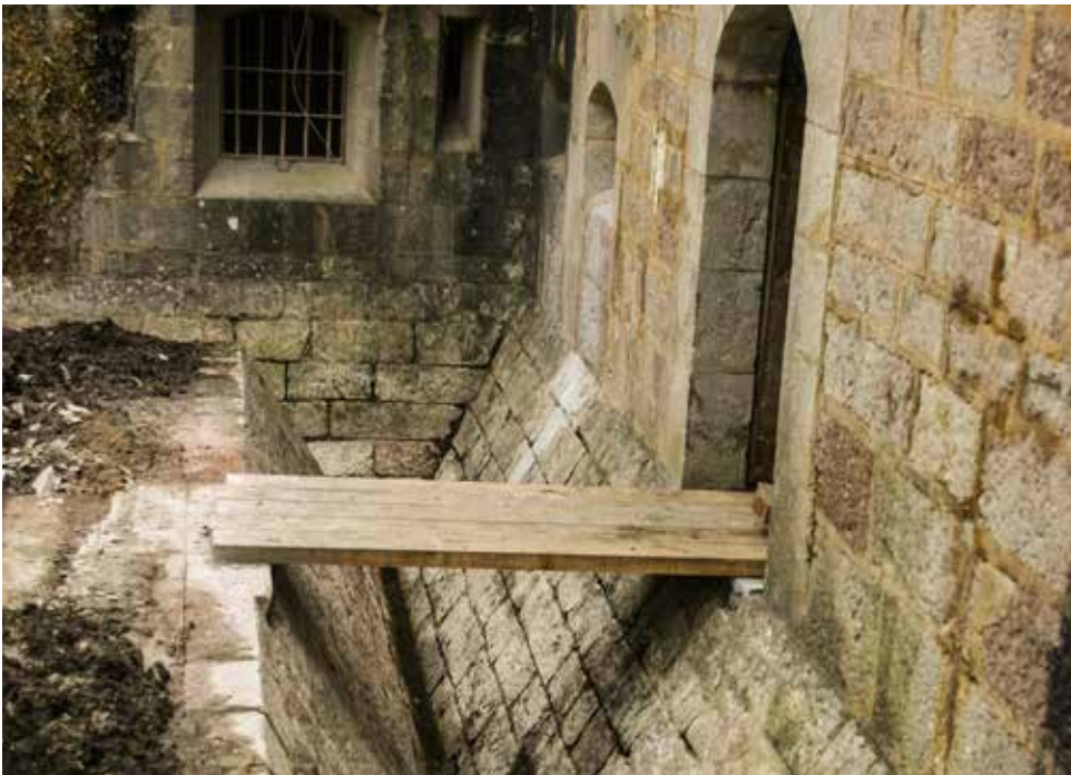
Fosete de la semicaponera con su fondo en punta de diamante y unas tablas de obra que recuerdan, más que el actual, el puente móvil original. Al Fondo se aprecia una de las cañoneras con dos aspilleras para el flanqueo del foso.
