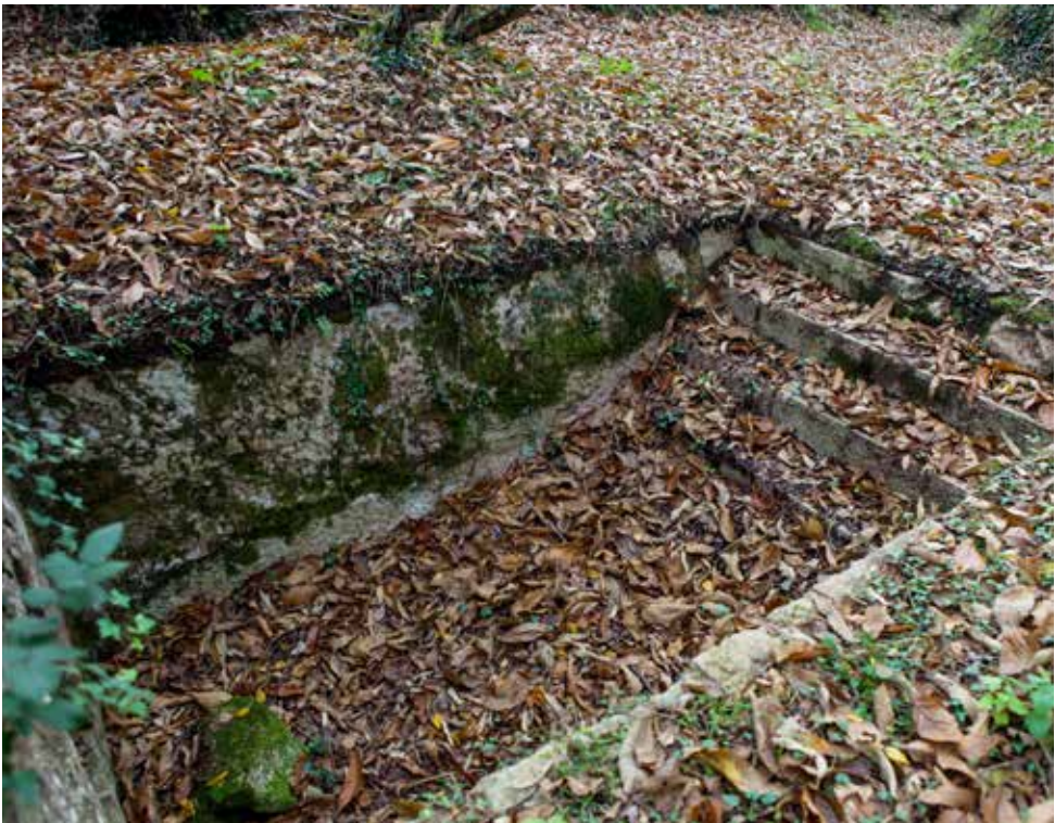
Trinchera-abrigo en la batería auxiliar de Kutarro, parcialmente colmada de tierra.
