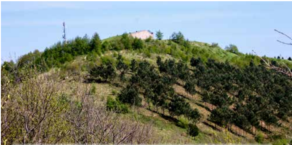
Glacis del Fuerte en la zona de gola. Se aprecia la fuerte pendiente del terreno natural que no fue preciso modificar para formar el glacis.
