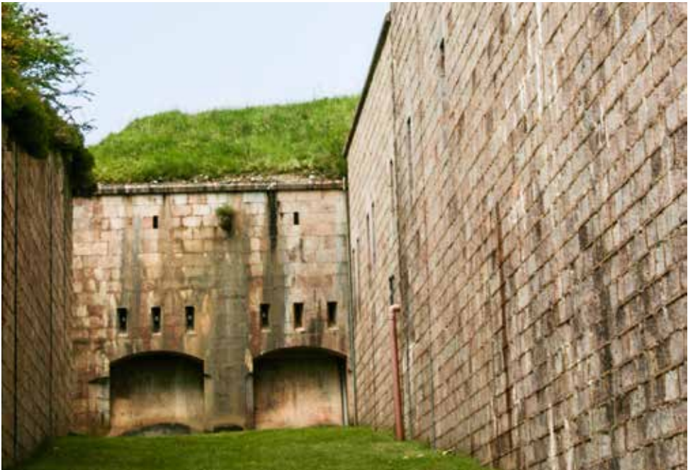
Caponera de cabeza en disposición de flanquear mediante seis aspilleras para fusilería el sector sur del foso. Dos matacanes defenderían las inmediaciones de la caponera
