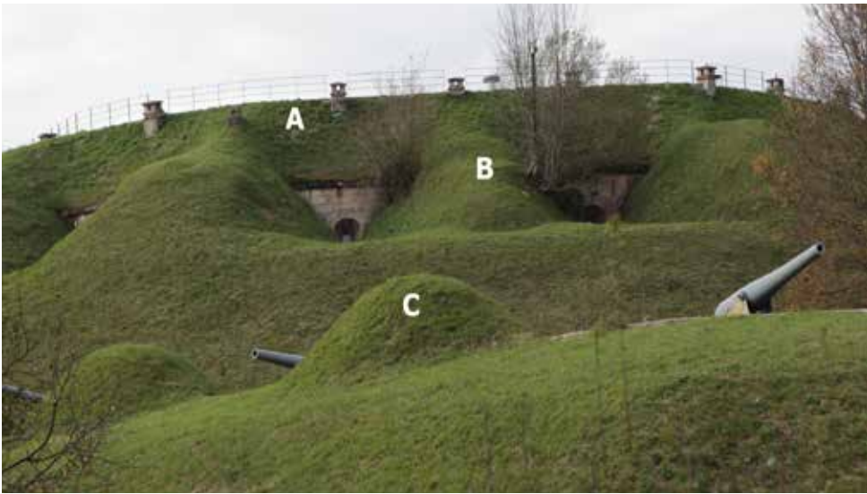
Vista del Fuerte desde el camino cubierto. La mayor parte de los volúmenes cubiertos por césped son blindajes. A: Blindaje superior de la batería acasamatada. B Blindaje del muro de máscara de la citada batería. C Blindaje de un través de la batería a barbeta.
