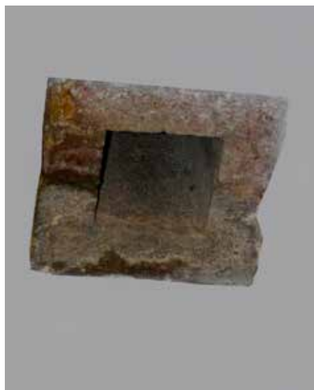
inicio de una chimenea (14) de ventilación en la bóveda de una casamata.
