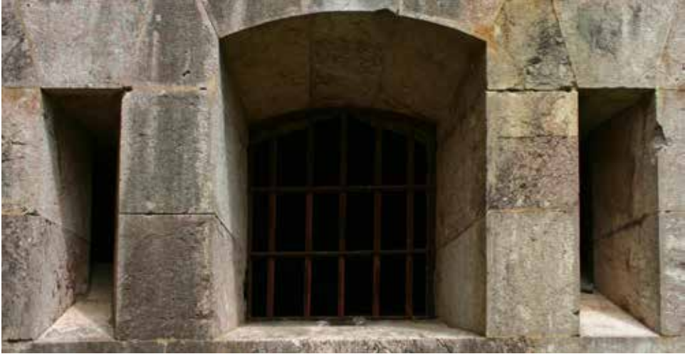
Vista exterior de una de las cañoneras de la caponera de cabeza para ametralladora.
