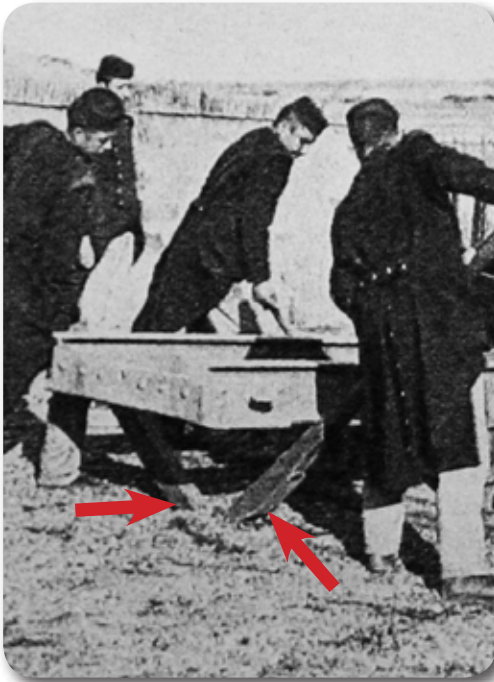
Los servidores apoyan los espeques en el suelo y en el marco de un obús igual a los instalados en San Marcos, con objeto de moverlo haciendo palanca.
