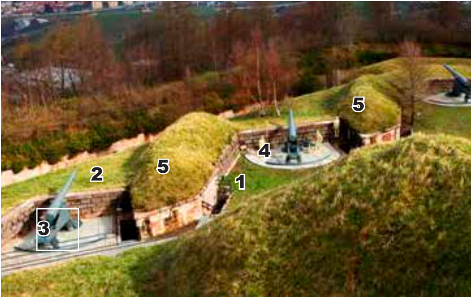
1 Adarve de combate (o terraplén de combate). 2 Parapeto. 3 Pieza de artillería. 4 Explanada de la pieza de artillería. 5 Traves. Las explanadas y la artillería son réplicas.
