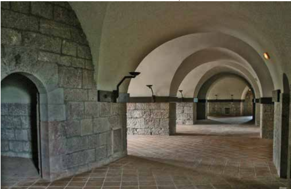
Corredor formado por las comunicaciones entre las casamatas de la batería.
