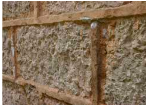
Sillarejo desbastado calizo pequeño con las juntas encintadas.
