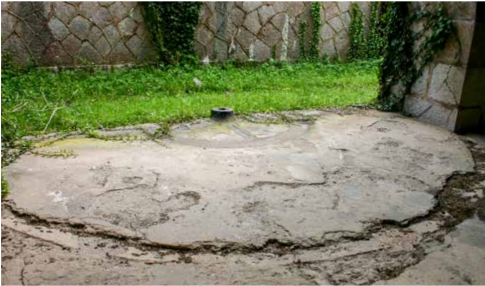
Explanada de un OHS de 21 cm en la batería acasamatada antes de la actuación de 2009. Se aprecia, intacta, la basacarril y vestigios del lugar que ocupaba la carrilera trasera.
