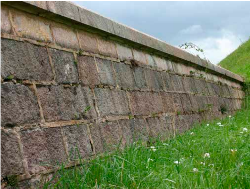
El parapeto está revestido interiormente por un muro de sillarejo rematado por un cordón de sillaría. . En este caso el muro de revestimiento del parapeto tiene un ligero talud.
