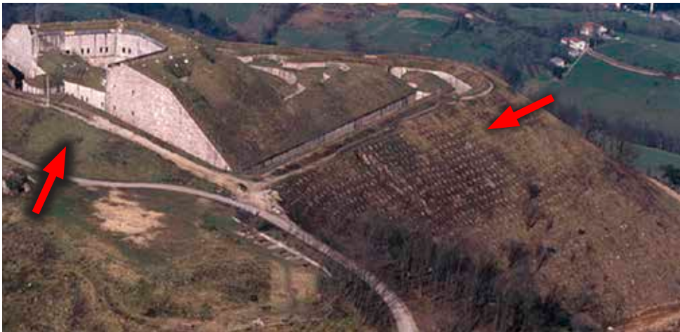
Glacis. En este caso que se prolonga claramente por la pendiente natural del terreno. (Kutxa Fototeka. Colección Pello López. CC by SA).
