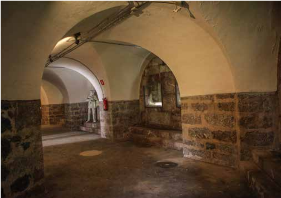
Interior de la caponera de cabeza en el sector de matacanes, con su banqueta de dos gradas donde se subía el tirador, tal y como aparece en la figura del fondo.
