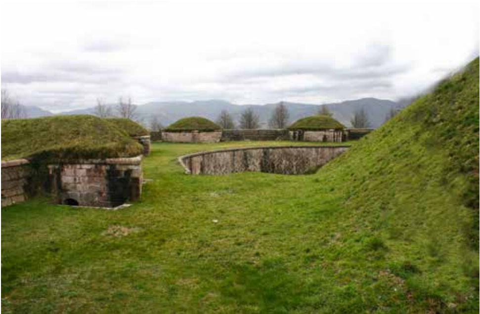
Adarve de combate en la batería a barbeta de la Obra Baja del fuerte de San Marcos.
