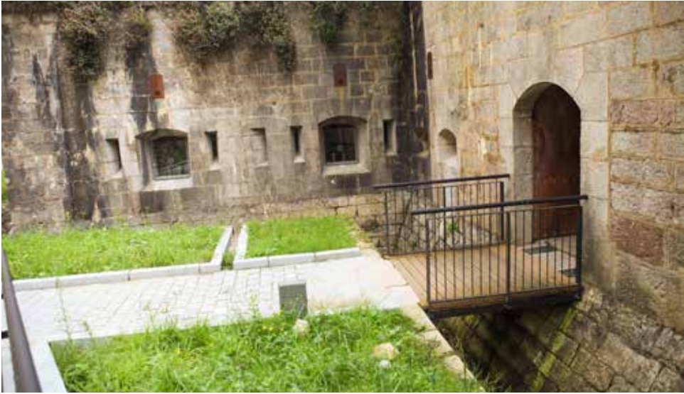
Fosete de la semicaponera tras la remodelación de 2009. Se ha construido un puente fijo para salvar el fosete dotado de barandilla para cumplir con las normativa de seguridad. Al fondo se observan las cañoneras y aspilleras de flanqueo del foso. La pavimentación que se observa en el foso no es original.
