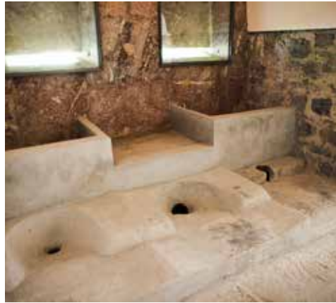
Letrina instalada en un ala de la caponera de cabeza, reformada en 1939 y rehabilitada parcialmente en 2009. Dos retretes turcos y un retrete convencional (falta la taza).
