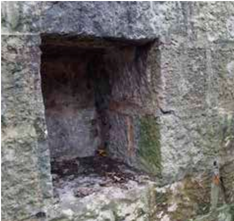
Repuesto de mano (40x30x25 cm) en el interior de una trinchera-abrigo de la batería auxiliar de los Barracones.
