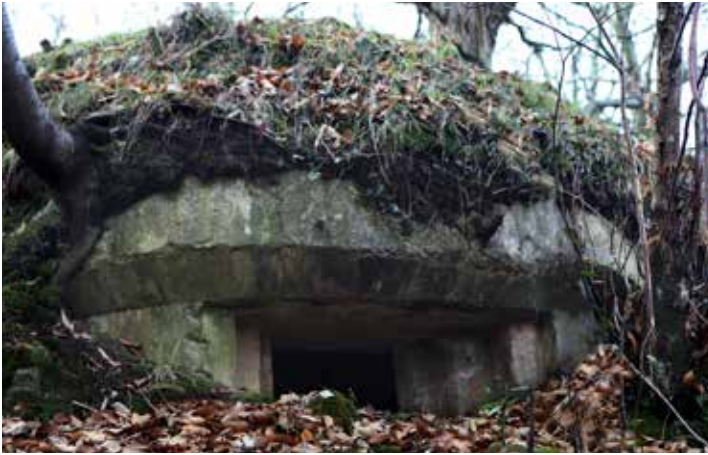
Centro de Resistencia 245 "Guadalupe", obra 32, nido para un fusil ametrallador. Situado 450 m al NE de la torre oriental de Jaizkibel .
