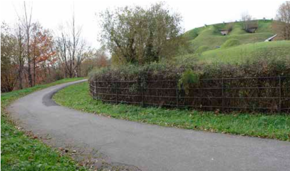
Camino cubierto, parcialmente asfaltado y con el parapeto (a la izquierda) prácticamente eliminado. A la derecha se aprecia el Fuerte, ya que es una de las zonas de observación en la que se mantiene la vegetación más baja que en el resto, pero que impide la visión del foso.
