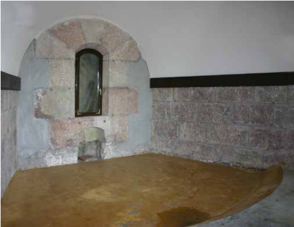
Explanada de los Cañones HE "Ordóñez" en su estado original, con su rebaje, si bien parte de la basacaril está cubierta por un piso de hormigón. Corresponde a una de las casamatas con la cañonera cegada.
