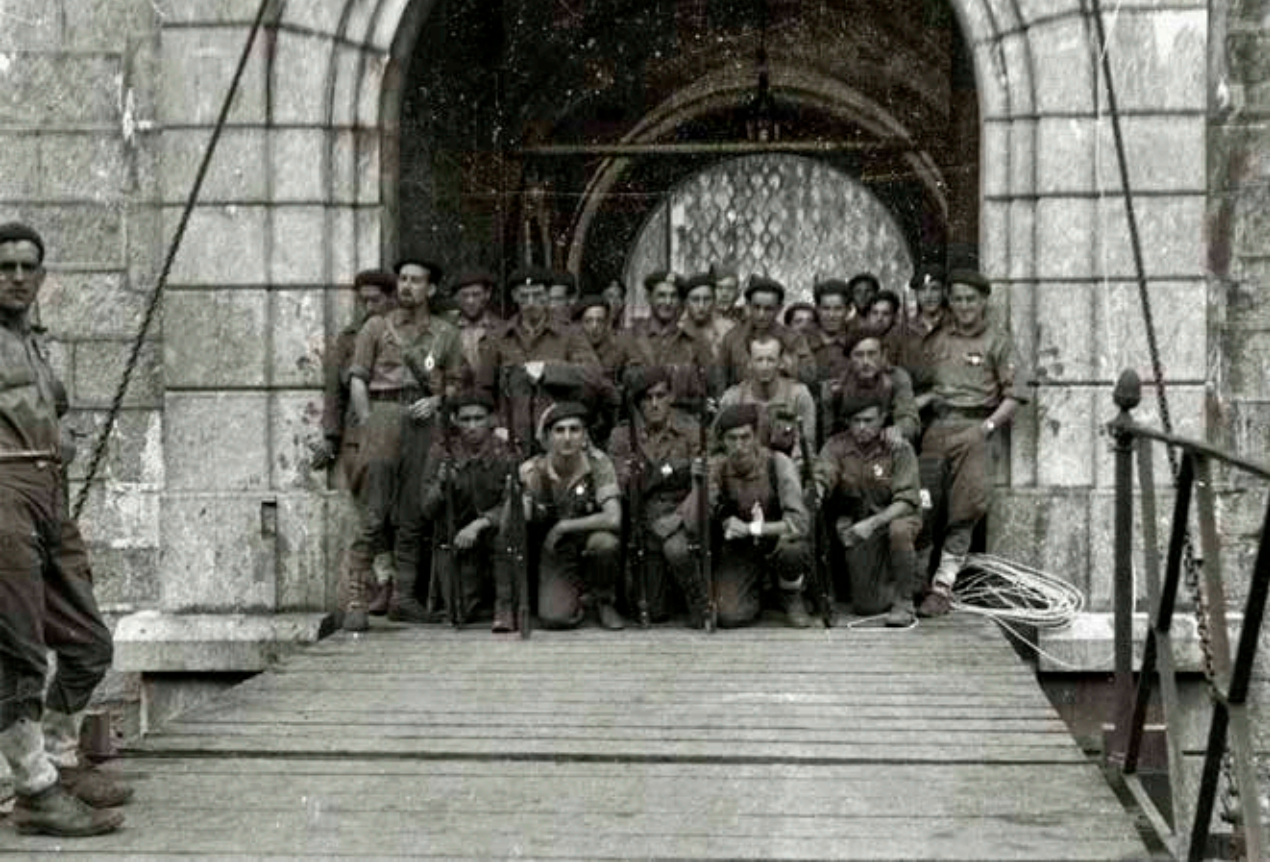
Imagen histórica durante la Guerra civil. El puente es todavía el original. Se aprecia el sector móvil, con sus cadenas e incluso, detrás de las tropas sublevadas, un eje metálico que forma parte del sistema Derché para el movimiento de la parte levadiza del puente. (Fot.: Pascual Marín. Kutxa Fototeka CC by SA).
