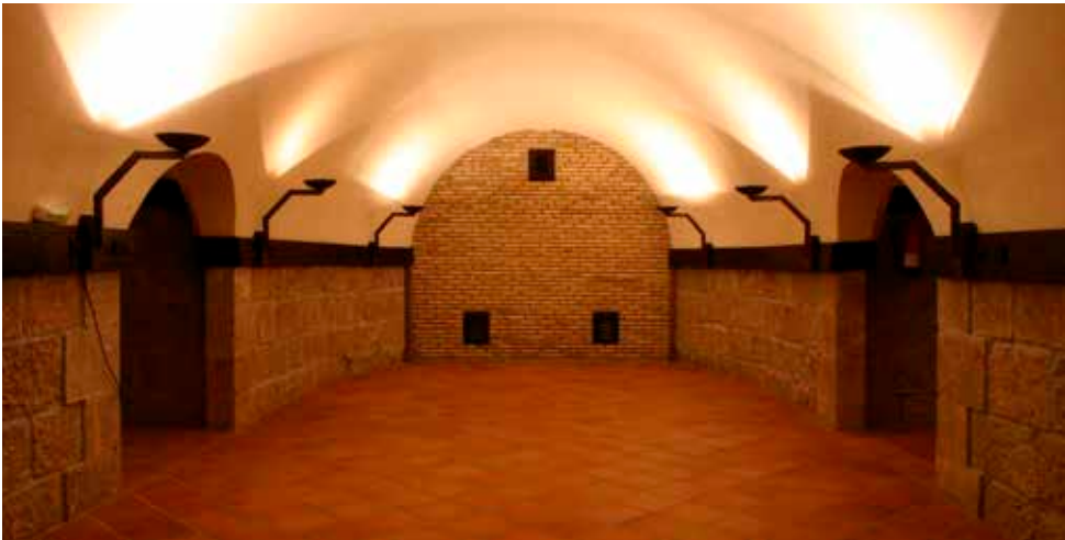
Vista longitudinal del almacén de pólvoras. Al fondo se aprecia los orificios de ventilación que comunican con una cámara de aire aislante. y a los lados las comunicaciones con las estancias destinadas a los montacargas de pólvoras (izquierda) y de proyectiles (dcha.).
