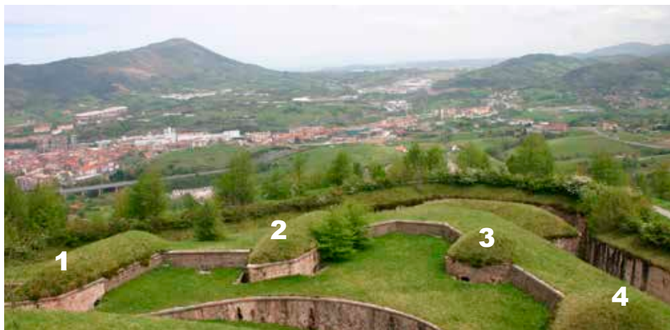
Vista general de la batería a barbета de la Obra Baja, con los cuatro únicos traveses que presenta el Fuerte.
