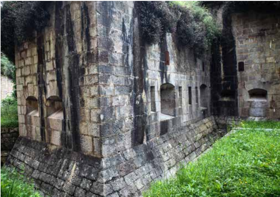
Exterior de la semicaponera. Su rente está formado por 2 ametralladoras y cuatro aspilleras (una de ellas de doble salida).
