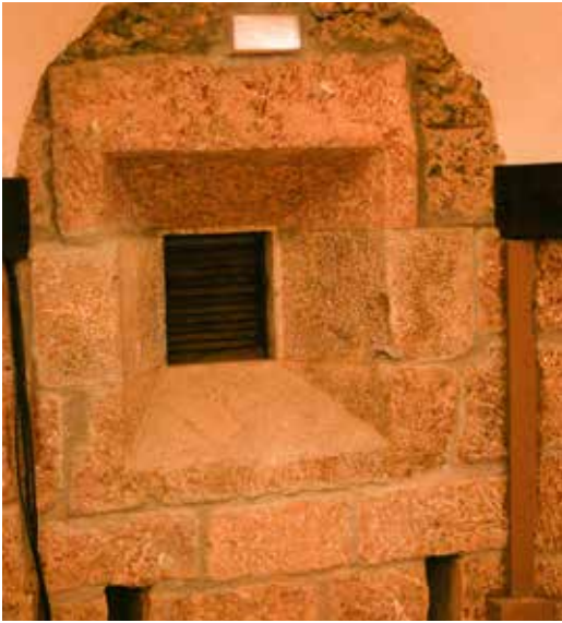
Ventana de luces del almacén de pólvora situado en la Obra Alta, bajo la batería acasamatada.
