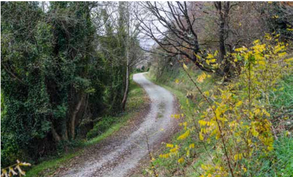
Vista parcial del sector 2 del camino militar en proximidad de su intersección con el acceso a la batería de Kutarro. El firme actual es de tierra con gravilla.
