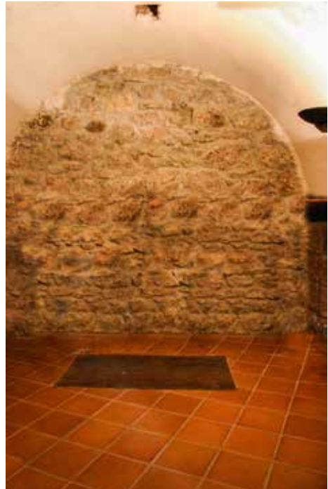
Estación superior del ascensor de pólvora. únicamente se conserva el boquete de la caja del ascensor. En la bóveda se aprecia un orificio de aireación.
