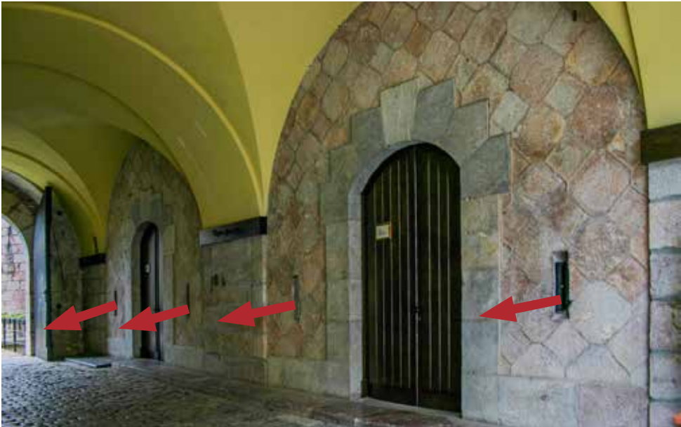
Aspilleras verticales defendiendo el vestíbulo de acceso desde el pabellón del Gobernador. En el lado opuesto hay otras cuatro aspilleras que parten del cuerpo de guardia.
