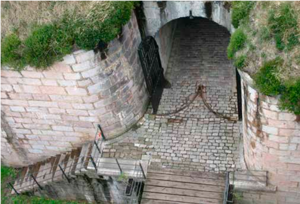
Boca interior del túnel de acceso, con la reja de cierre interior. A su izquierda se aprecia la escalera de acceso al foso y enfrente, el puente.
