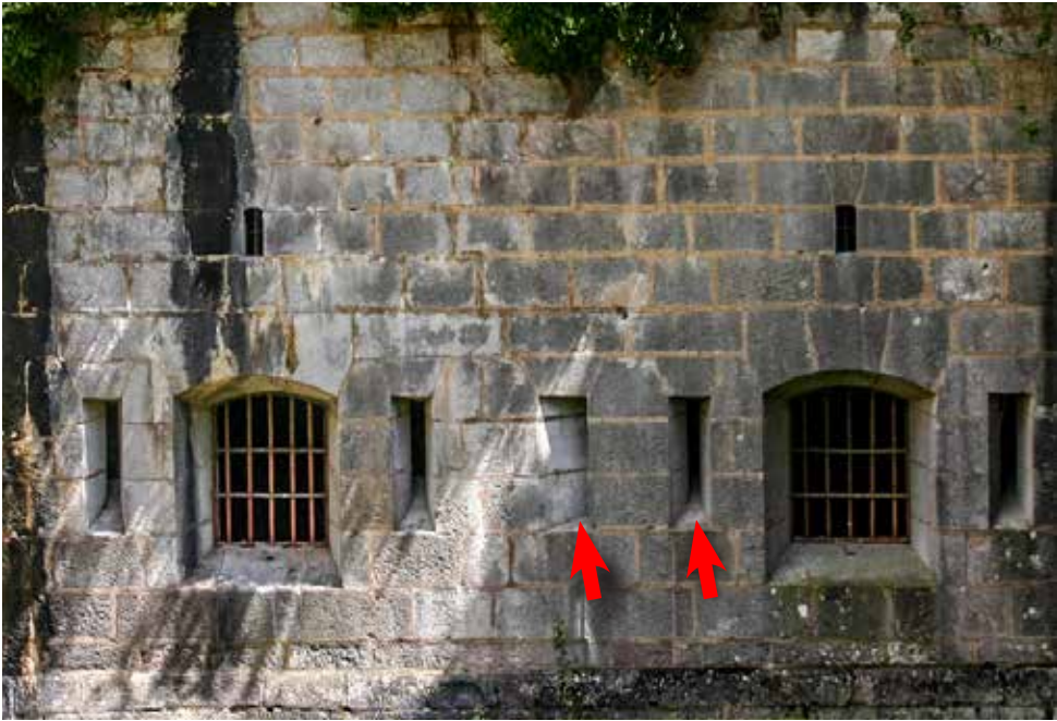
Aspilleras verticales dispuestas a los lados de las cañoneras de la semicaponera, destinadas a la defensa del foso. Los orificios superiores son ventiladores. Las señaladas con flechas tienen un único acceso desde la caponera (véase fotografía y plano).
