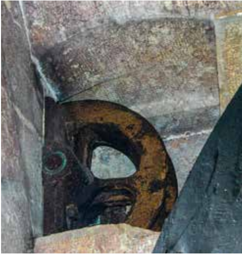
Rueda (3) de cambio de dirección de la cadena que une el tablero y el tambor.
