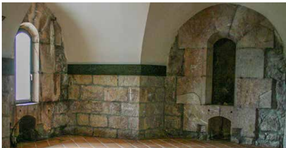
Cañoneras de una de las casamatas de gola. Se aprecia, la cañonera de la izquierda (de gola) abierta y la de la derecha, orientada hacia el frente, cerrada por el blindaje exterior.
