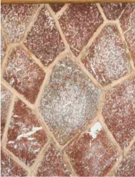
Mampostería concertada encintada, en los muros de cierre de las casamatas de la batería de fuegos curvos.
