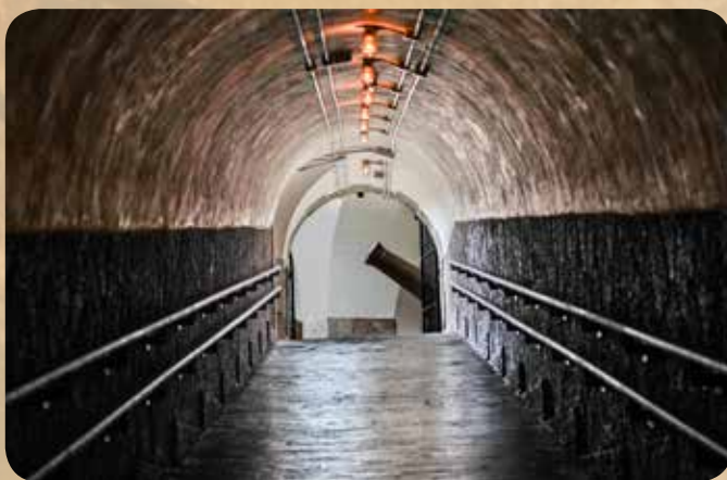
Poterna de la semicaponera (C) desde la que se aprecia la batería de fuegos curvos (A)..
