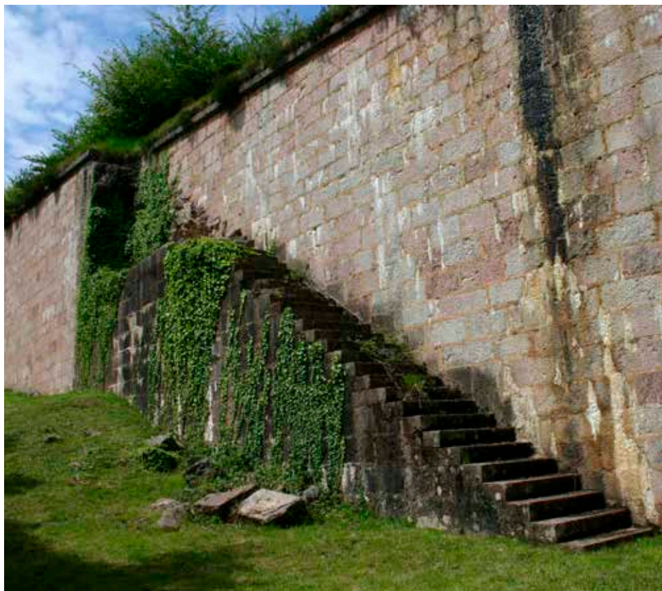
Escalera de contraescarpa situada frente a la semicaponera (1). Su parte central fue eliminada para evitar la entrada incontrolada al Fuerte.
