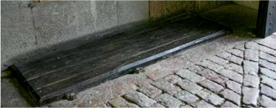
Uno de los dos fosos (cubierto por una puerta) para acoger el contrapeso del sistema.
