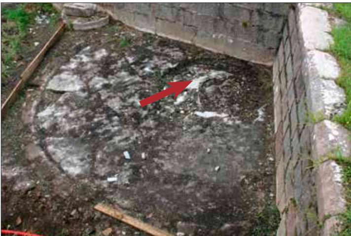
Vestigios de una de las explanadas pertenecientes a los CHE de 15 cm que artillaron la batería a barbata encontrados en el momento de la musealización. En el ángulo del parapeto se observa un círculo que corresponde a la impronta de la basacarril. De ella emergían ocho espárragos de sujeción de la misma.
