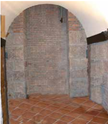
Estación inferior ascensor de proyectiles del que solo queda la caja revestida de ladrillo.
