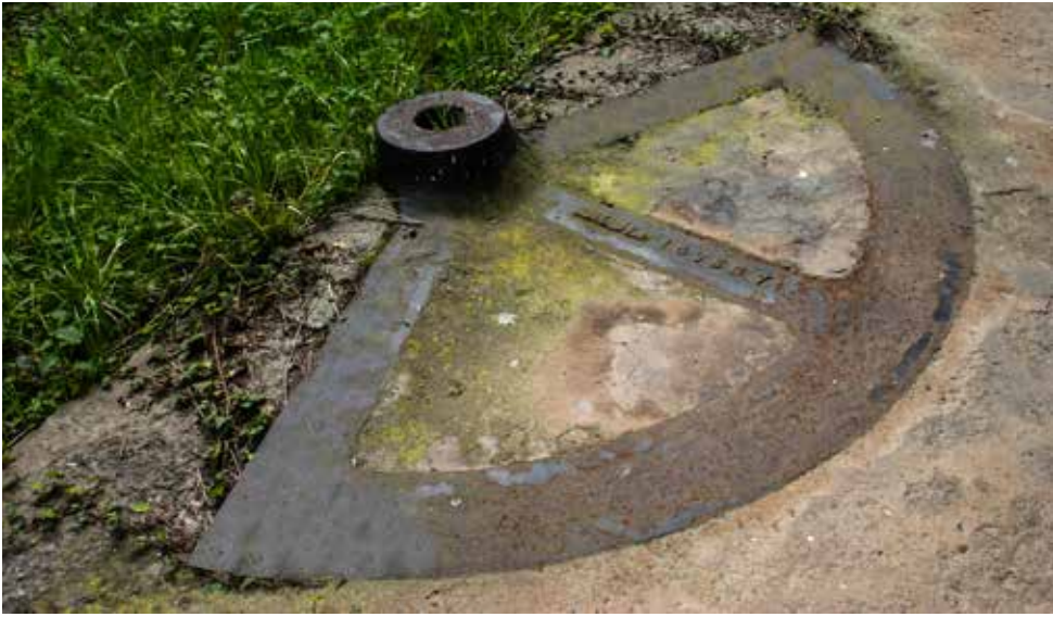
Una de las tres basacarriles de Obús de Hierro Rayado y Sunchado de 21 cm. El orificio que se aprecia estaba destinado a acoger el perno pinzote en torno al cual giraba el obús.
