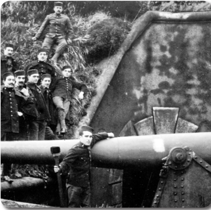
El artillero del primer plano de la fotografía sujeta con una mano un atacador, mientras apoya la otra en un cañón de Hierro Entubado Ordóñez de 15 cm, mod. 1885, sobre marco alto, similar a los cinco instalados en la Obra Baja del fuerte de San Marcos. (Batería de la Diputación de Gipuzkoa, en Mompás - San Sebastián). (Kutxa Fototeka CC by SA).
