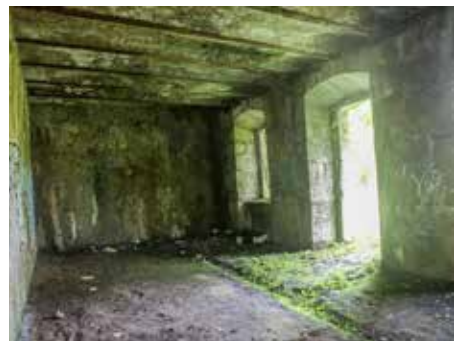
5 Interior del cuerpo de guardia de la batería auxiliar.
