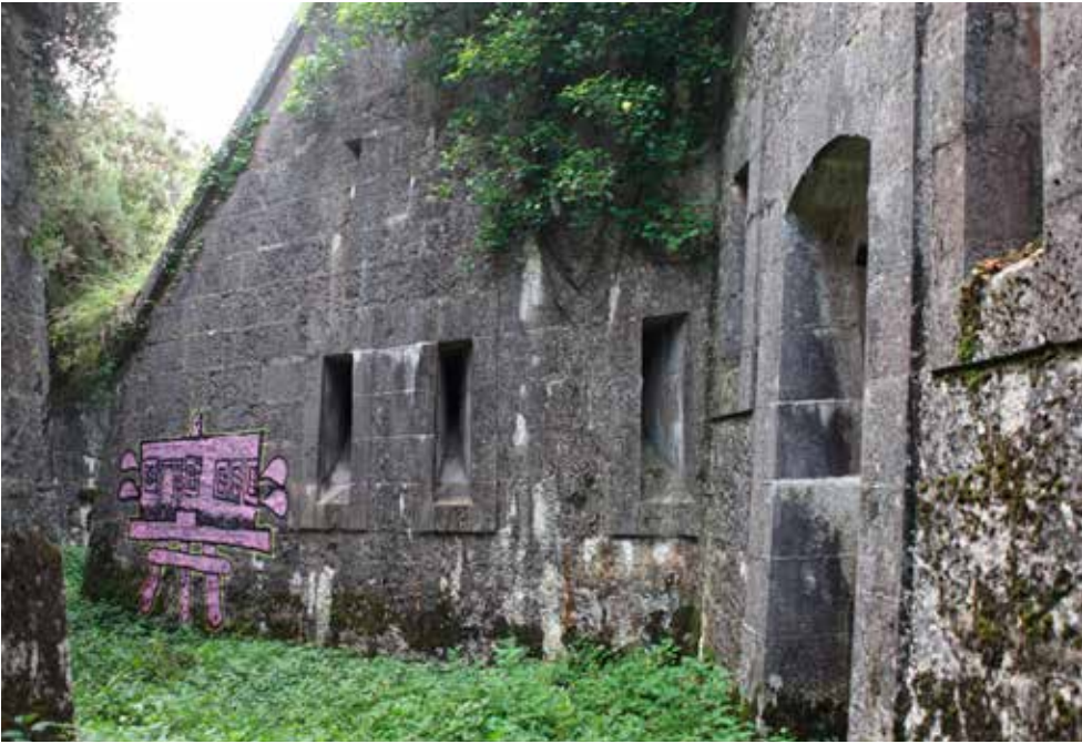
Semicapонера con tres aspilleras para fusil que flanquean el tramo de foso n. 9 y defienden también la puerta de acceso al foso del cuartel.
