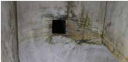
Corredor de circulación. Tiene la función facilitar el acceso a las ventanas de iluminación, proporcionar aireación al depósito de pólvora mediante aireadores de unión y aislar el depósito de la humedad.
