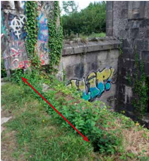
Zona del acceso donde se ha señalado una de las dos cajas del mecanismo del puente.
