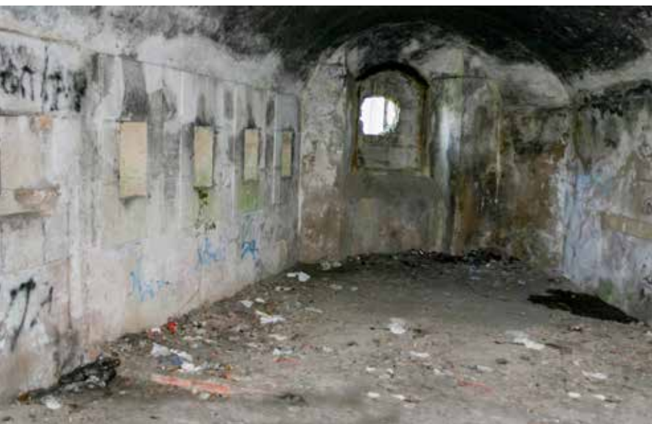
Interior del cuerpo de guardia. A la izquierda, cinco aspilleras dirigidas hacia el acceso del Fuerte. Al fondo, una ventana.
