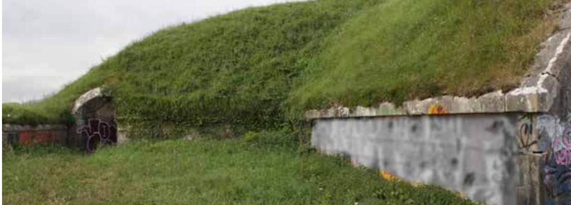
Batería NE. A la izquierda la comunicación con la batería Intermedia.
