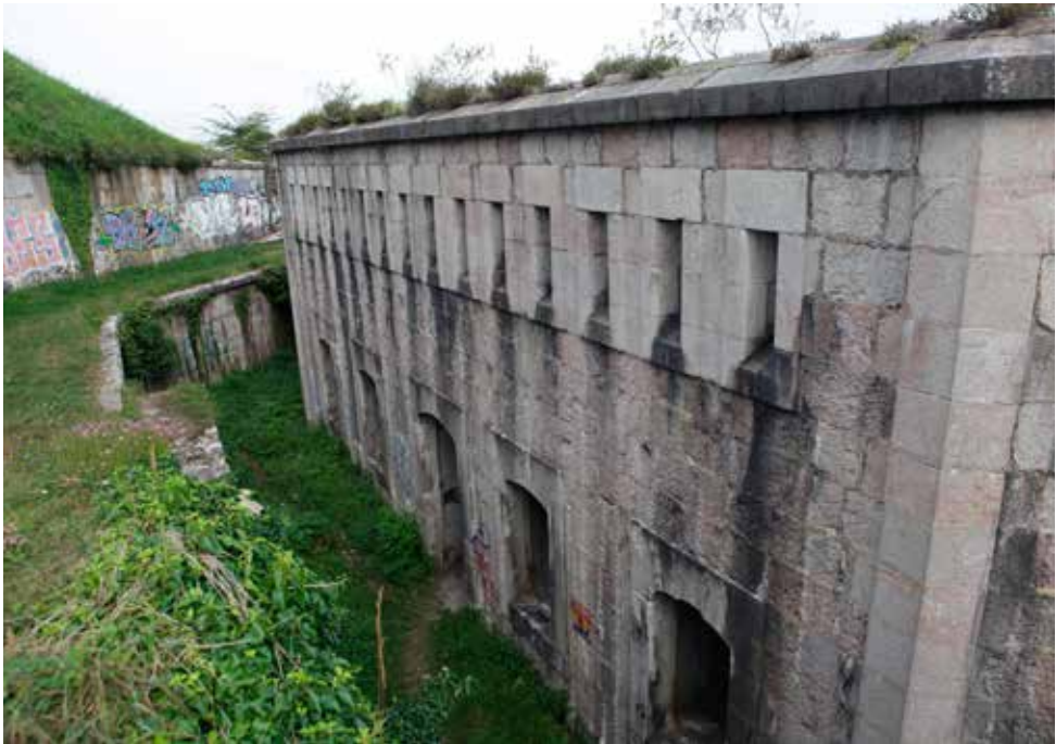
Foso del cuartel. Se aprecia la fachada que incorpora el acceso al cuartel y un sector de la azotea aspillerada.
