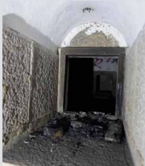
Interior de la ventana de iluminación, dejando ver el conducto superior para salida de humos existente en su bovedilla.
