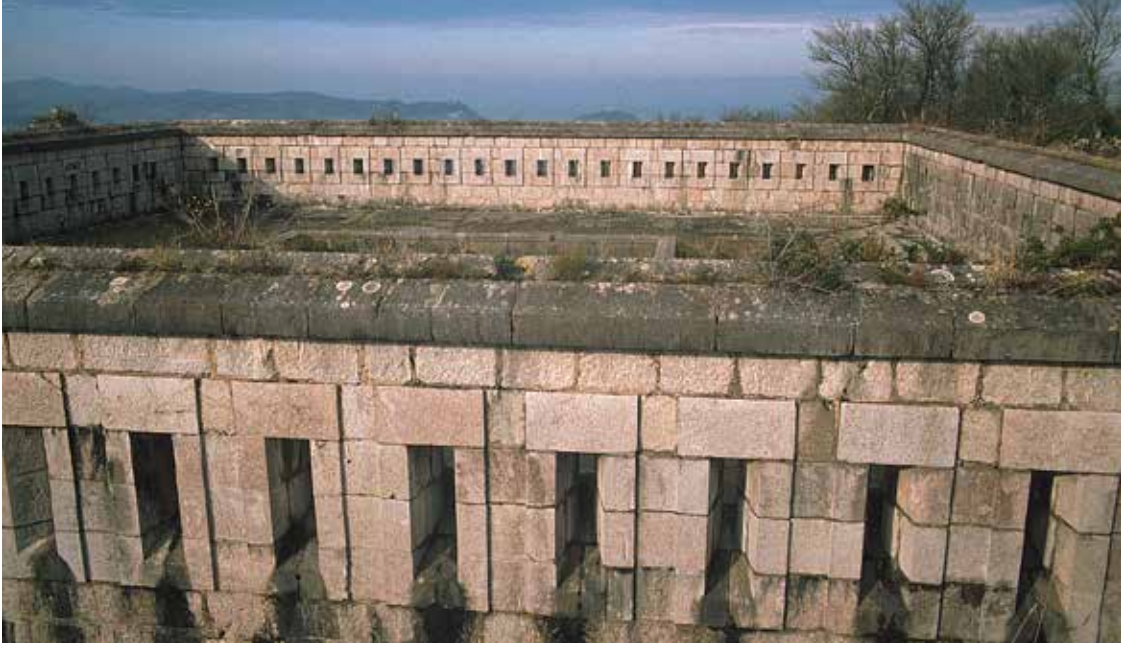
Azotea aspillerada del cuartel.
