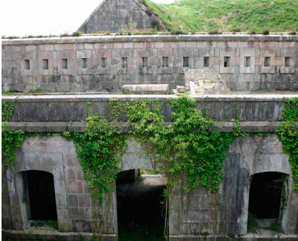
De la parte superior a la inferior de la fotografía: gran través, azotea aspillerada y patio del cuartel
