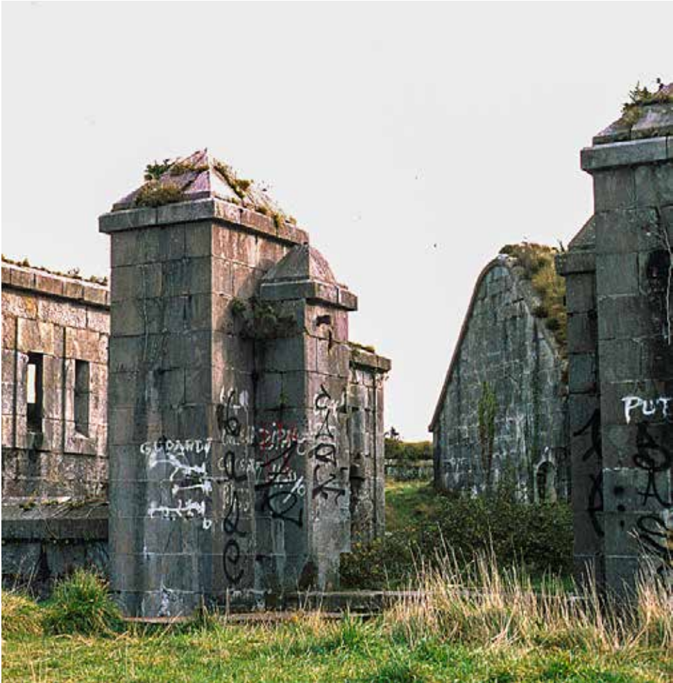
Acceso al Fuerte. En primer plano los soportes del rastrillo de acceso.
