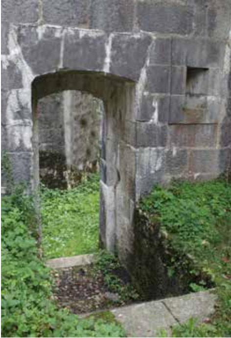
Puerta entre el foso del cuartel y el foso exterior, con su escalera. Vista desde el foso del cuartel.
