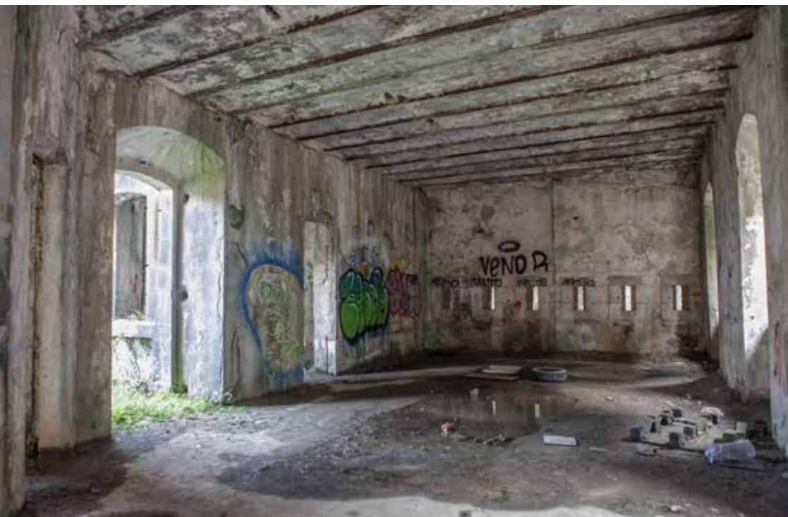
Zona en la que estuvo habilitados los pabellones de oficiales (3) según el Proyecto del Fuerte. realizado por Luis Nieva.
