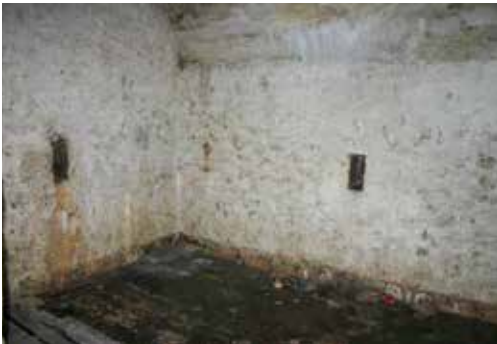
2 Interior del repuesto de proyectiles. Se aprecian los orificios del conducto de ventilación para evitar la humedad.
