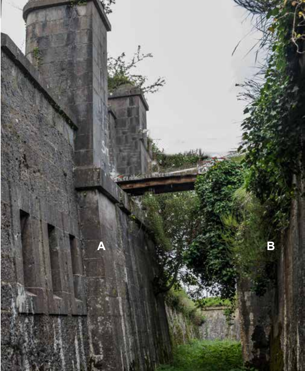
Resaltes en escarpa (A) y contraescarpa para servicio del puente
