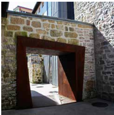
Estructuras de la muralla moderna.
