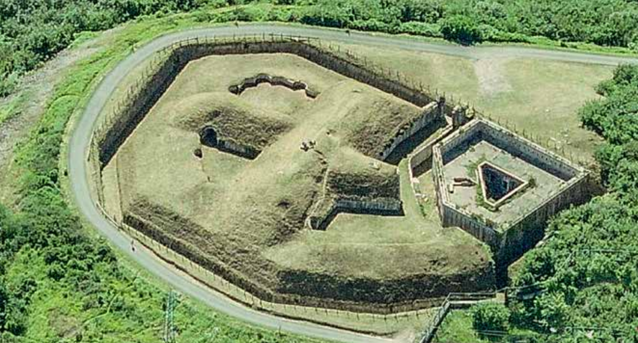
El fuerte de Txoritokieta recién desbrozado. Fotografía aérea: Diputación Foral de Gipuzkoa, 2007.
