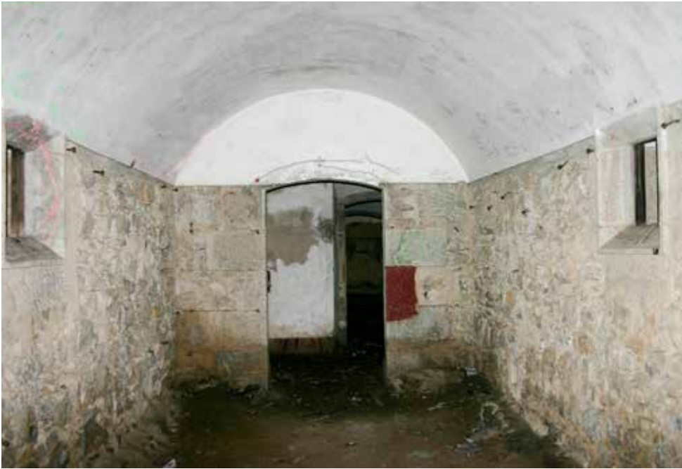
Almacén de pólvora. A los lados se aprecian sendas ventanas de iluminación y al fondo uno de los dos accesos. Está rodeado por un corredor de circulación desde la que se pueden manipular con seguridad las lámparas.
