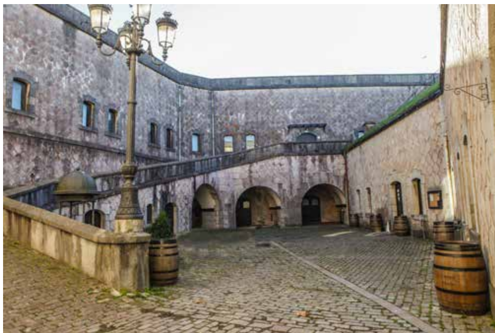
Patio de armas del Fuerte de San Marcos, con la rampa de acceso a la batería acasamatada.
