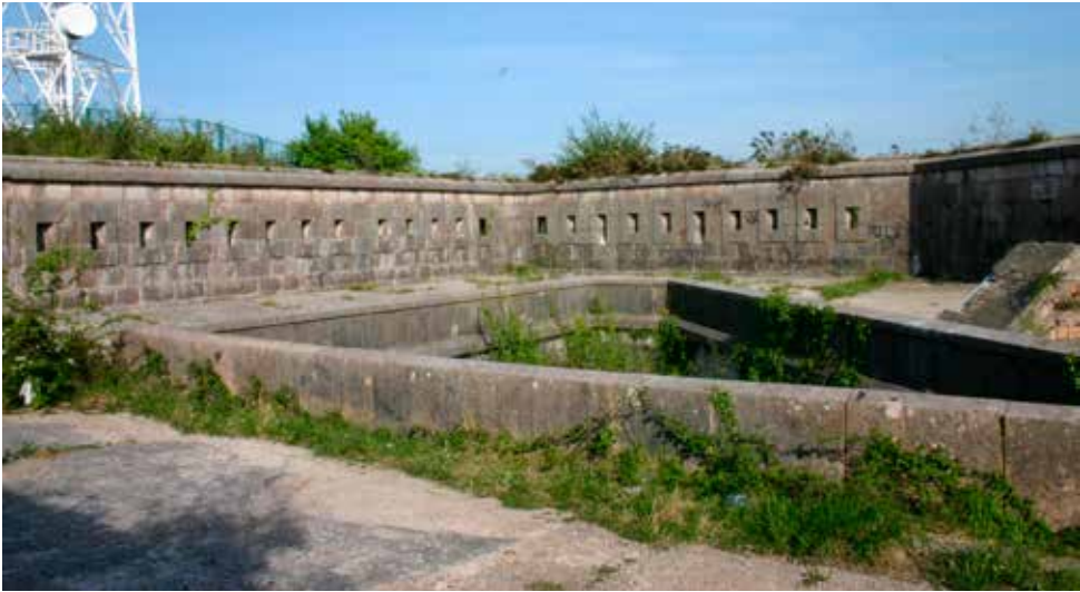
Azotea aspillerada. En el centro se aprecia el patio, protegido por un pretil de sillería.
