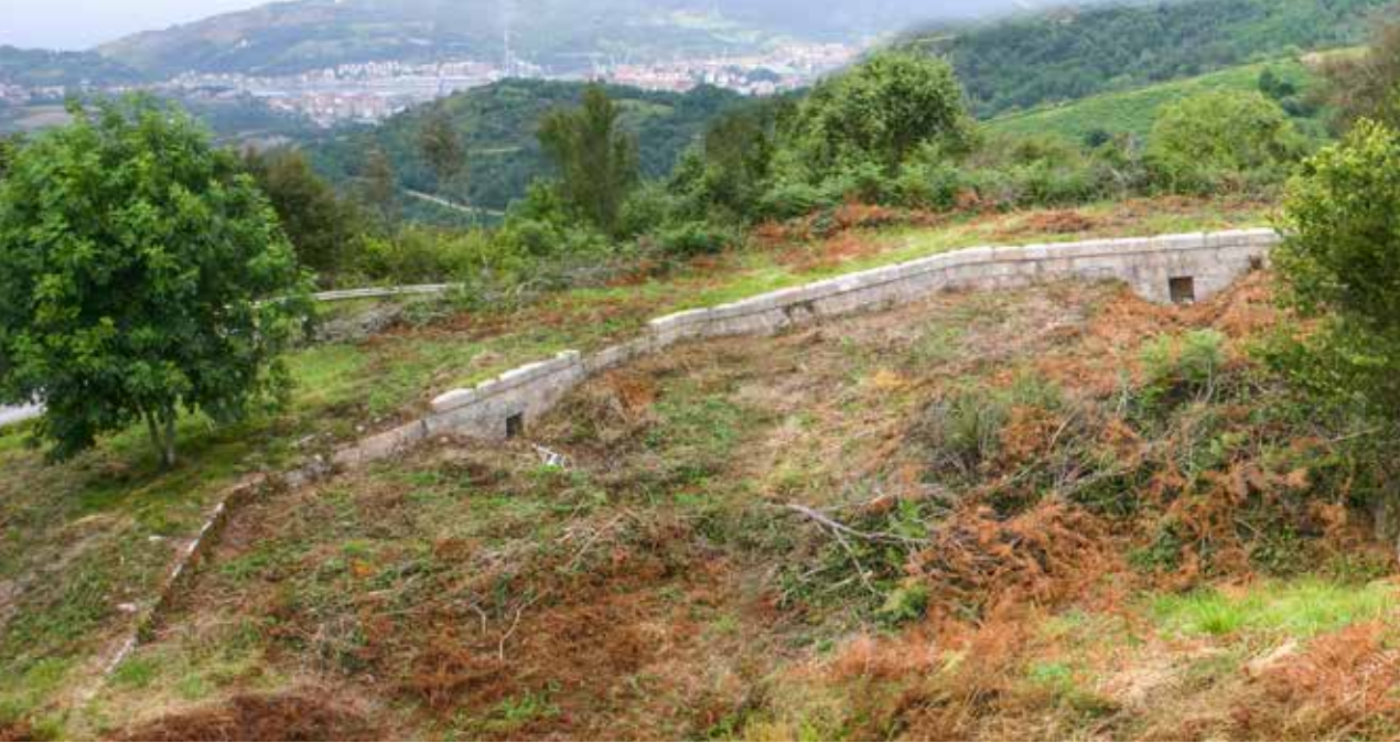
Panorámica de la batería auxiliar
