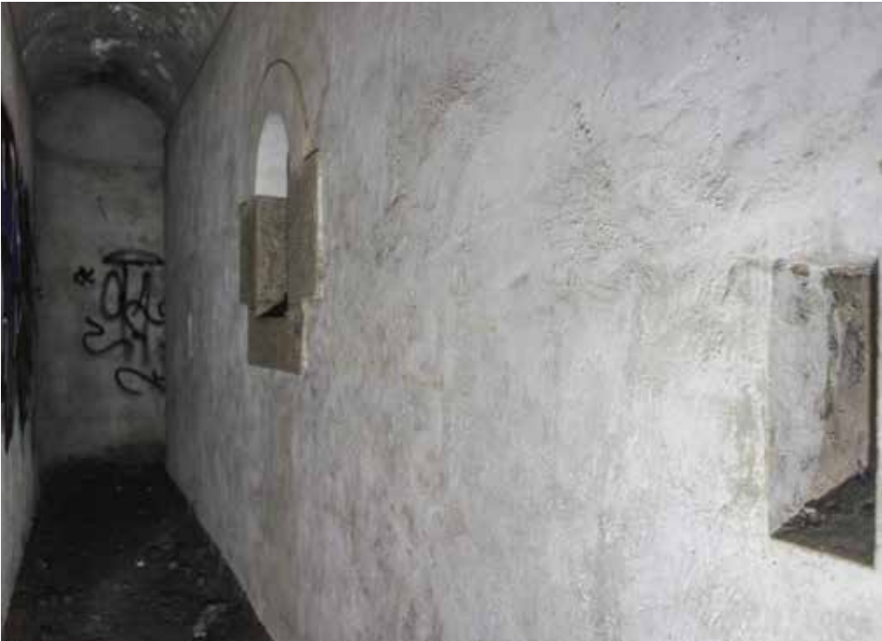
Corredor de circulación. Tiene la función facilitar el acceso a las ventanas de iluminación, proporcionar aireación al depósito de pólvora mediante aireadores de unión y aislar el depósito de la humedad.
