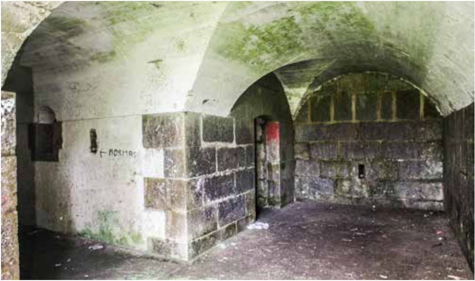
1 Bóveda de acceso al través. A la izquierda la bóveda de acceso al repuesto de proyectiles con la ventana de iluminación del repuesto de pólvora.
