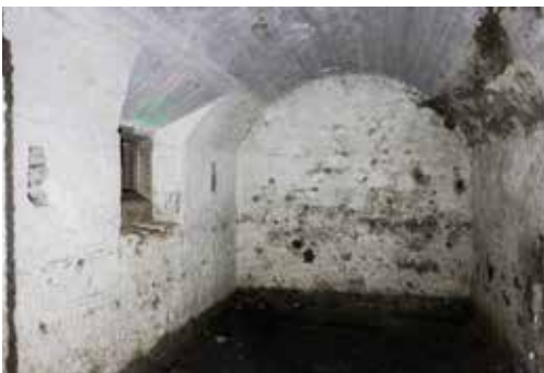
4 Interior del repuesto de pólvora con su ventana de iluminación.
