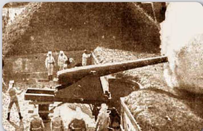
Cañón CHE de 15 cm sobre marco alto, similar a los que artillaron inicialmente el fuerte de Txoritokieta, disparando en una batería a barbata en el Fuerte de Nuestra Señora de Guadalupe (Hondarribia).
