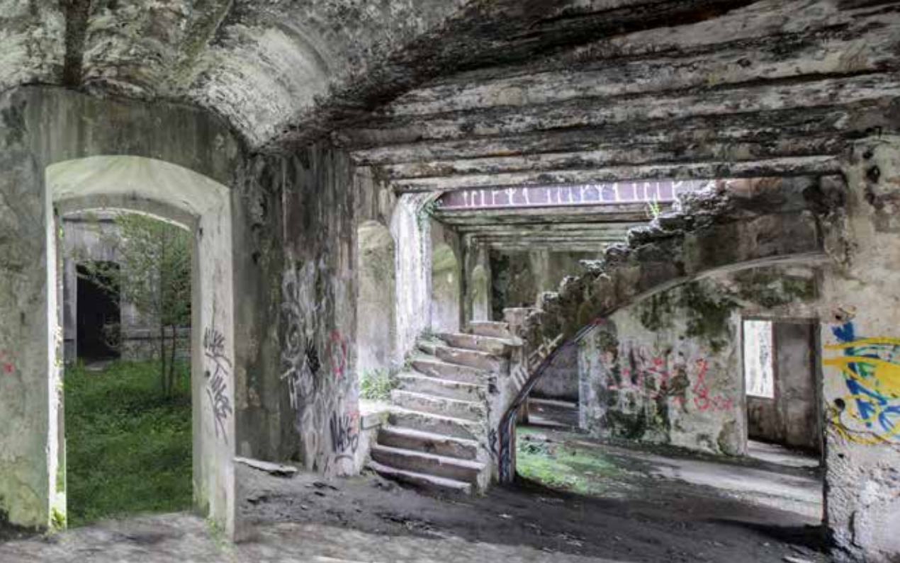
Panorámica que incorpora, de izquierda a derecha, el dormitorio de tropa, uno de los accesos al patio y el sector que incorpora la escalera que conduce a la azotea aspillera.
