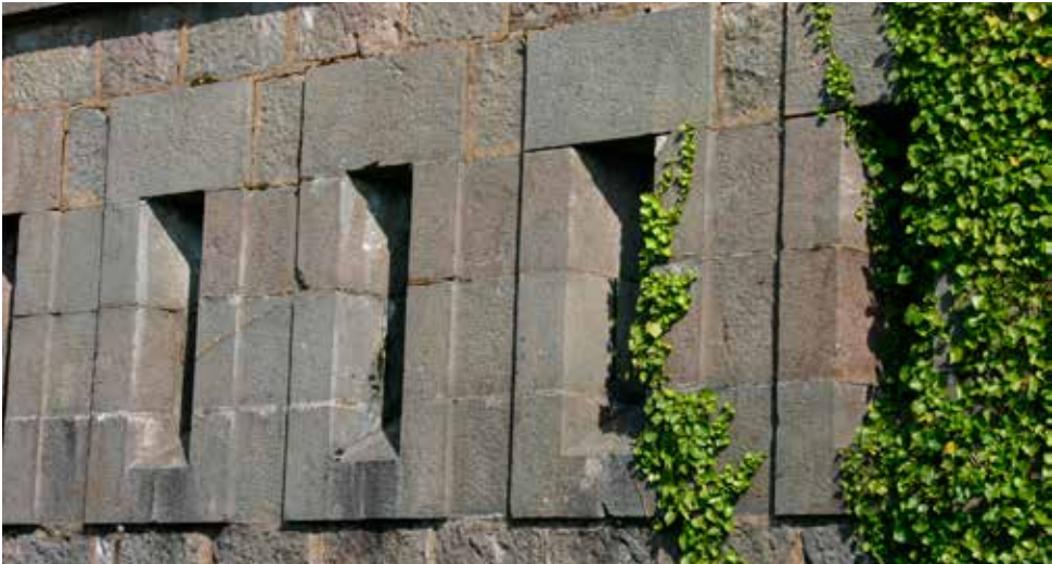
Aspilleras de la azote vistas por el exterior del cuartel.
