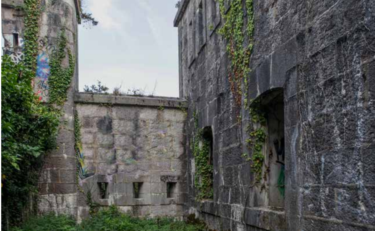
Muro de cierre aspillerado del foso del cuartel. A la derecha se aprecia el cuartel y a la izquierda el entorno de la entrada al Fuerte.
