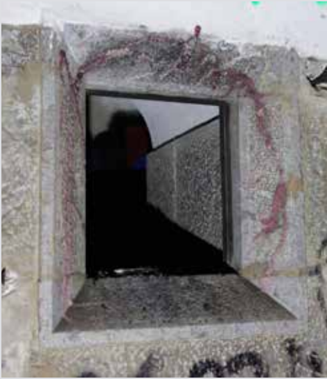
Exterior de la ventana de iluminación (hacia el depósito de pólvora).
