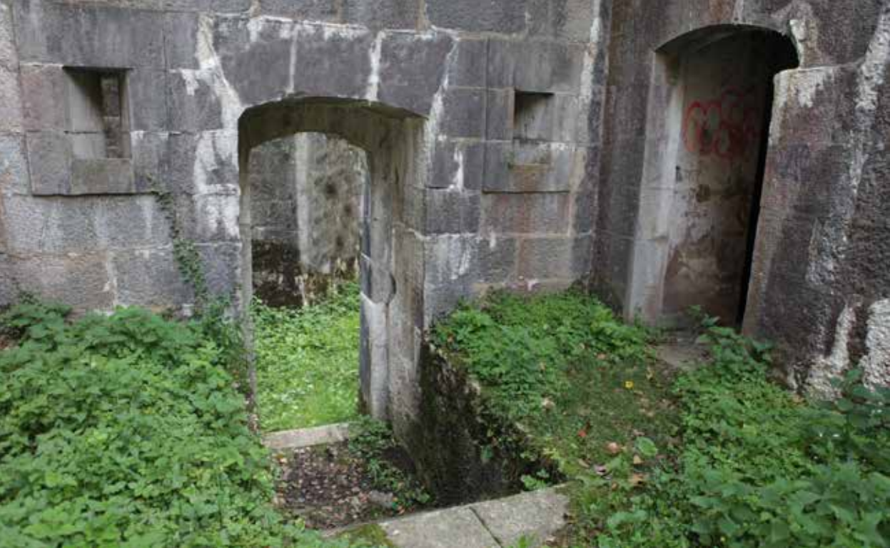
Muro de cierre con dos aspilleas, escalera y comunicación entre el foso del cuartel y el foso general. A la derecha se aprecia el acceso a la batería de flanqueo del foso.
