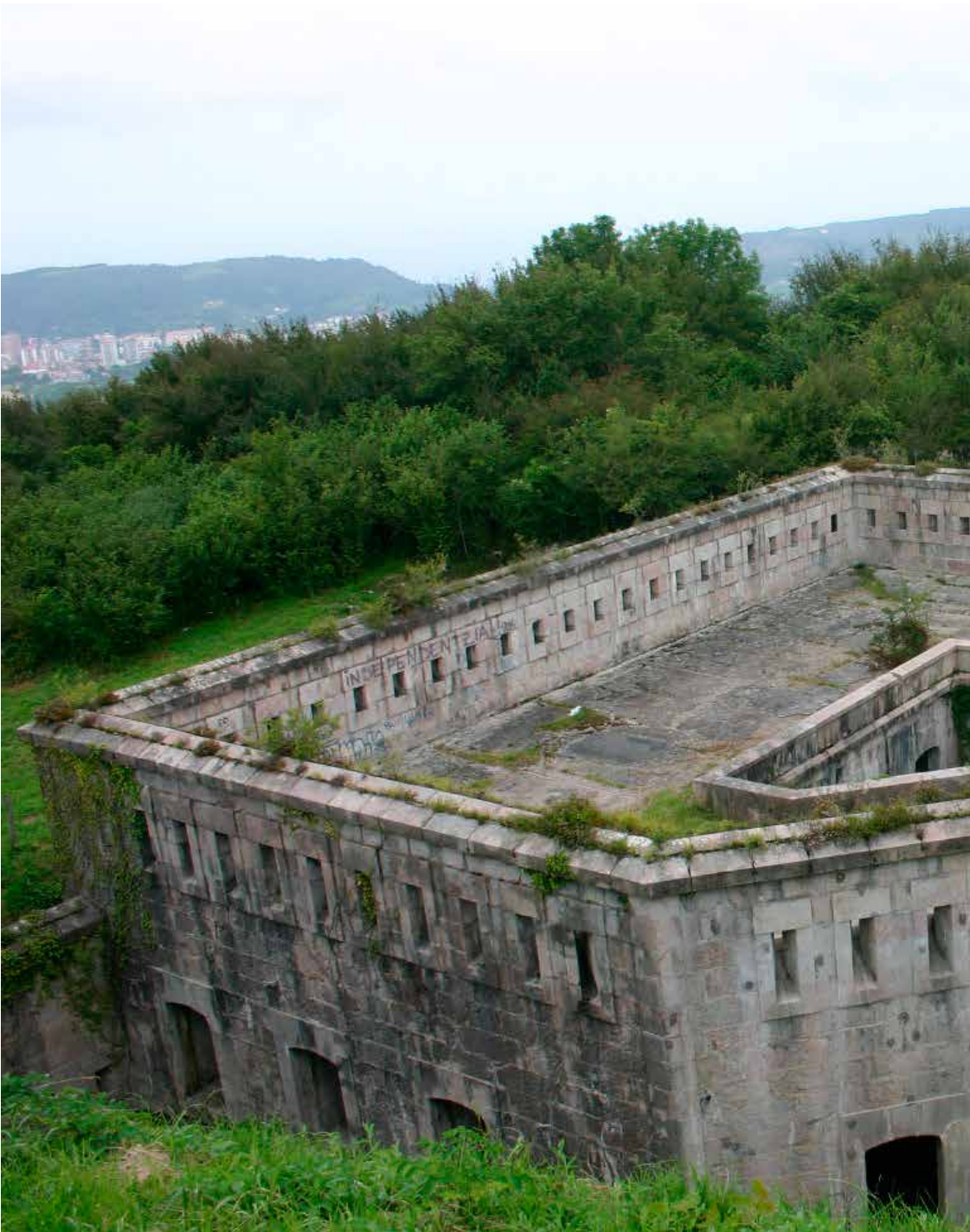
Cuartel de planta pentagonal del Forte de Txoritokieta. Se aprecia claramente el acceso, la azotea aspillerada y el patio central.
