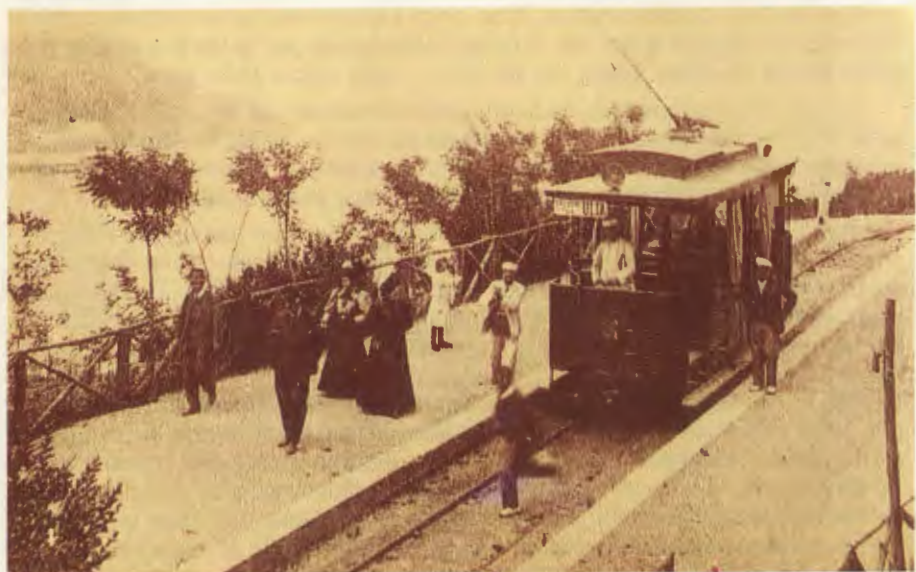
Vista de la terminal del Monte Ulía.
