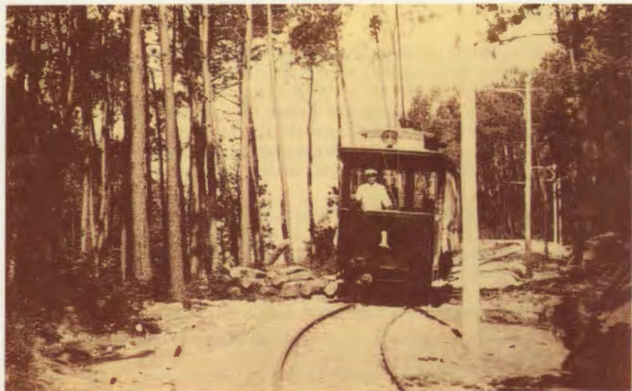
El ferrocarril de Ulía en plena ascensión a la cumbre. Partía desde Ategorrieta hasta la cima del monte a través de una vía única de 3.080 metros de longitud.
