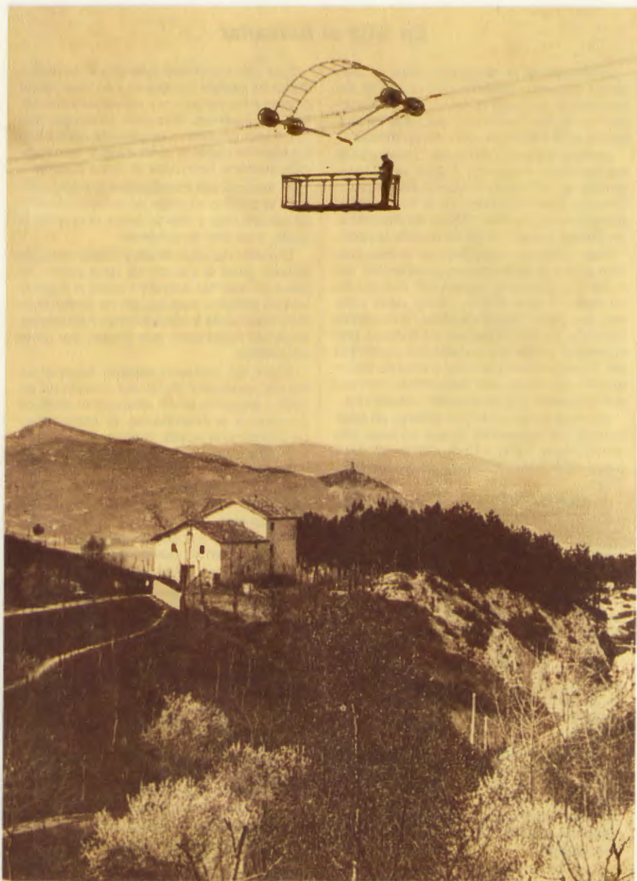
El tranvía aéreo del Monte Ulía. El funicular aéreo con 280 metros de longitud y 28 de desnivel, ideado por Torres Quevedo, llegó a transportar en 1908 a 13.000 personas.
