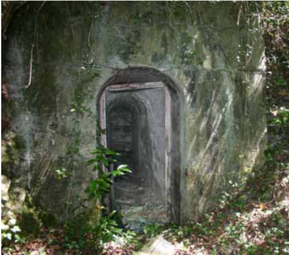
Fig. 69: Obra 25. Acceso en boca de mina visto desde el exterior.
