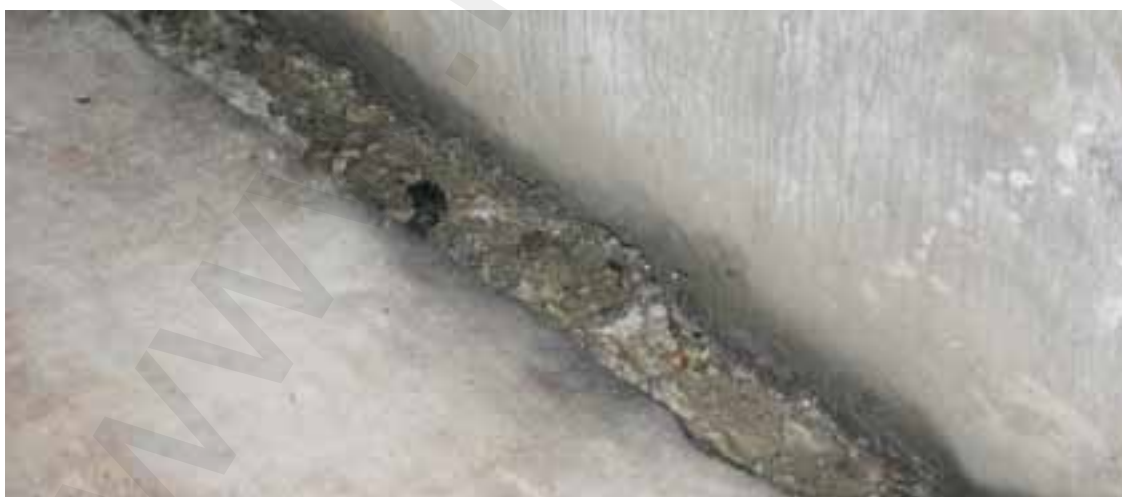
Fig. 5 bis: drenaje lateral de la galería general de Gaintxurizketa.
