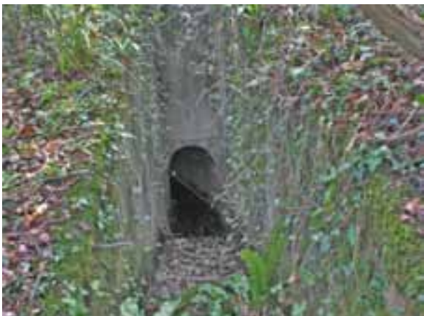
Fig. 54: Acceso a la obra n. 6.
