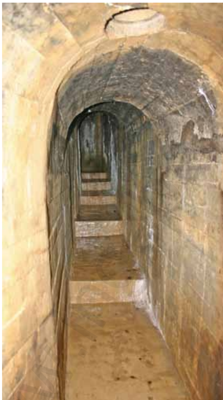
Fig. 6: Galería abovedada de la obra n. 5. Nótese los escalones y el orificio superior.
