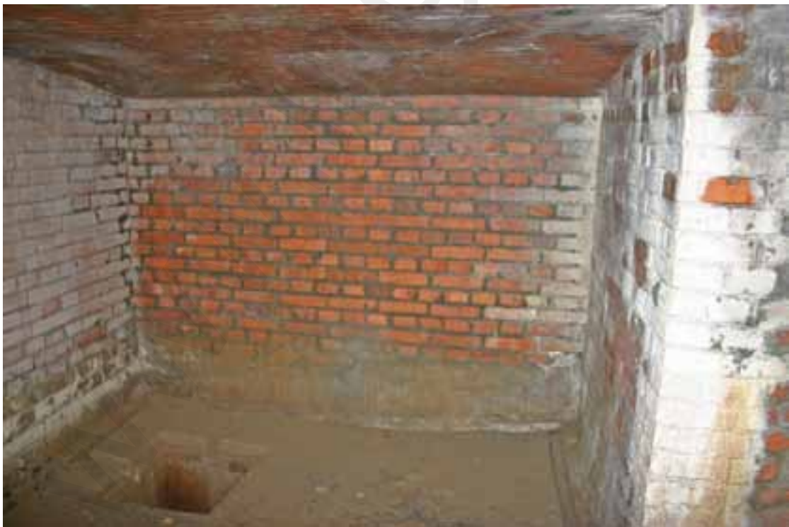
Fig. 72: Obra 25. Interior del depósito de munición. Está totalmente revestido de ladrillo, incluso una bóveda extremadamente rebajada (casi es un techo adintelado). En el suelo se aprecia el sistema de drenaje hidráulico, formado por canalillos que desembocan en un registro.
