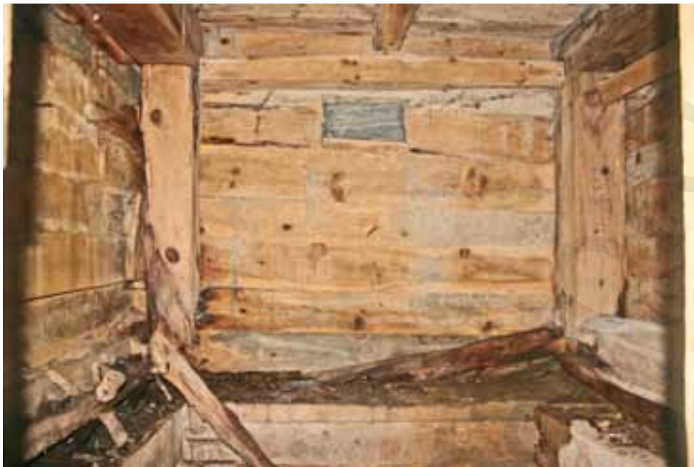
Fig. 5: Interior de un nido de ametralladora de la obra n. 3. Puede apreciarse que conserva el encofrado de madera, así como el resalte inferior de hormigón.
