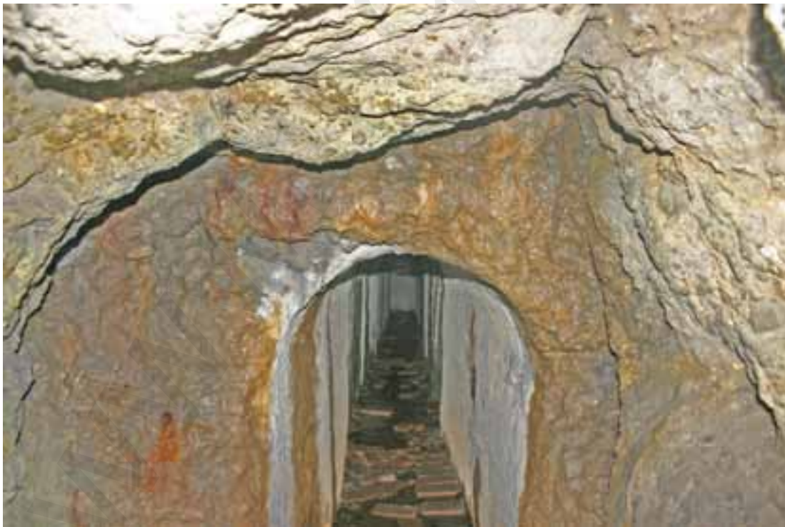
Fig. 79. Observatorio de Arkale. Tercer tramo de la bocamina A. La mitad del mismo está revestido de hormigón, formando bóveda y la otra mitad está excavado en la roca. En la fotografía se puede contemplar el paso entre uno y otro sectores.
