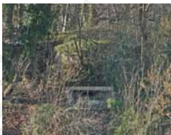
Fig. 57: Obra n. 9. Una de las aspilleras del fortín.
