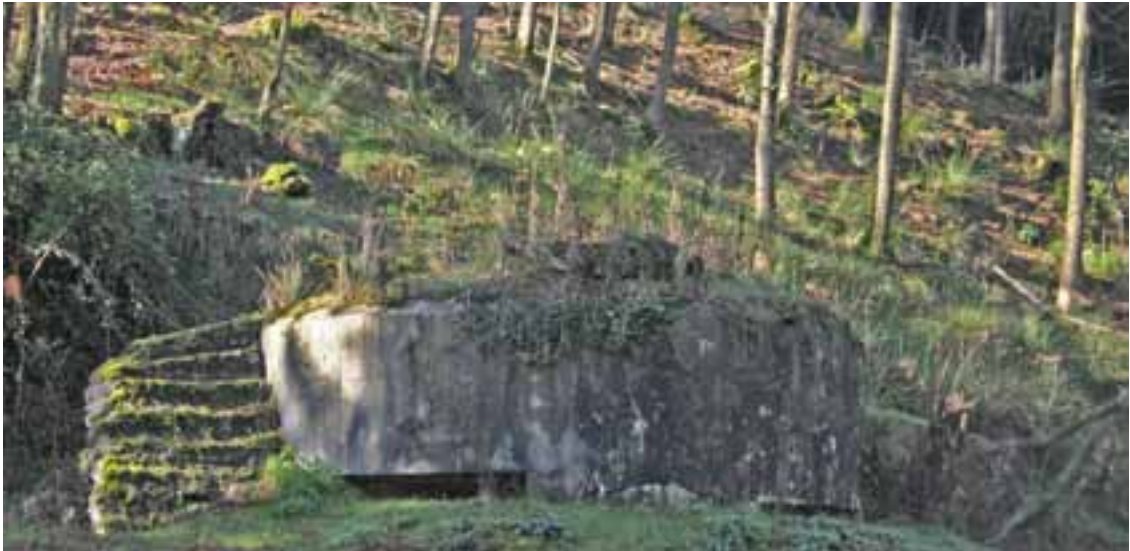
Fig. 65: Obra n. 24. Vista exterior del nido de ametralladora (Vid. fig. 42, letra F). Es claramente visible por no estar camuflado, debido a que es una obra inconclusa. Se aprecian también las alas laterales, escalonadas, realizadas en mampostería, destinadas a contener las tierras.
