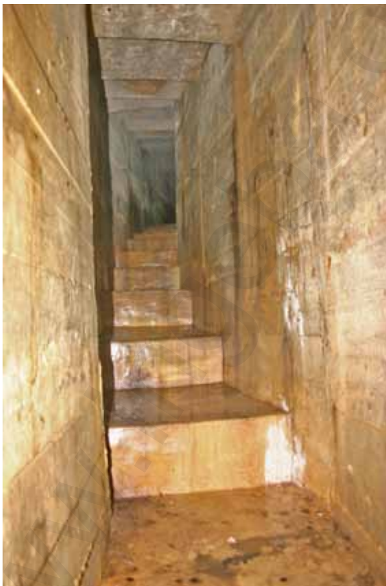
Fig. 7: Galería no abovedada de la obra n. 2.
