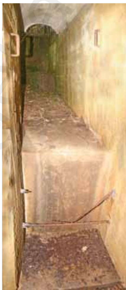
Fig. 53: Obra n. 3. Acceso al pozo para tirador (Fig. 22, letra J). Presenta una diferencia de cota de aprox. 1 m. que se salva mediante dos escalones formados por ferralla. Nótese también los dos asideros para ayudar a salvar los escalones.
