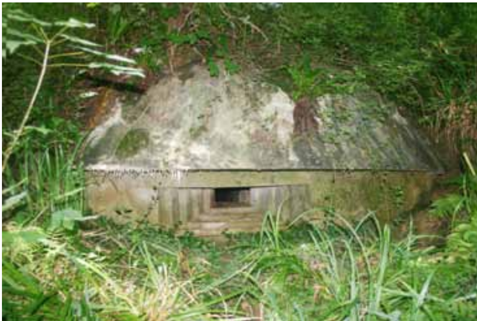
Fig. 13: Exterior de un nido de ametralladora de la obra n. 6. Puede apreciarse claramente la aspillera y el camuflaje de vegetación.
