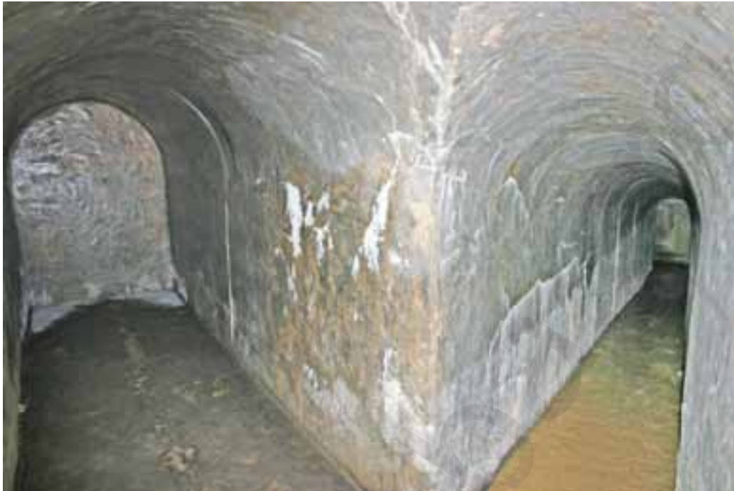
Fig. 33: O. defensiva n. 1. Obra n. 4. Depósito de municiones(izda.) y galería de acceso al nido x.
