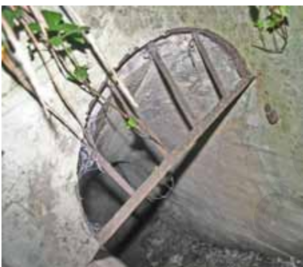
Fig. 56: Obra n. 6. Restos del cierre mediante verja de los pozos de tirador. Se ha conservado solamente la parte fija que cierra el sector superior,
