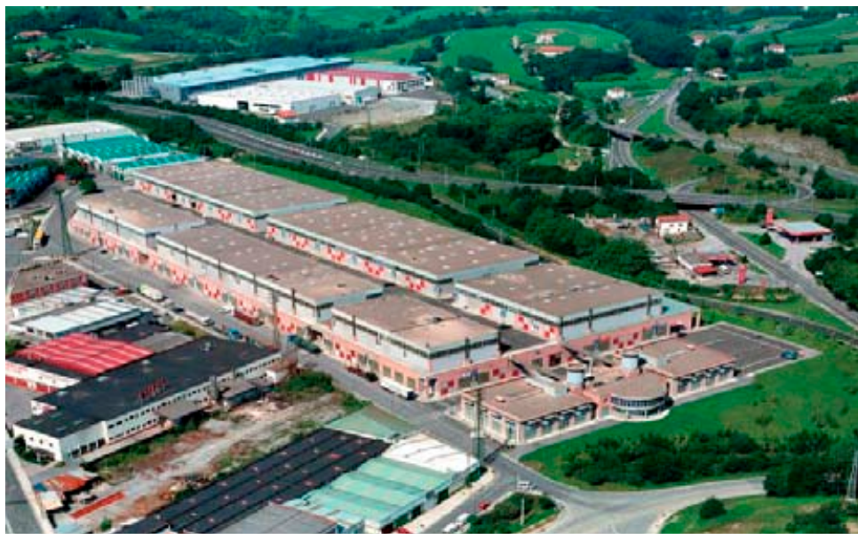
Vista aérea del industrialdea Gabiria-Ventas en Irun (Gipuzkoa).Fuente: Sprilur SA
